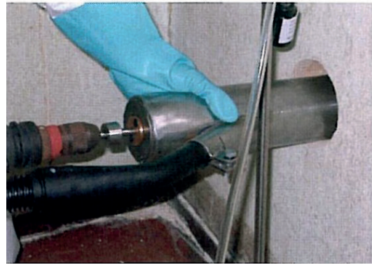
Bohrhülse KT1 mit Absaugstutzen und angeschlossener Absaugung im Einsatz
