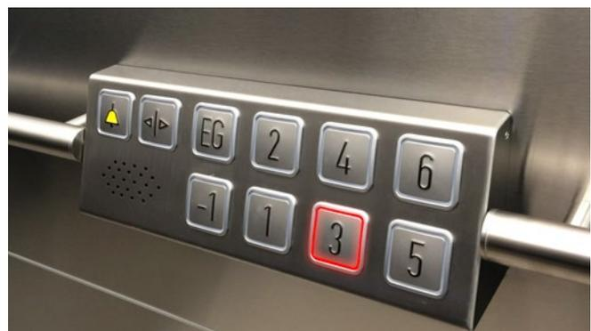
Abb. 8 Anordnung von Handlauf und Bedienelementen in Aufzugskabine
