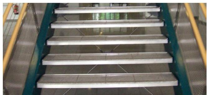
Abb. 2 Treppe ohne Setzstufe
