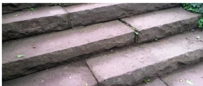
Abb. 16 Außentreppe mit erhöhtem Abrieb
