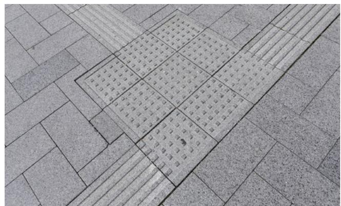
Abb. 10 Rippenstruktur zur Längsorientierung, Abzweigungsfeld in Noppenstruktur
