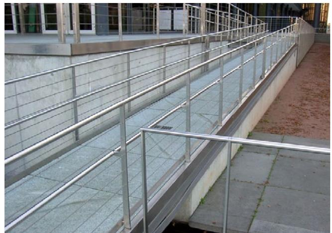
Abb. 7 Rampe im Außenbereich mit Betonplattenbelag
