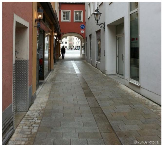
Abb. 13 Wechsel von Belagformaten
