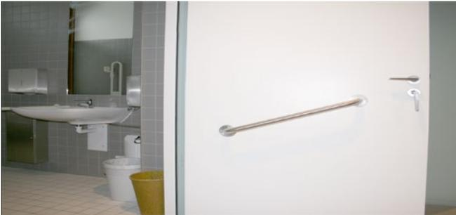
Abb. 5 Griffstange an der „Zuziehseite“ der Tür
