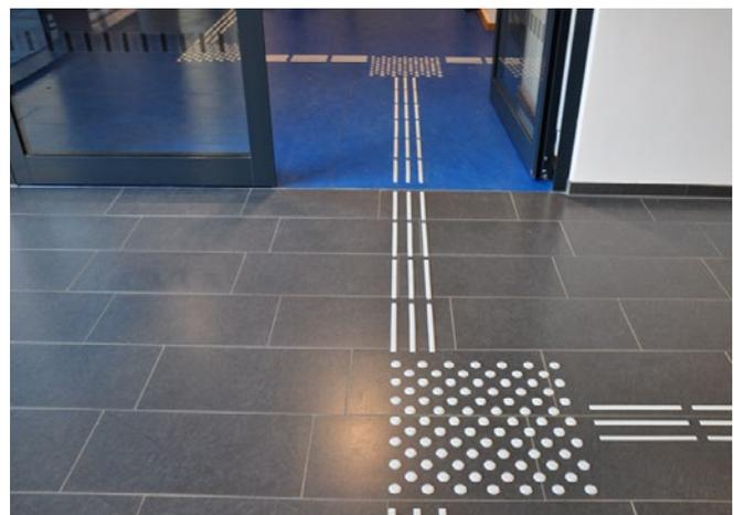
Abb. 9 Bodenindikatoren am Beispiel aufgeklebter Rippen und Noppen
