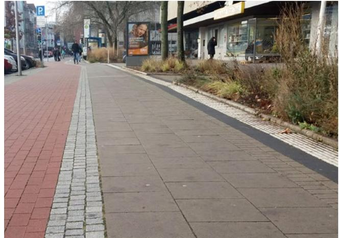
Abb. 7 Natürliche Leitsysteme in Form unterschiedlicher Bodenstrukturen und seitlicher Aufkantungungen
