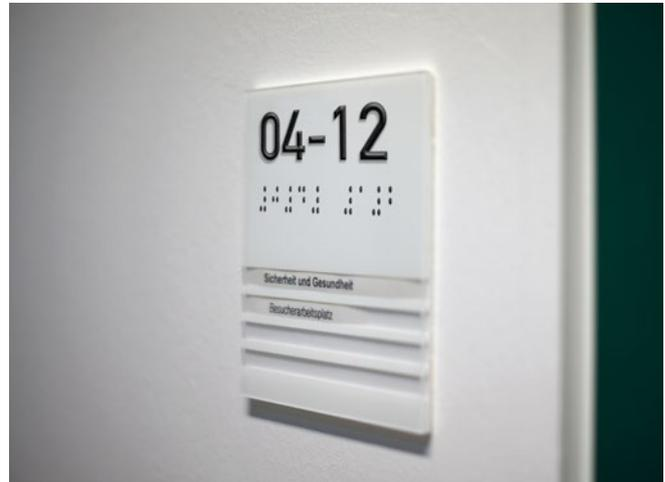
Abb. 2 Raumbezeichnung über erhabene Profilschrift mit maximalem Kontrast und Punktschrift
