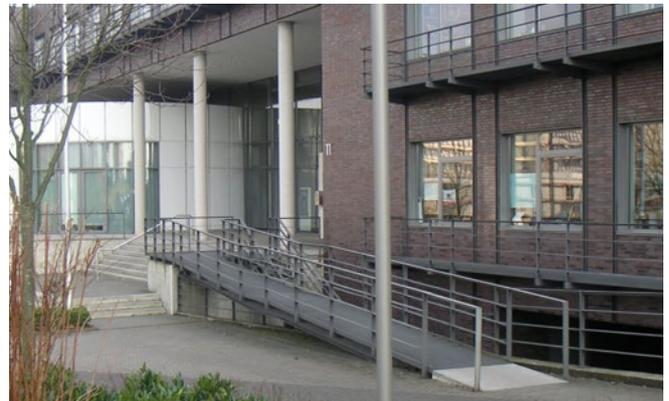
Abb. 4 Rampe im Außenbereich mit Gitterrostbelag
