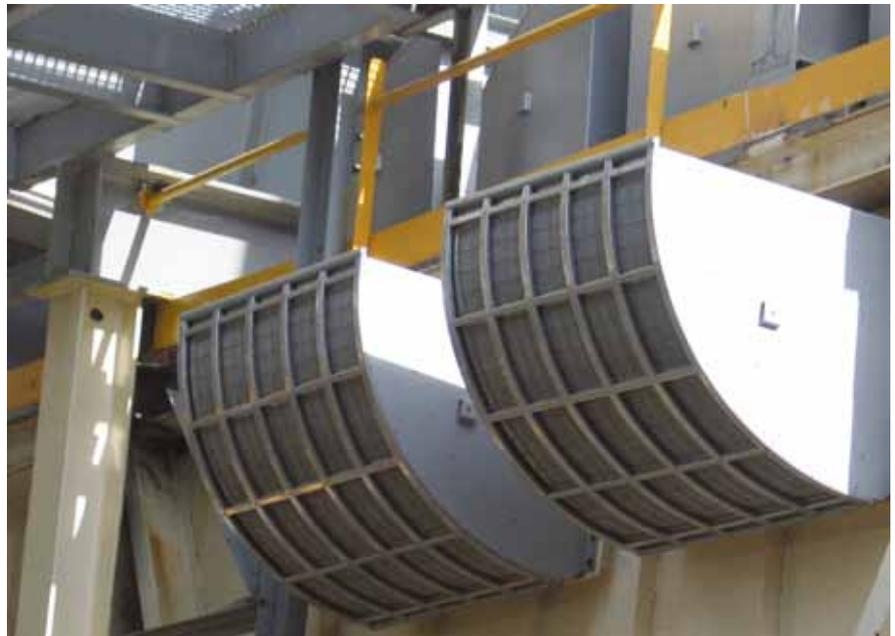
Explosionsdruckentlastung eines Spänesilos in der Spanplattenherstellung mit Q-Box
