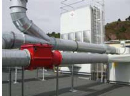
Wenn eine Rückschlagklappe die Funktion eines Entkoppelungssystems im Sinne der ATEX erfüllen soll, dann muss ihre Funktionsfähigkeit durch eine Prüfung nachgewiesen werden. Dies ist erforderlich, wenn nicht nur im Filter/Silo, sondern auch in der angrenzenden Rohrleitung explosionsfähige Atmosphäre angenommen werden muss (siehe Tabelle Seite 7).
