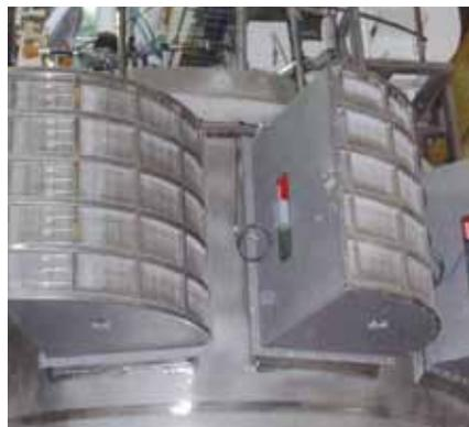
Explosionsdruckentlastung eines Silos mit Q-Box
