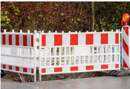
Absicherung einer Grube
