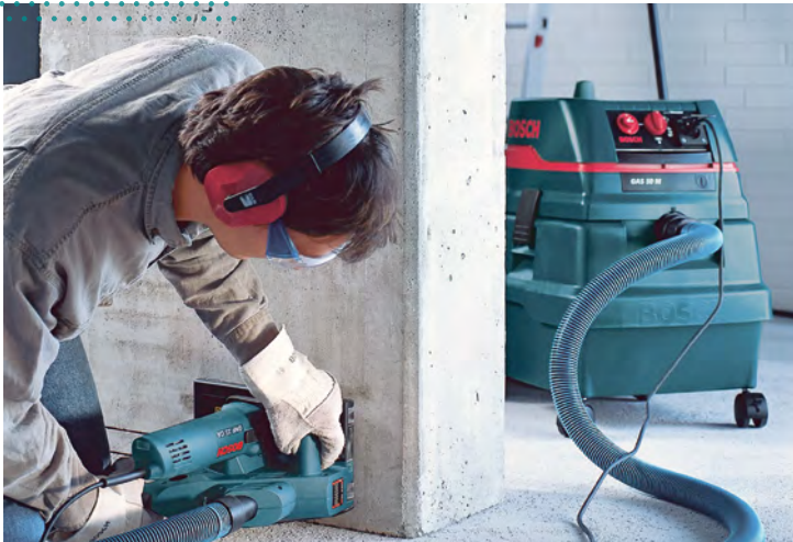
Mauernutfräse mit Staubabsaugung
