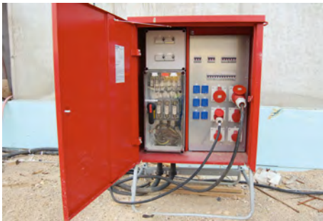
Baustromverteilerschrank
