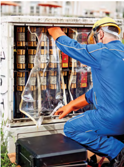
Abdecken benachbarter, unter Spannung stehender Teile
