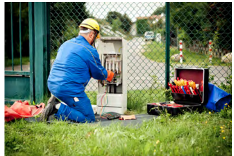
Rechts im Bild: Werkzeugtasche mit isoliertem Werkzeug für das Arbeiten an unter Spannung stehenden Teilen
