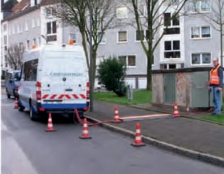
3.3.2 Bild 1 Kabelverlegung quer über einen Gehweg, Kennzeichnung mit Leitkegeln
