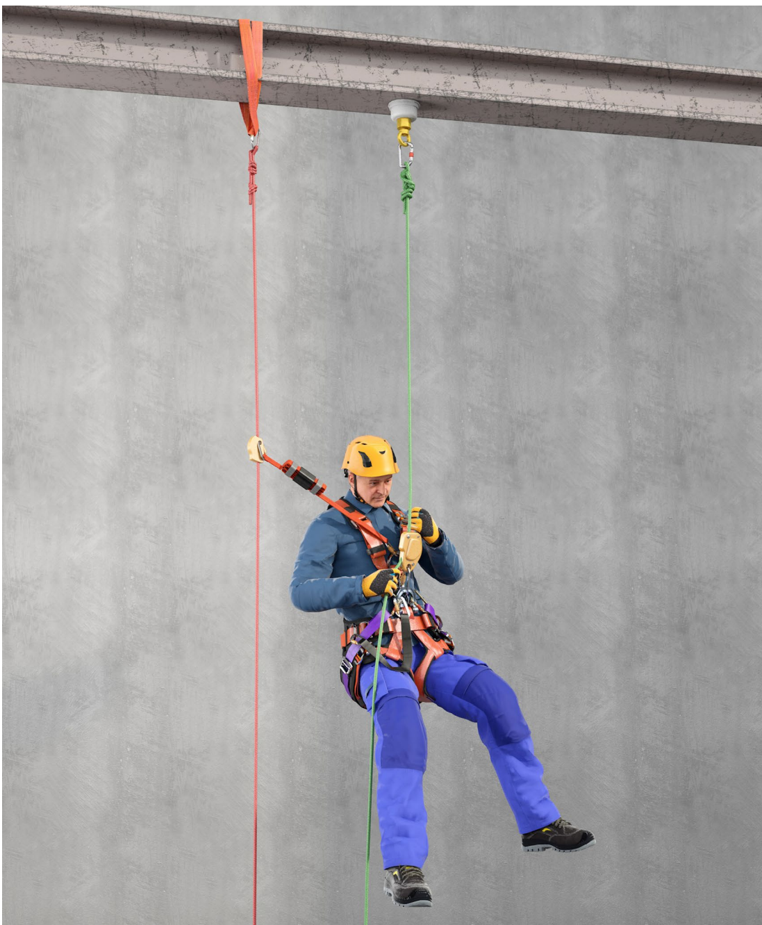
Abb.1 Unabhängig voneinander angeschlagenes Tragseil (hier grün) und Sicherungsseil (hier rot).
