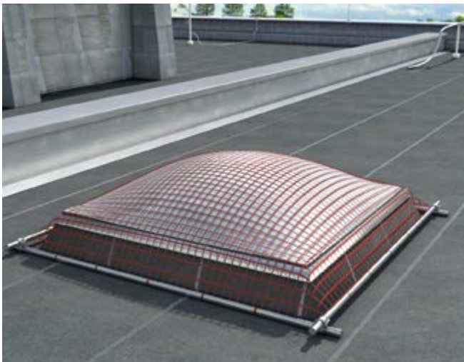
Abb. 8 Lichtkuppel ist ausreichend gegen Durchsturz gesichert. Der Rahmen muss immer alle vier Seiten umschließen und die Stangen müssen miteinander fest verbunden (verschraubt) sein
