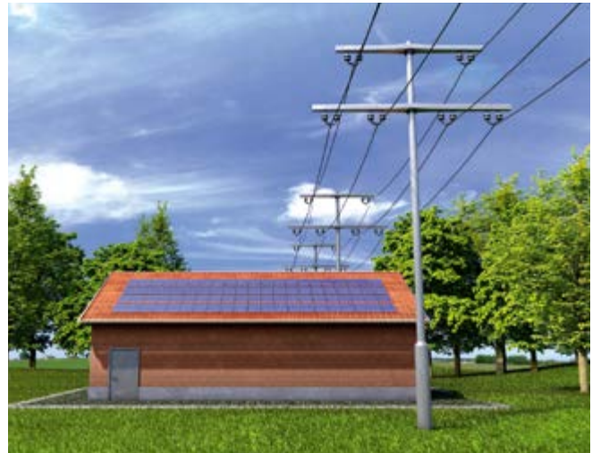
Abb. 22 PV-Anlage, für die Schutzmaßnahmen gemäß den Arbeiten in der Nähe unter Spannung stehender Teile anzuwenden sind
