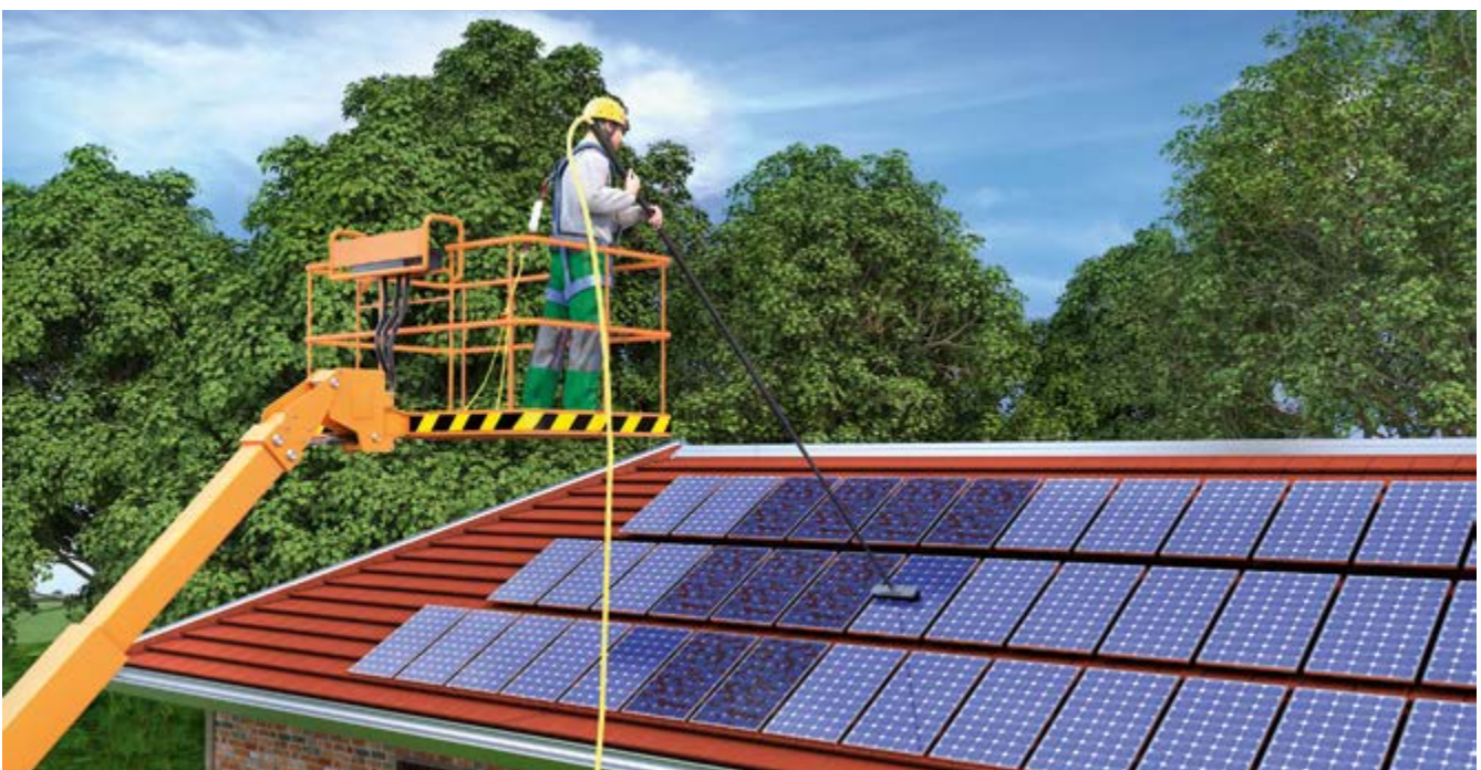
Abb. 28 Reinigung einer PV-Anlage von einer Hubarbeitsbühne aus
