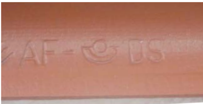
Abb. 9 Prägestempel einer Faserzementwellplatte, DS = Durchsturz sicher, AF = Asbestfrei
