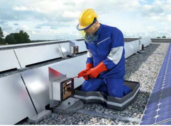
Abb. 17 Arbeiten unter Spannung mit PSA ausführen
