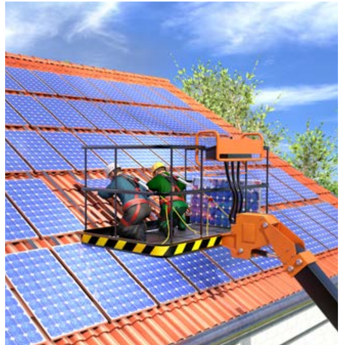
Abb. 7 Beispiel für Arbeiten von einer mobilen Arbeitsbühne aus
