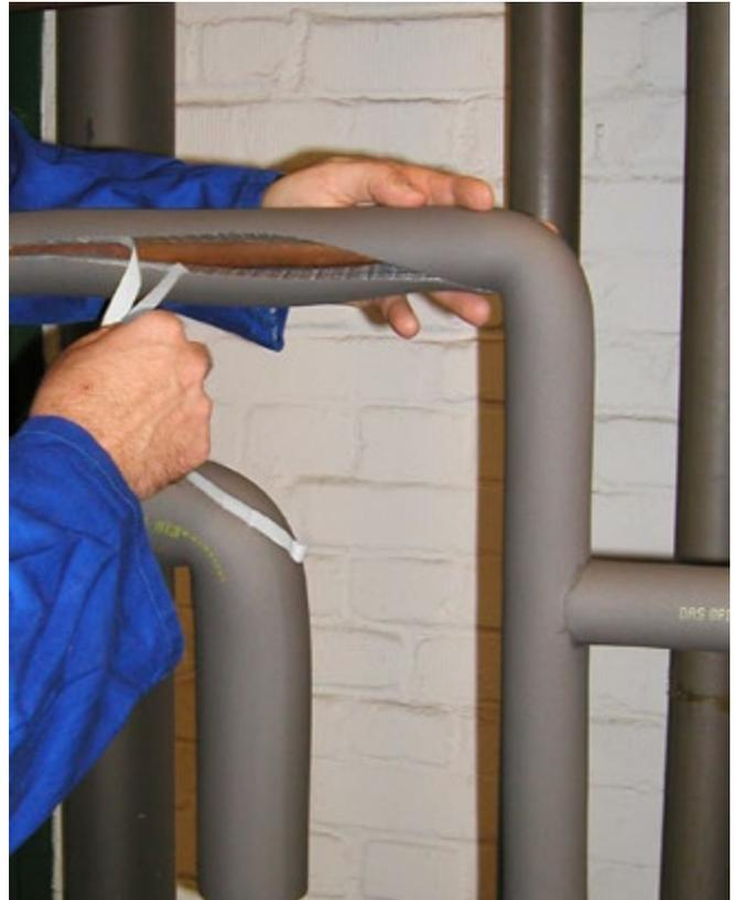
Abb. 1 Verwendung selbstklebender Materialien – minimale Lösemittelexposition
