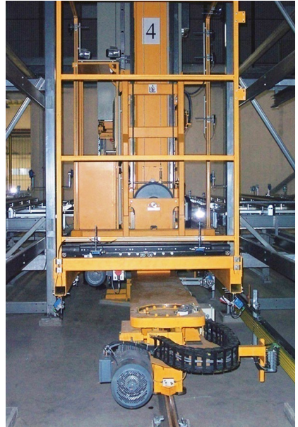
Abb. 10 Absturz zur Gasse hin (aus der Bildebene heraus) konstruktiv verhindert
