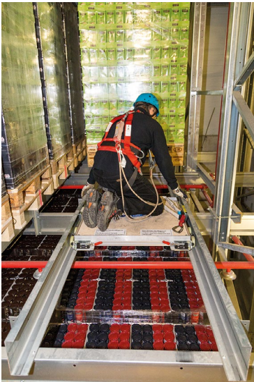
Abb. 19 Einfahrt in den Kanal
