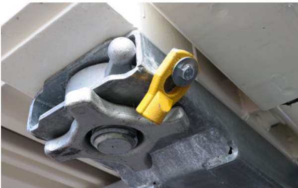
Abb. 28 Spannmutter mit der Fallsicherung gesichert
