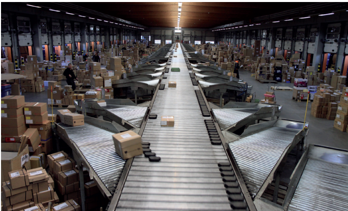
Bild 11a Moderne Sortierhallen mit zentraler Bandanlage und Andocköffnungen an beiden Hallenseiten
