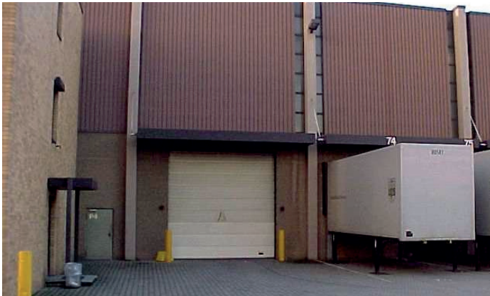
Bild 7 Andocköffnungen neben Ein- und Ausfahrttor Tor und Andocköffnungen sollen während des Andockvorganges geschlossen bleiben (Vermeidung des Eindringens von DME in die Halle).
