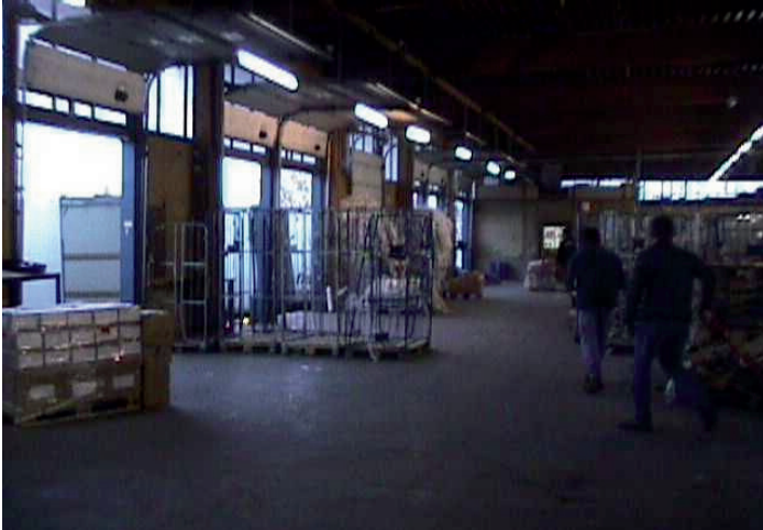
Bild 6 Andocköffnungen, teilweise zu Lüftungszwecken geöffnet
