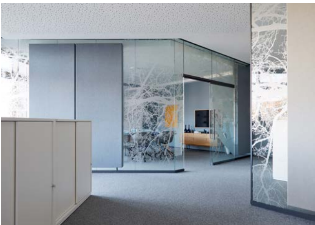
Abb. 21 Schalldämmende und -absorbierende Trennwände
