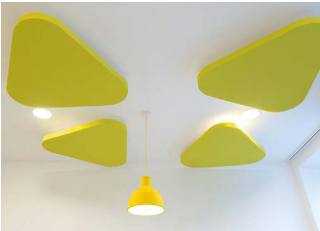
Abb. 16 Schallabsorbierende Deckensegel
