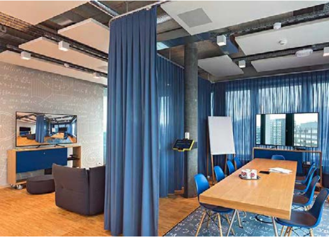
Abb. 32 Schallabsorbierende und schalldämmende Textilien
