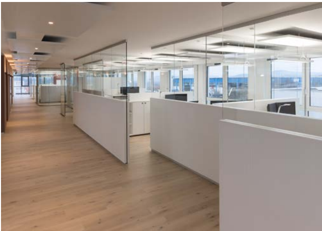
Abb. 20 Schalldämmende und -absorbierende Trennwände
