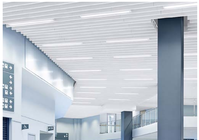
Abb. 14 Schallabsorbierende Baffeldecke
