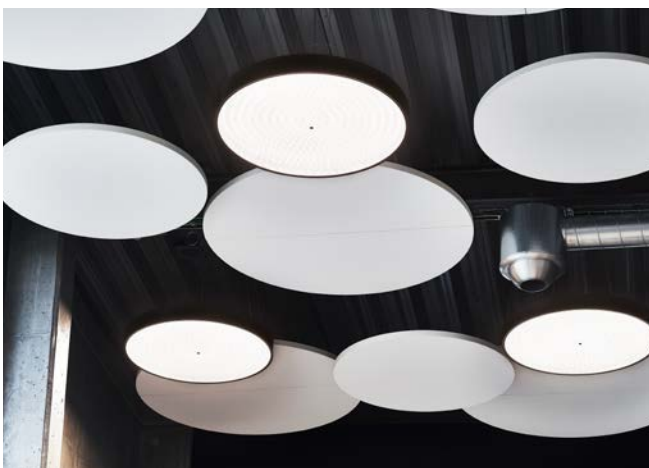
Abb. 17 Schallabsorbierende Deckensegel
