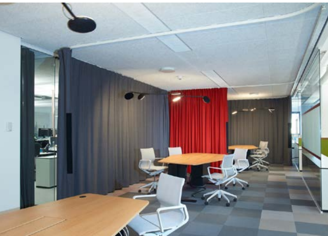
Abb. 33 Schallabsorbierende und schalldämmende Textilien
