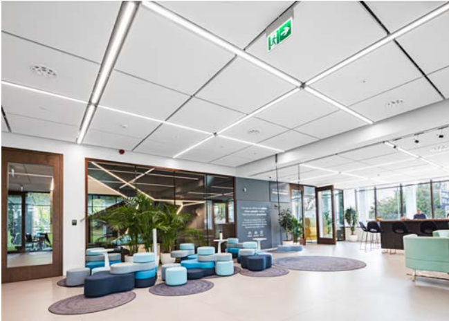
Abb. 12 Schallabsorbierende Akustikdecke mit Fugen
