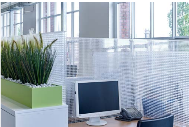
Abb. 23 Schallabsorbierende und schallschirmende Stellwände
