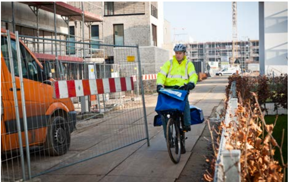
Abb. 3 Gefahr im Baustellenbereich
