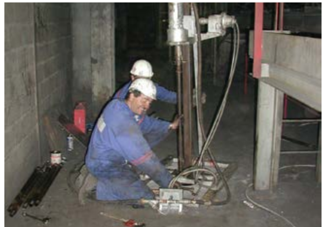
Abb. 8.3 Im Dach zum Speicherraum angesetzte Bohreinrichtung
