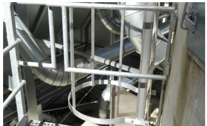
Abb. 5.10 und 5.11 Steigleiter nach ASR 1.8, Nr. 4.6
