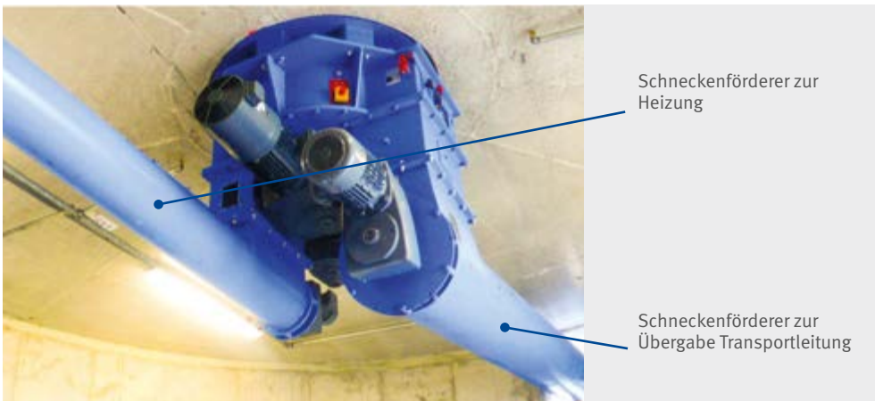
Abb. 6.17 Austragung mit 2 getrennten Übergabestellen
