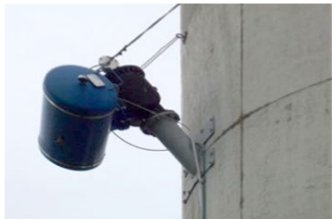
Abb. 8.2 Beispiel für eine am Silokörper montierte Druckluftkanone
