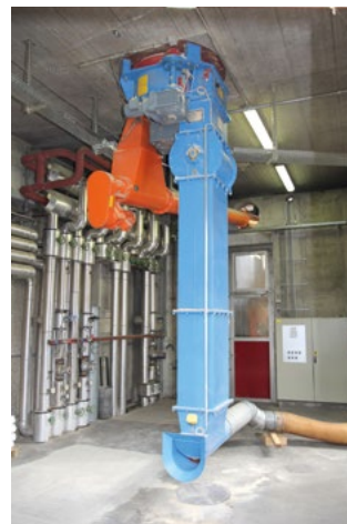
Abb. 7.10 Späneentnahme über Anschluss an gesonderten Entnahmestutzen
