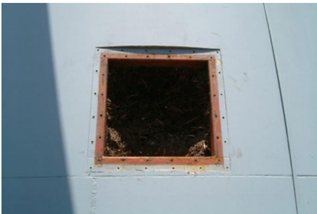
Abb. 8.9 Vorgefertigte Öffnung für den Einsatz eines Notentleerungssystems
