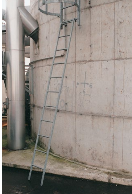
Abb. 5.13 Steigleiterzugang mit einhängbarer Anlegeleiter
