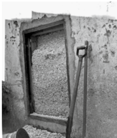
Entnahmeöffnung: Nach dem Öffnen der Tür bleibt die Späne-Wand bestehen
