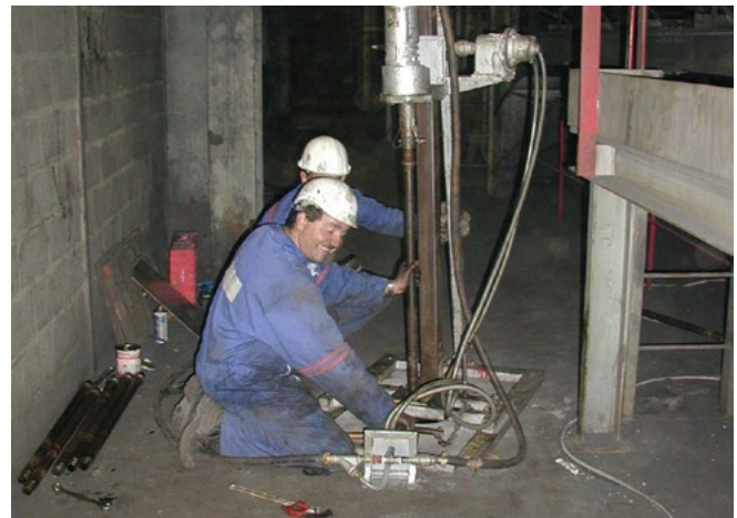
Abb. 8.3 Im Dach zum Speicherraum angesetzte Bohreinrichtung
