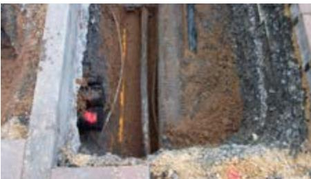
Abb. 7 Baugrube mit Fremdanlagen
