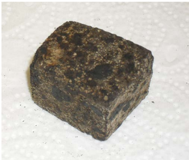
Abgelöster Bodenbelag mit Resten von teerhaltigem Kleber
