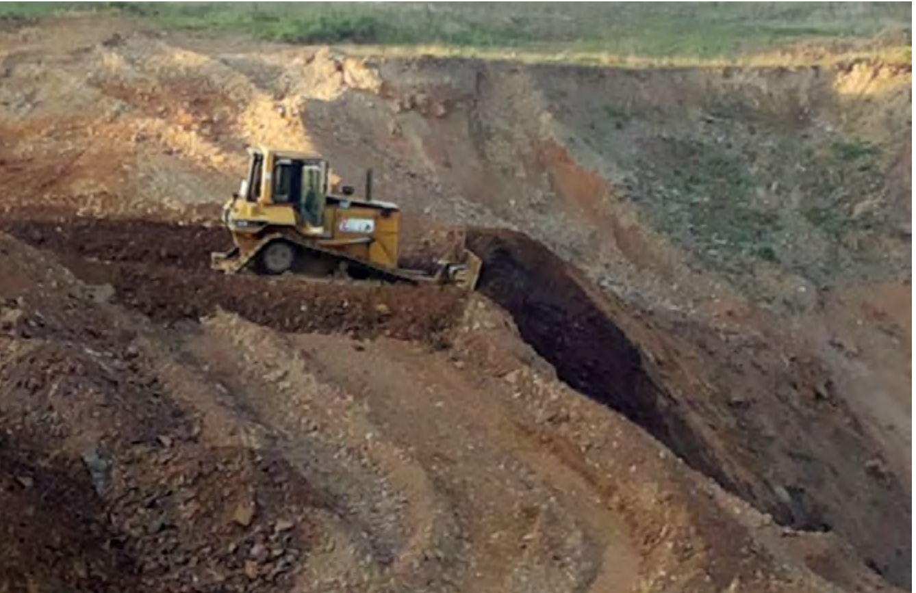
Abb. 1 Abschieben des abgekippten Materials mit einer Raupe
