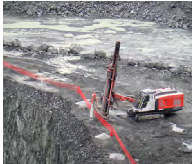
Abb. 3 Herstellung der Wandneigung durch Bohrarbeiten
