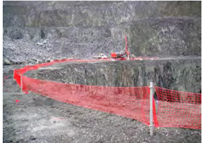
Abb. 2 Großbohrlochmaschine bei der Erstellung von Bohrlöchern mit Absicherung des Arbeits- und Verkehrsbereichs
