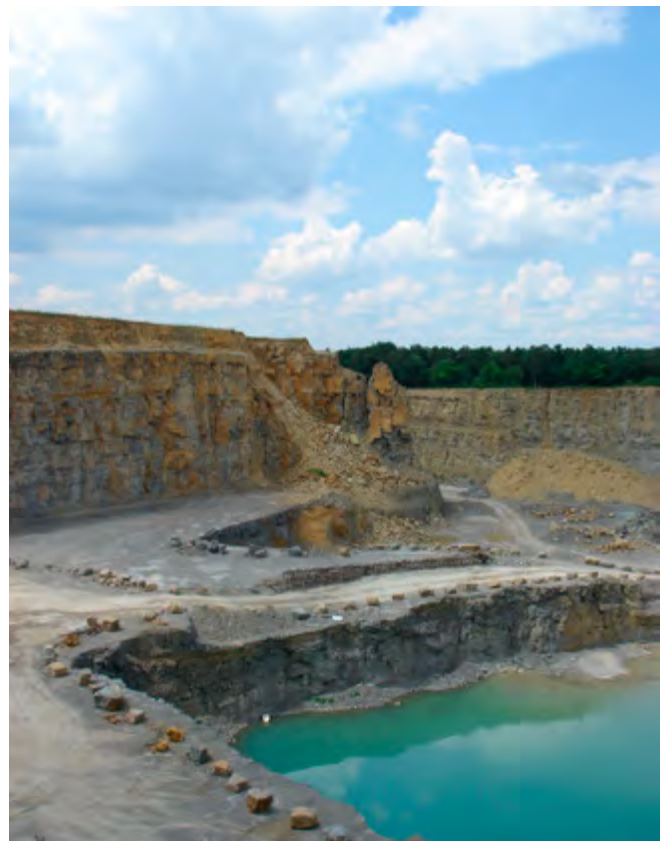
Abb. 1 Mit Freisteinen gegen Überfahren gesicherte Bruchkante
