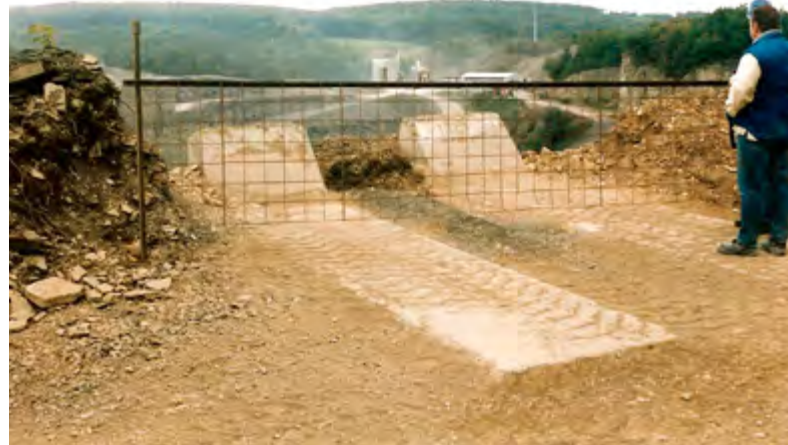
Abb. 2 Stationäre Abkipfstelle mit festen Anschlägen
