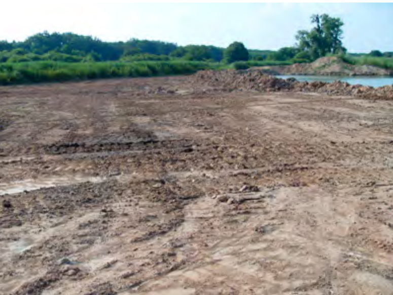
Abb. 1 Abraumbeseitigung für die Kiesgewinnung
