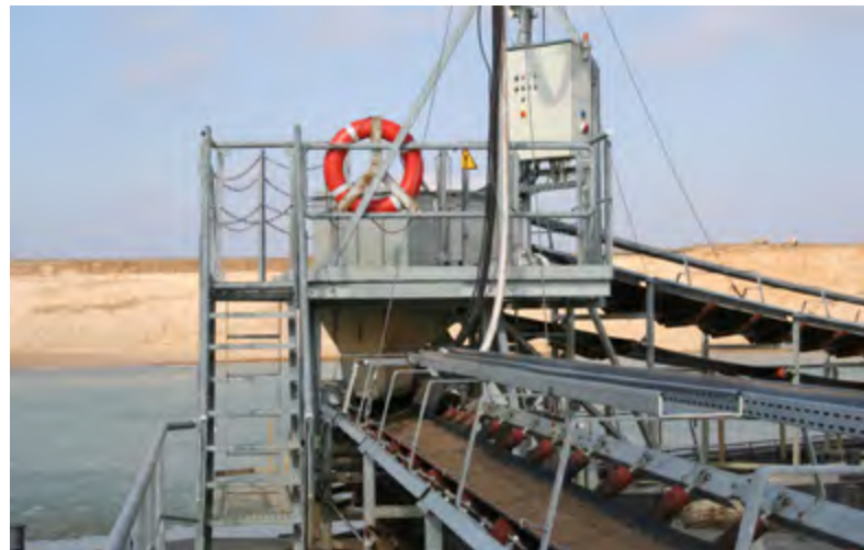
Abb. 1 Sichere Verkehrswege auf schwimmendem Gerät
