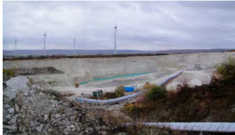
Abb. 2 Abgedecktes Landband zum Schutz vor Witterungseinflüssen
