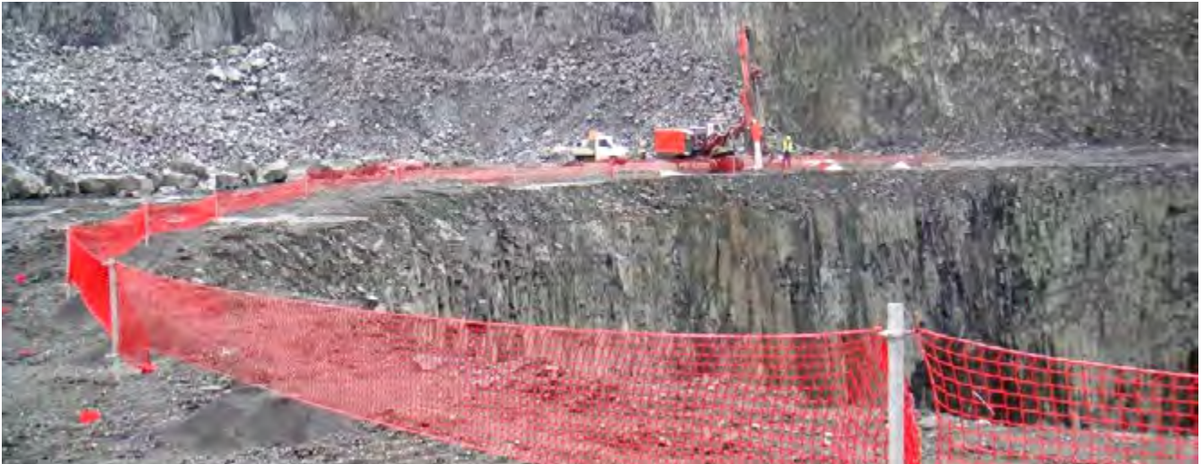
Abb. 2 Absturzsicherung im Arbeitsbereich einer Bruchwand
