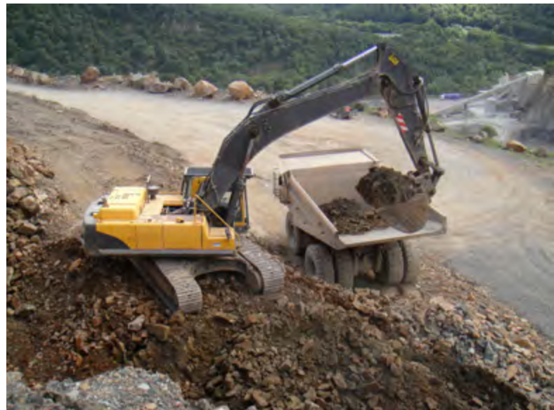
Abb. 2 Beladen mit einem Tiefenlofbagger von der erhöhten Arbeitsfläche
