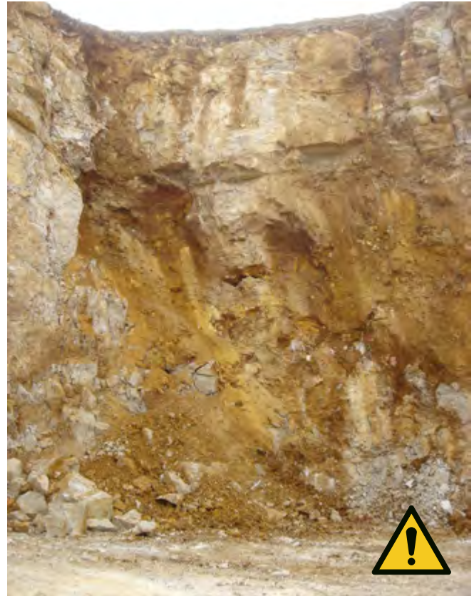
Abb. 2 Gefährdungen im Bereich der Bruchwand durch Unterhöhlung
