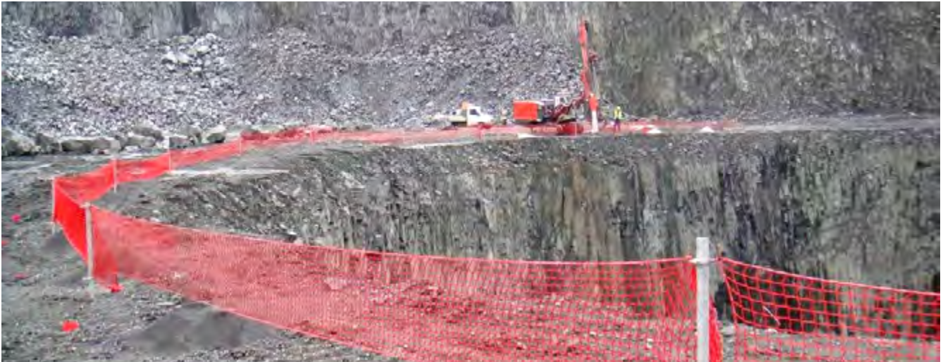
Abb. 2 Absturzsicherung im Arbeitsbereich einer Bruchwand
