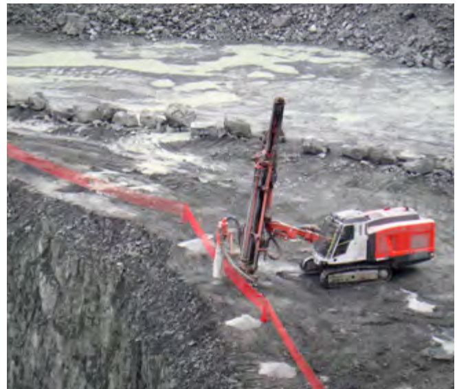
Abb. 3 Herstellung der Wandneigung durch Bohrarbeiten
