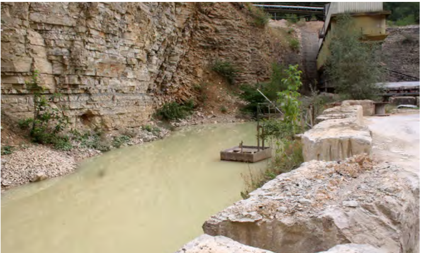
Abb. 1 Absetzbecken mit Rohblöcken als Randsicherung
