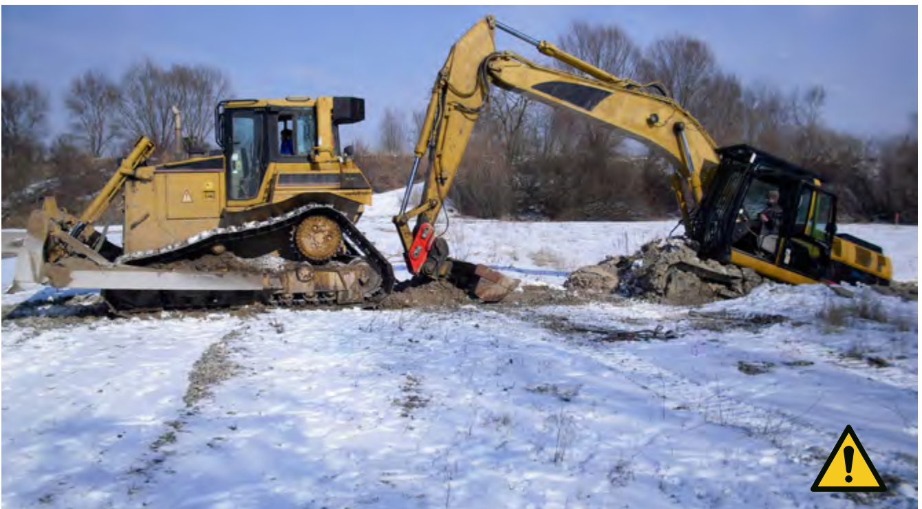
Abb. 2 Einsinken von Maschinen in nicht verfestigtem Material
