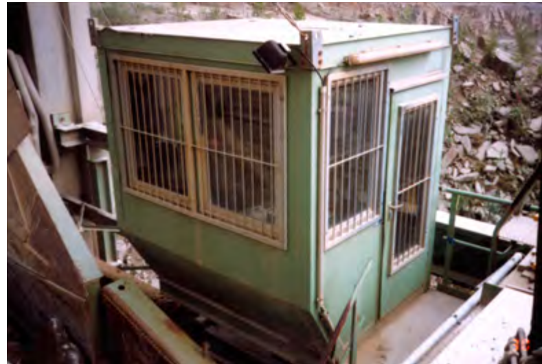
Abb. 1 Brecherkabine schützt vor Lärm, Staub und Steinflug
