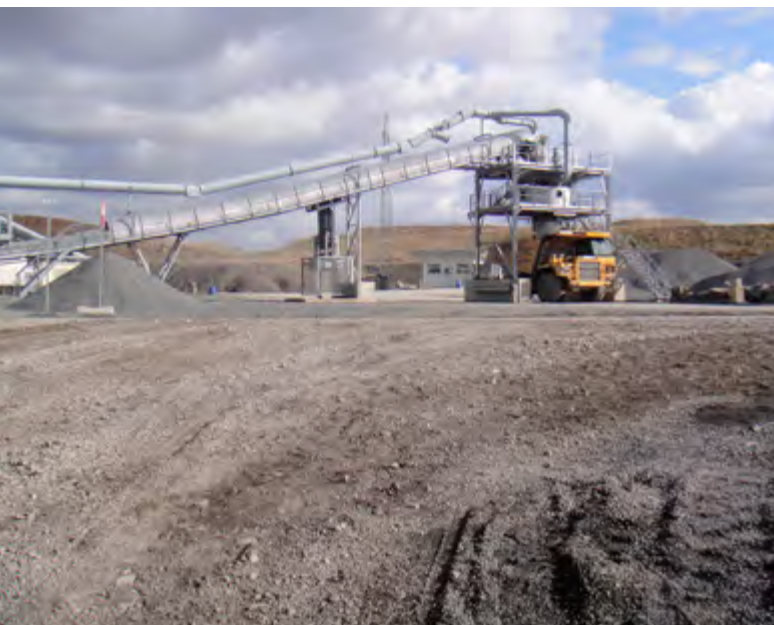
Abb. 1 Verladestelle für Schüttgütern mit Staubabsaugung
