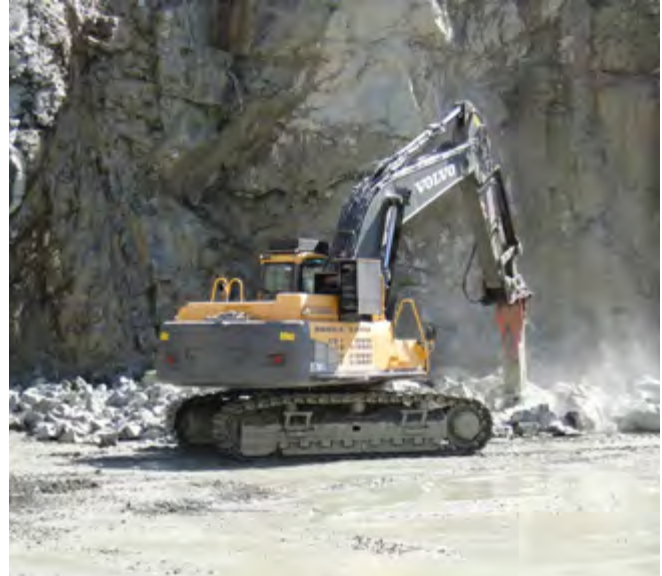
Abb. 2 Nachzerkleinerung mit einem Hydraulikhammer
