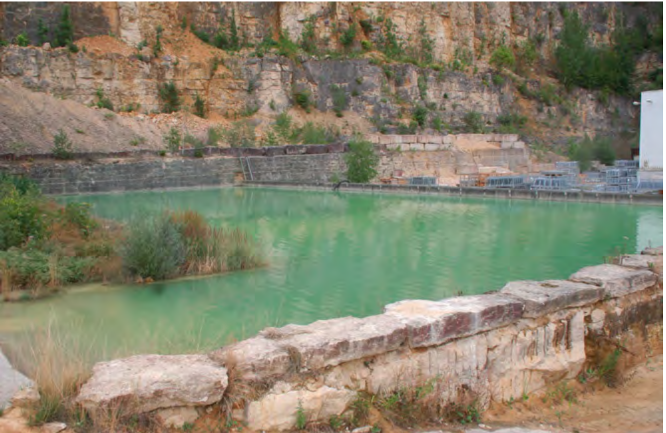
Abb. 1 Absetzbecken mit Absturzsicherung
