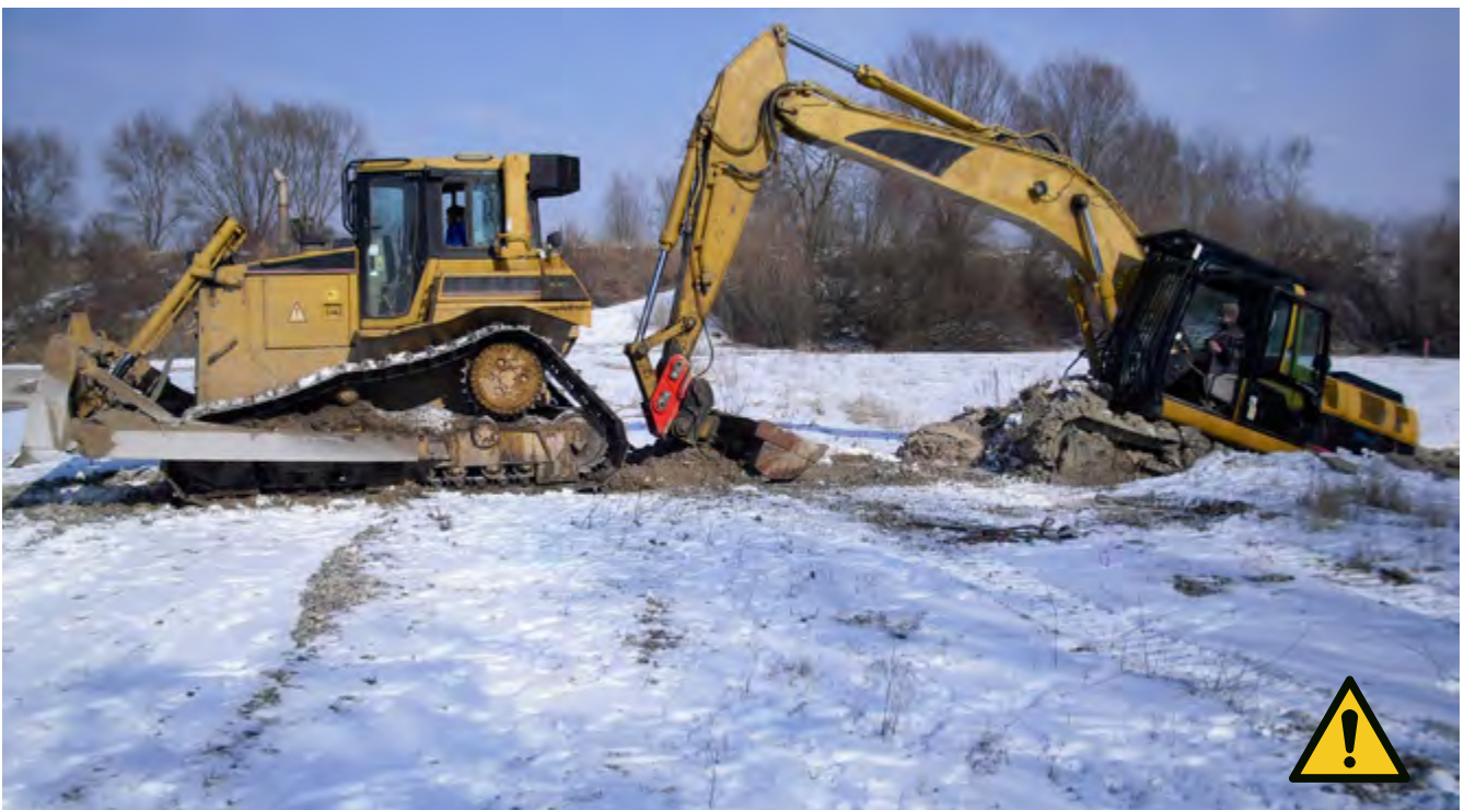
Abb. 2 Einsinken von Maschinen in nicht verfestigtem Material
