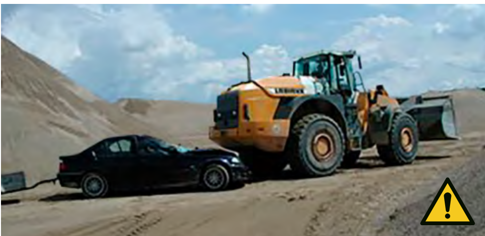
Abb. 3 Lebensgefährliche Situation: Sichteinschränkung bei Großgeräten
