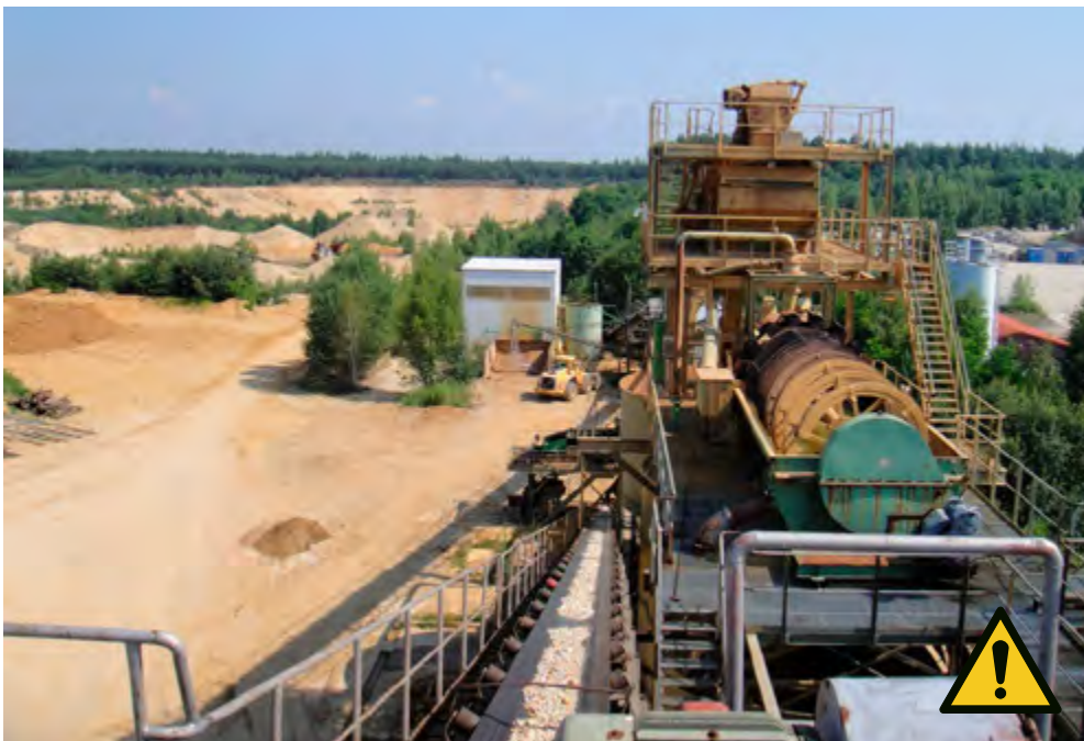
Abb. 2 Achtung: Quetsch- und Scherstellen an Schwertwäsche sind zu sichern
