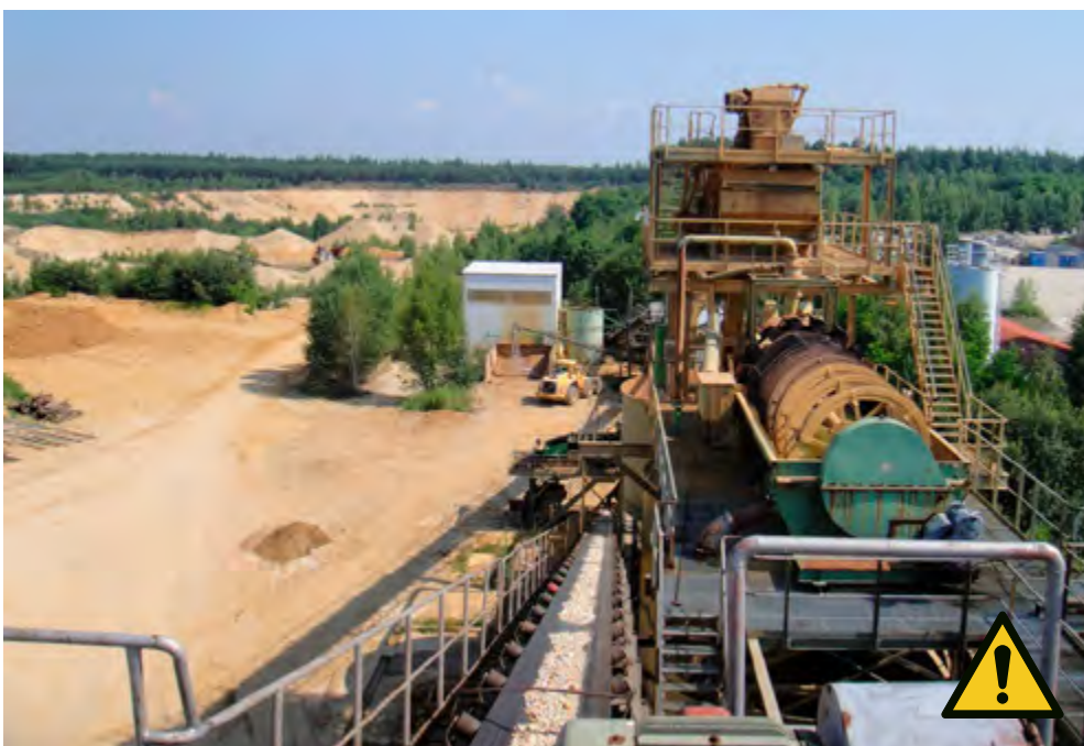
Abb. 2 Achtung: Quetsch- und Scherstellen an Schwertwäsche sind zu sichern
