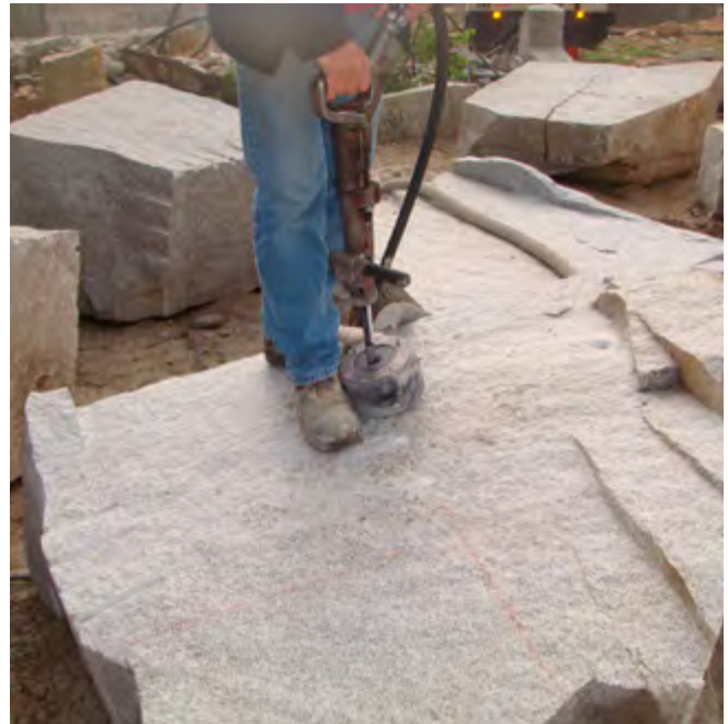
Abb. 2 Arbeiten auf dem Rohblock mit Absaugung
