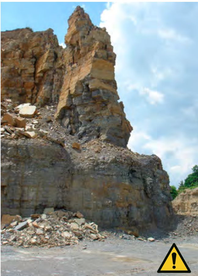
Abb. 2 So nicht! Gefahr durch abstürzende Steine und Massen
