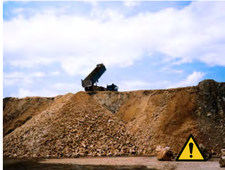
Abb. 3 Absturzgefahr beim Abkippen
