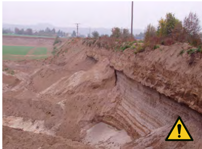
Abb. 2 So nicht! Fehlender Schutzstreifen nach der Abraumbeseitigung
