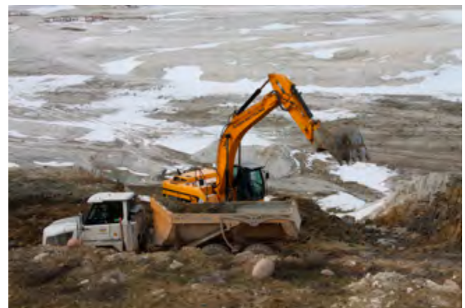
Abb. 4 Abräumbeseitigung bei der Lehm- und Tongewinnung
