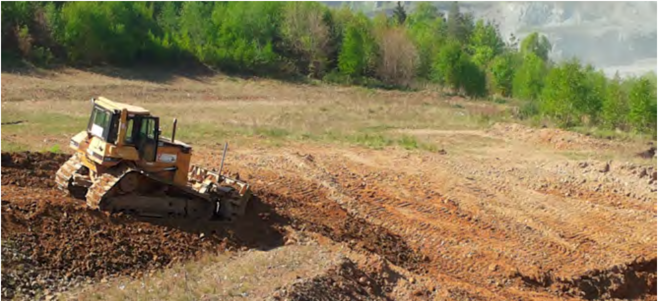
Abb. 1 Regelkonformes Abschieben von Abraum mit einer Raupe
