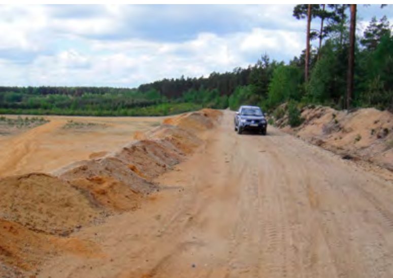
Abb. 2 mit Wall abgesicherte Fahrstraße bei der Sandgewinnung
