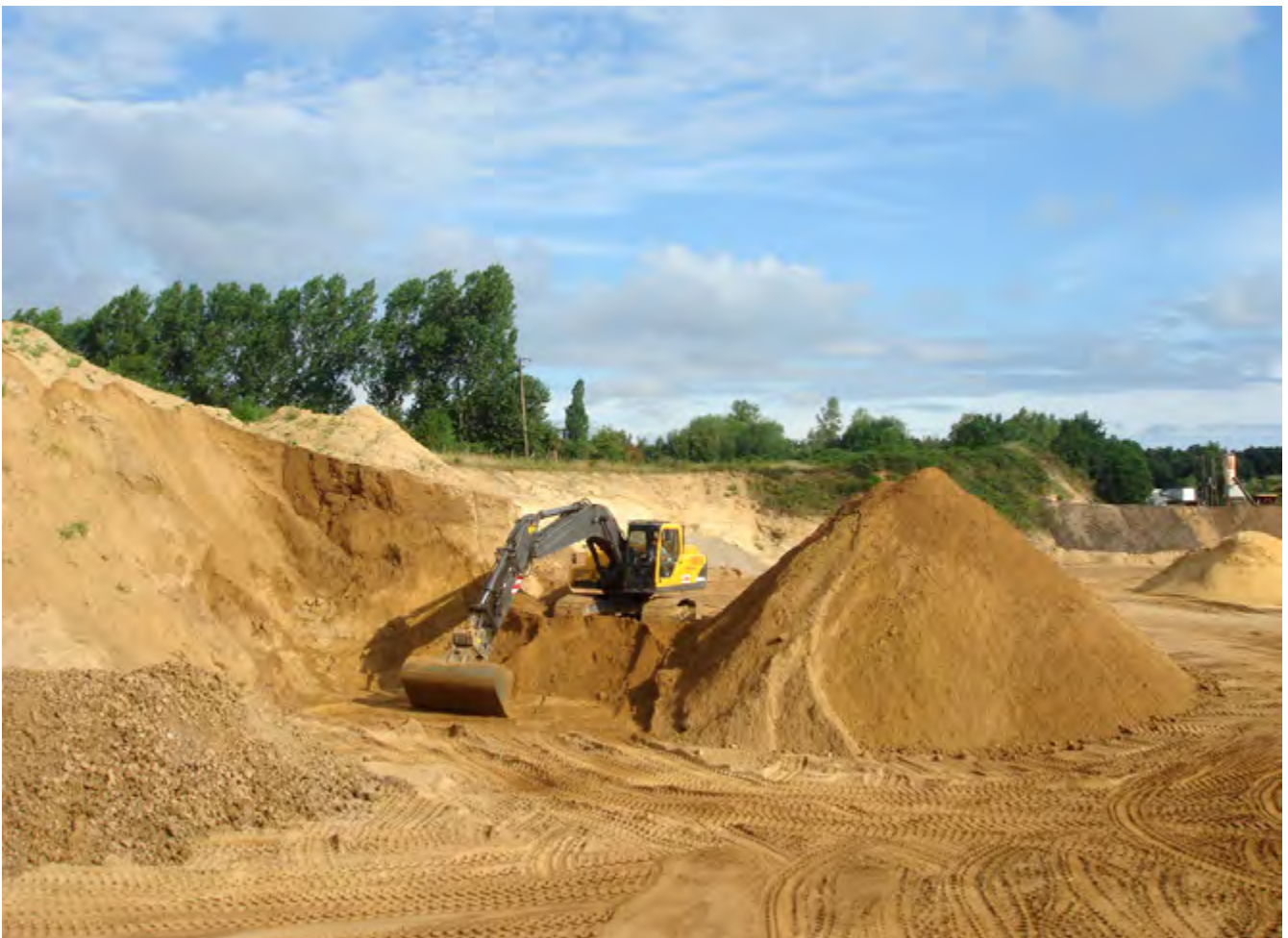
Abb. 2 Gewinnung im Tiefschnitt mit einem Hydraulikbagger
