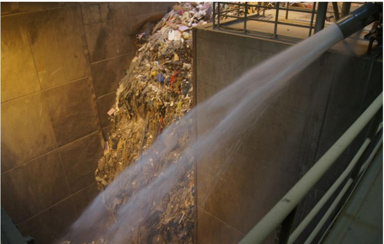
Abb. 14 Demonstration einer stationären Löschanlage im Müllbunker
