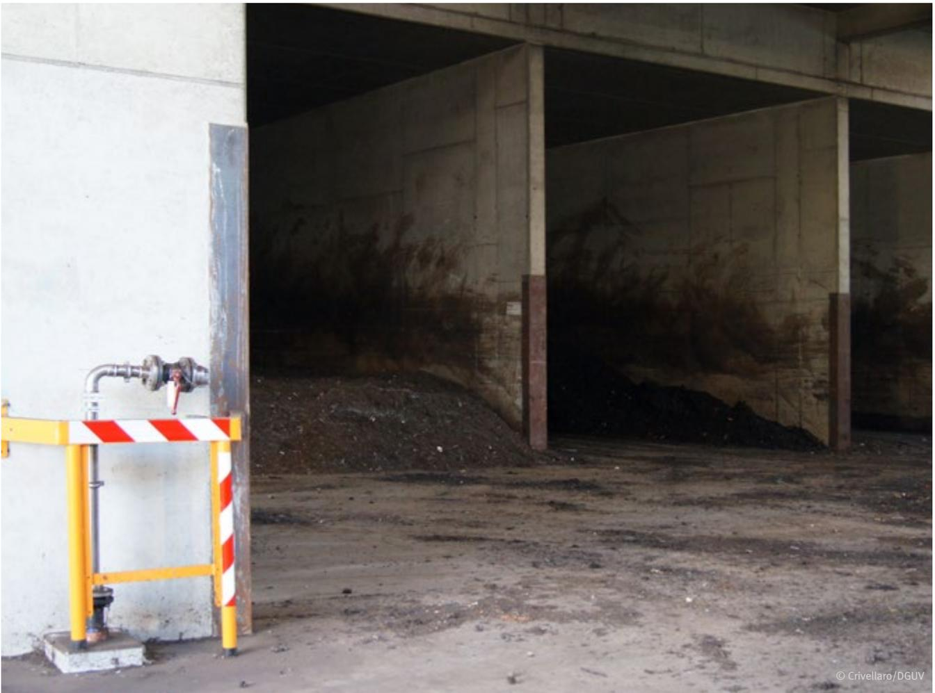
Abb.21 Belüftungsboxen für feste Gärreste mit Schlitzboden
