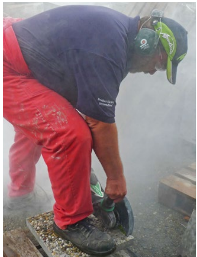
Abb. 18 Trennen von Betonplatten und Winkelschleifer
