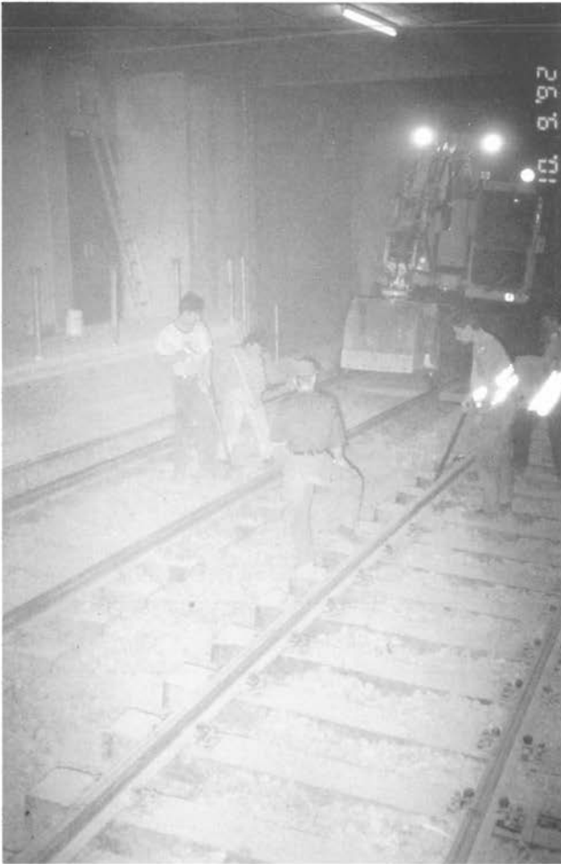
Abbildung 17: Arbeit mit der Schottergabel (A 48, A 49, A 50)
