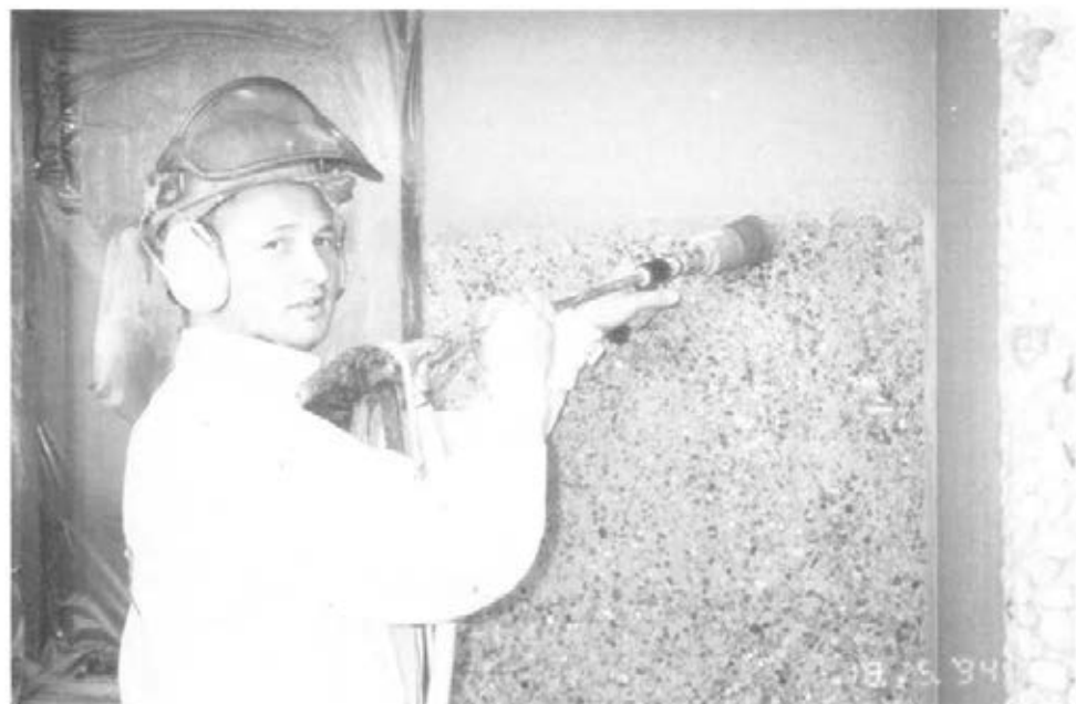
Abbildung 51: Alte Fassadenbeschichtung durch Hochdruckwasserstrahlen entfernen (E 79)
