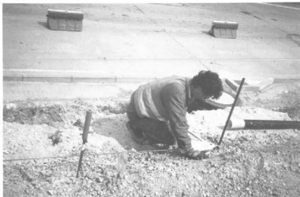
Abbildung 18: Fertigerleitdraht spannen (C3 23)
