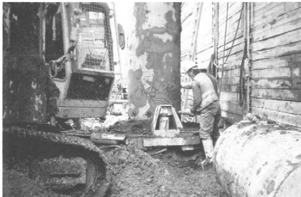
Abbildung 49: Hüllrohrsegment montieren (D 51)
