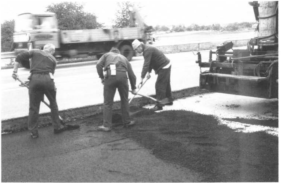
Abbildung 26: Schwarzdeckenhandeinbau (C2 24)
