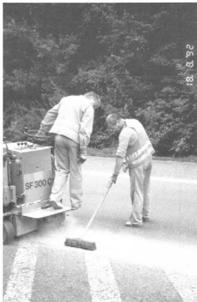
Abbildung 1: Mitgänger an der Straßenfräse (C4 1)
