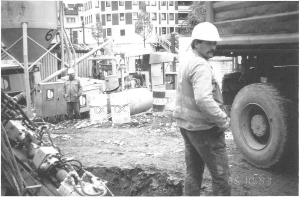
Abbildung 42: Ankerbohrung neben der Baustelleneinfahrt überwachen (D 38)
