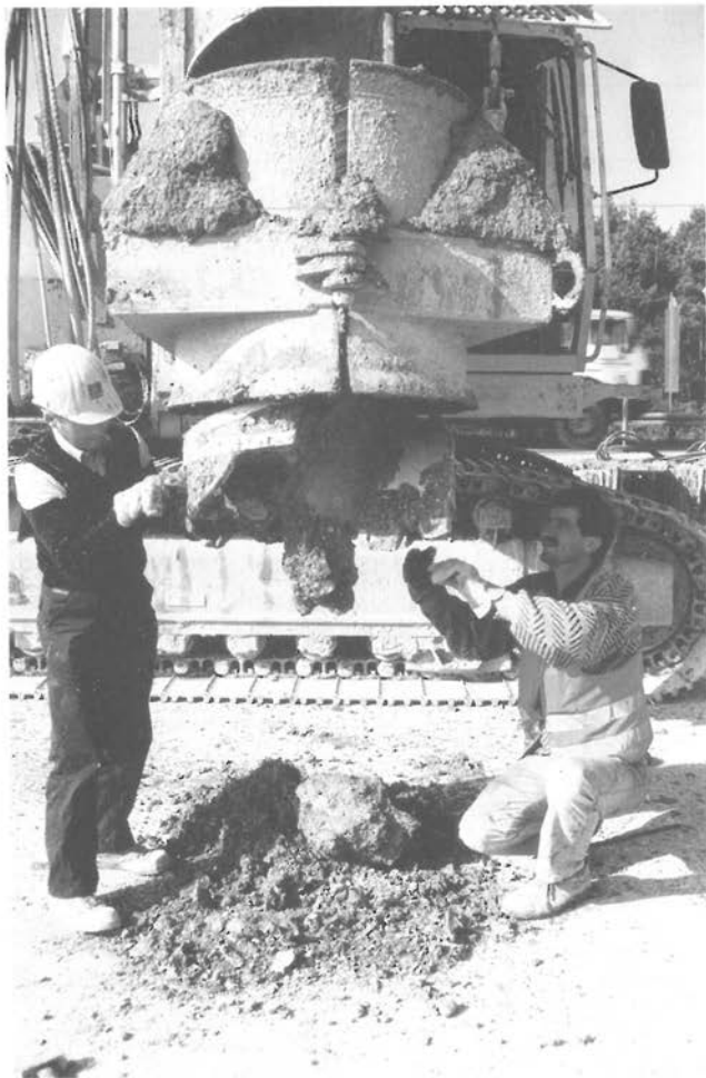
Abbildung 19: Bohrmeißel auswechseln (D 6)
