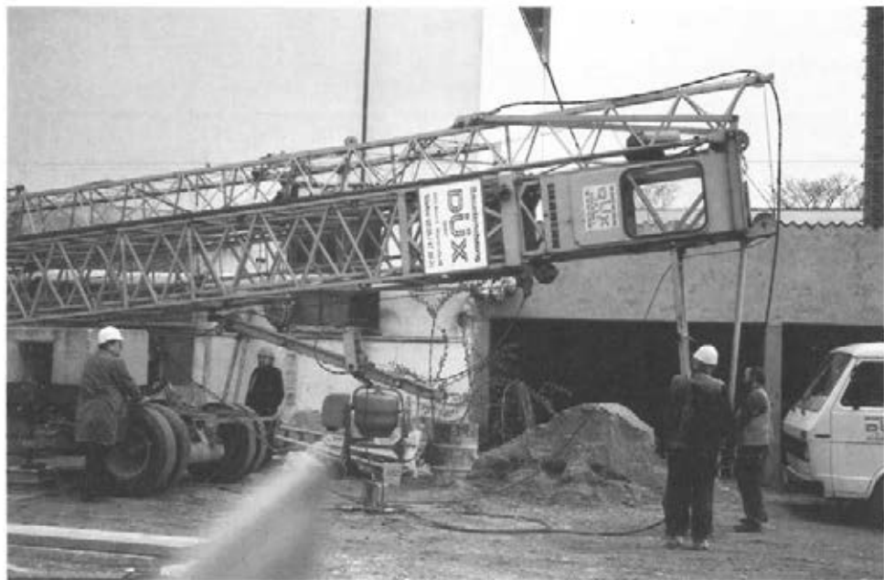
Abbildung 18: Baukranaufstellung (B 54)
