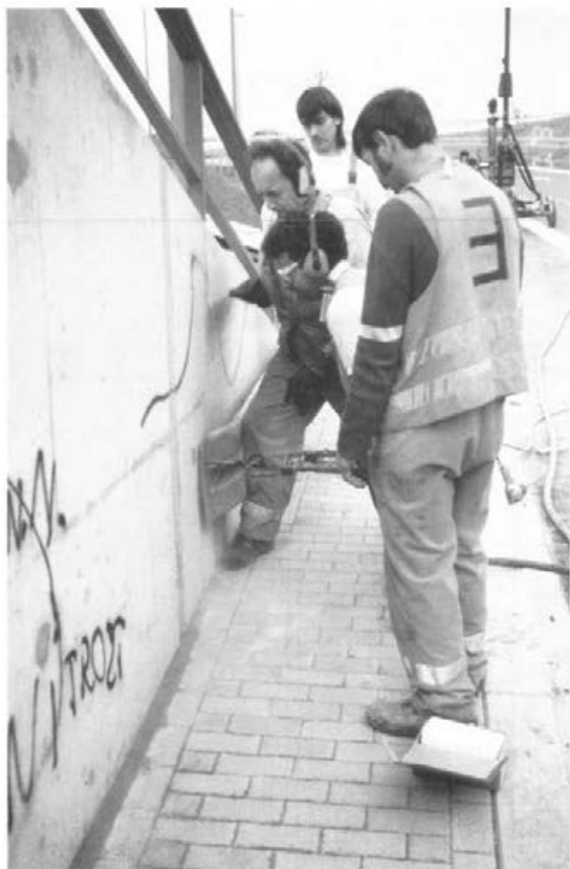
Abbildung 11: Dübellöcher bohren (C5 11)
