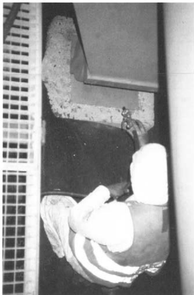
Abbildung 53: Abblasen des Strahlrückstandes (E 82)
