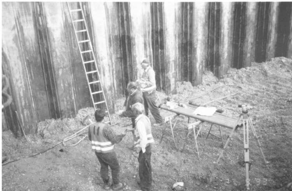
Abbildung 26: Ankerlöcher einmessen (D 17)
