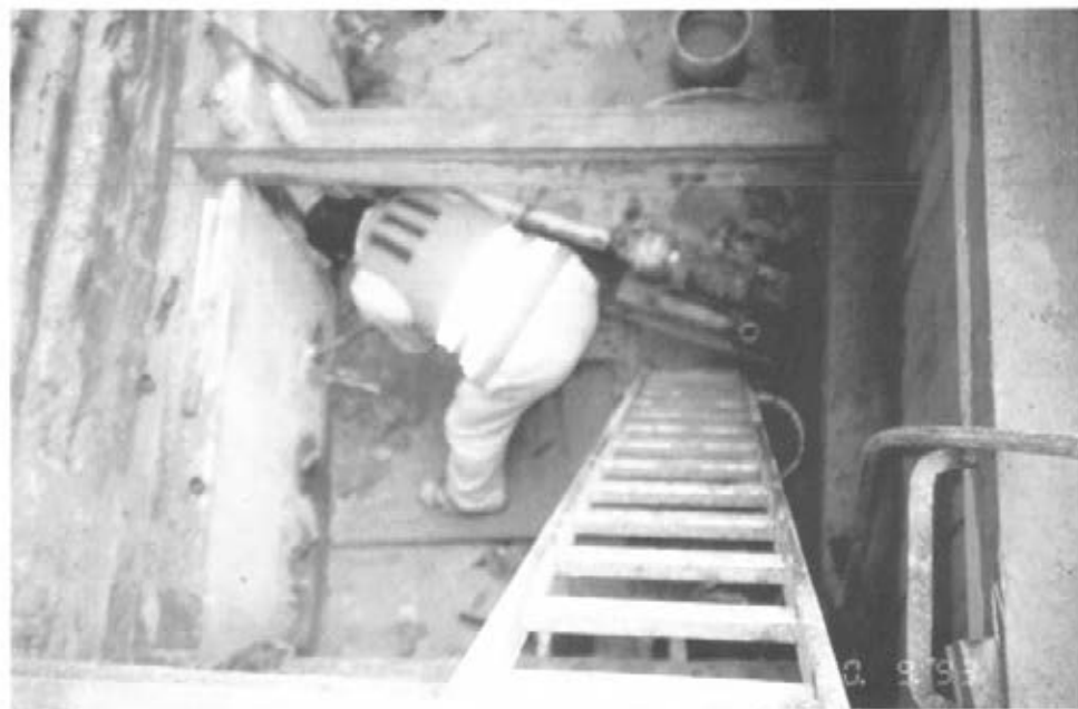
Abbildung 32: Verpressung überwachen (D 26)
