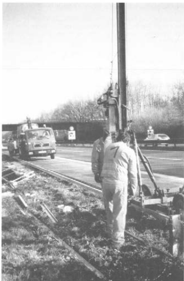
Abbildung 14: Leitplankenpfosten rammen (C5 16)
