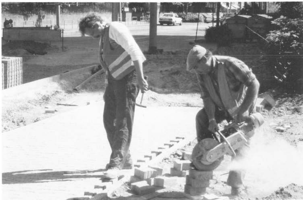
Abbildung 26: Gehwegverbundpflaster schneiden (C1 44)
