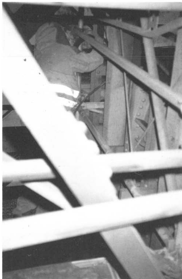
Abbildung 39: Strahlen (E 61)
