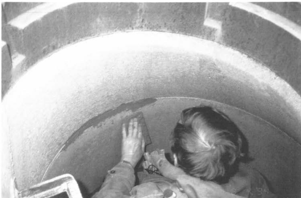
Abbildung 18: Kanalschacht ausfugen (C1 30)
