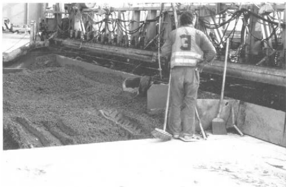
Abbildung 4: Mitgänger am Betondeckenfertiger (C3 3)
