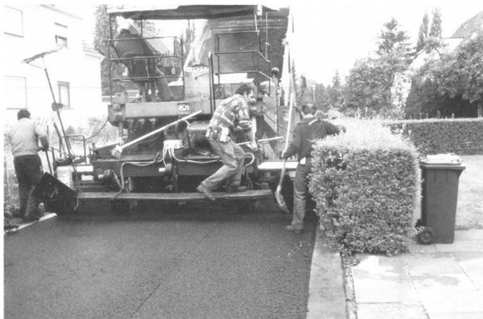
Abbildung 21: Mitgänger am Schwarzdeckenfertiger (C2 16)
