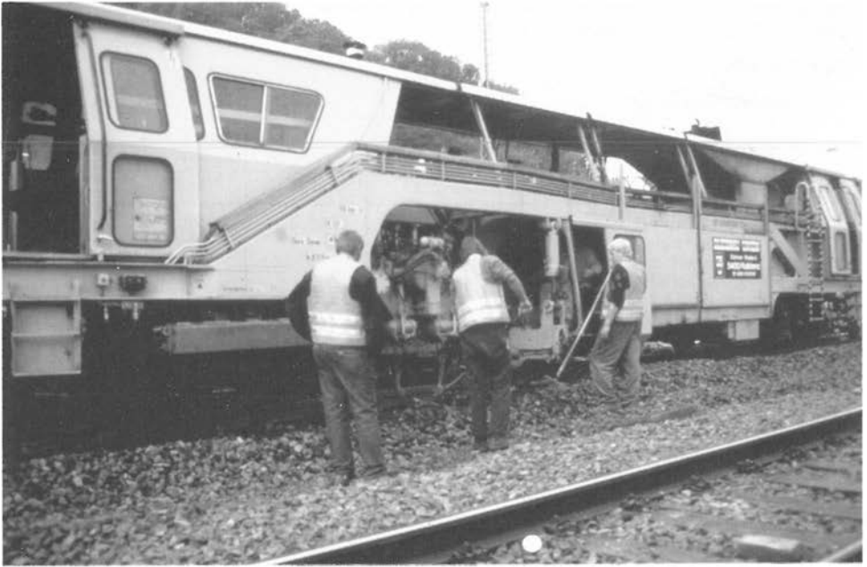
Abbildung 6: Arbeit mit der Schottergabel in der Nähe der Gleisstopfmaschine (A 20, A 21, A 22)
