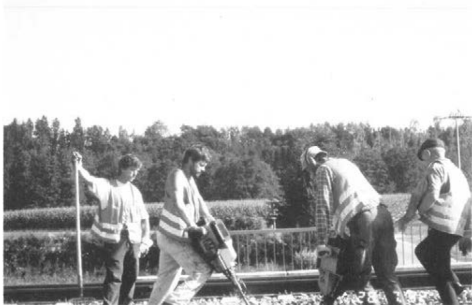
Abbildung 11: Einzelkraftstopfer bedienen (A 30, A 31, A 32)
