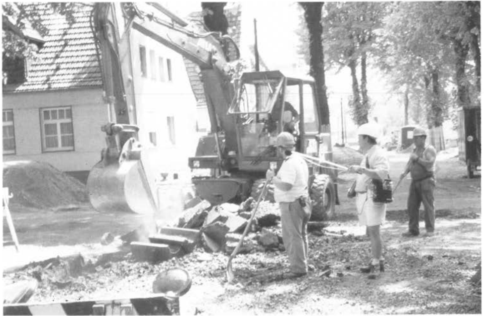
Abbildung 10: Bagger einweisen und nachschichten (C1 14)
