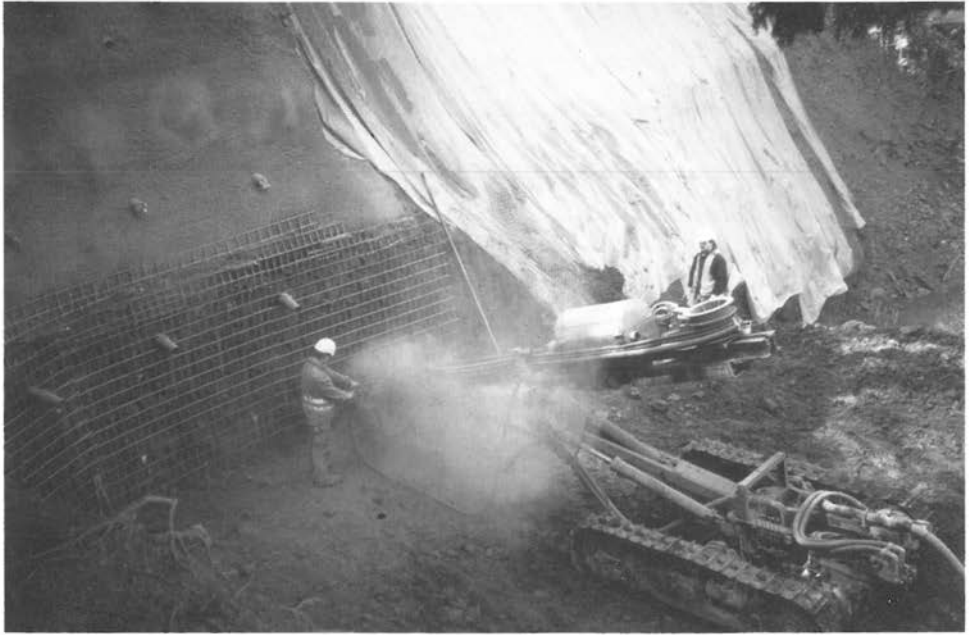
Abbildung 51: Erdringbohrer bohren (D 54)
