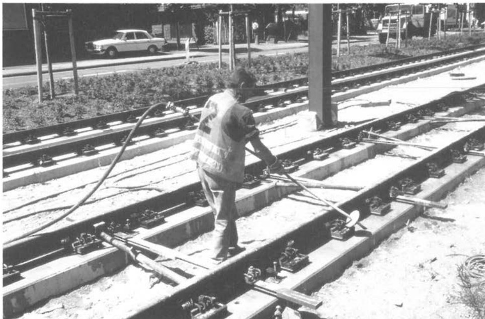
Abbildung 9: Bohrlöcher mit Druckluft säubern (A 26)
