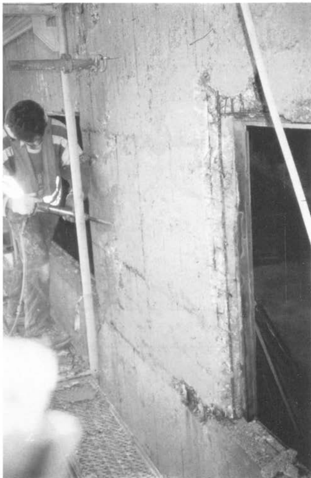
Abbildung 49: Lose Fassadenteile des Brecherbunkers abstemmen (E 73)
