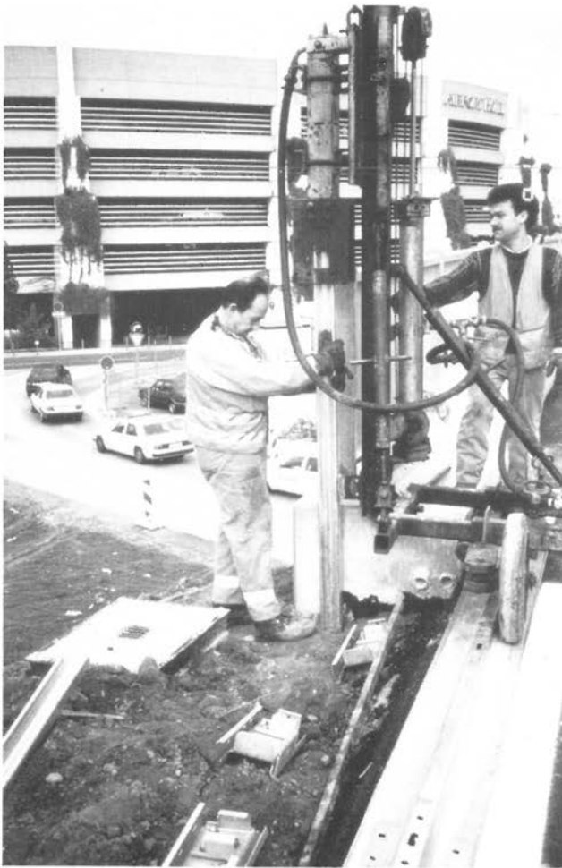
Abbildung 13: Leitplankenpfosten rammen (C5 14)
