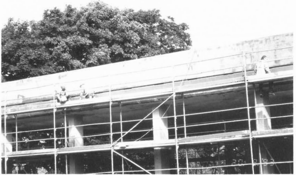
Abbildung 32: Beschichtung auftragen (Glättkelle) (E 46)
