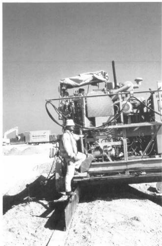
Abbildung 7: Mitgänger am Betondecken- fertiger (C3 7)
