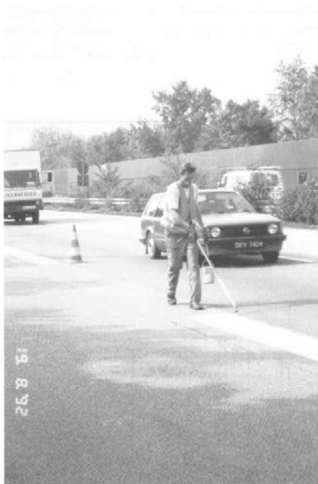
Abbildung 4: Leitlinie vorbereiten (C4 4)
