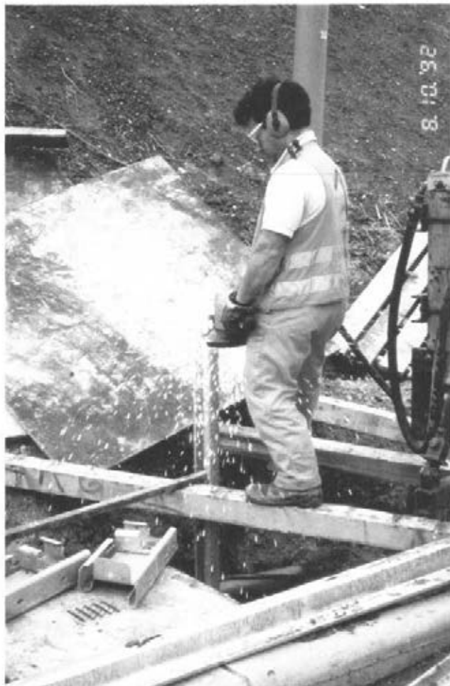
Abbildung 10: Trennen mit Druckluftwinkel- schleifer (C5 10)
