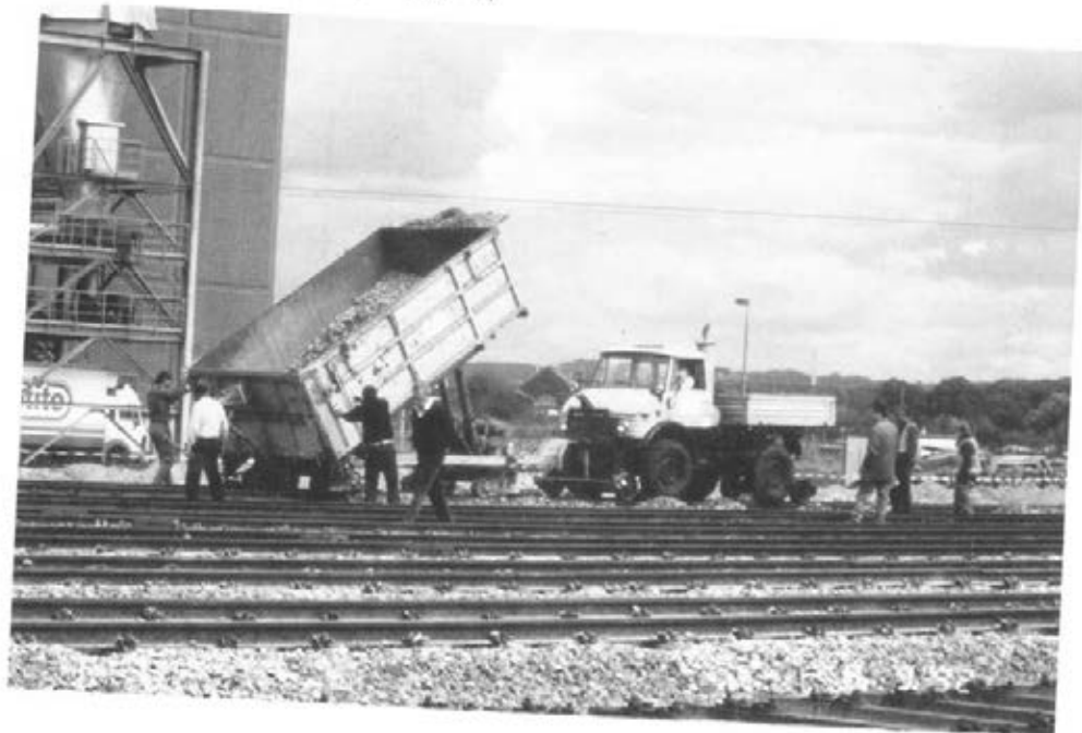
Abbildung 14: Schotter ins Gleis füllen (A 42, A 43, A 44)
