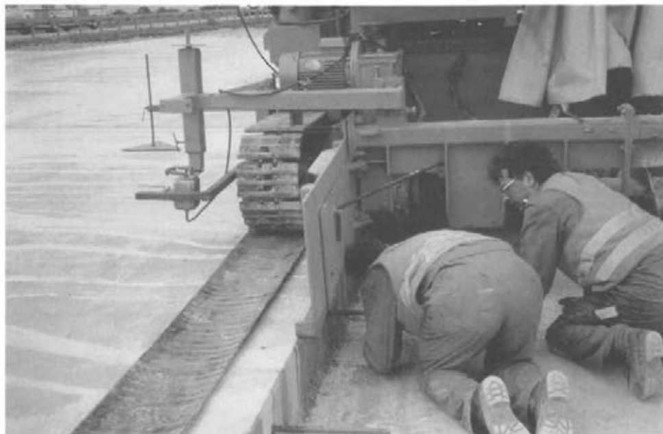
Abbildung 17: Betondeckenfertiger aufbauen (C3 22)
