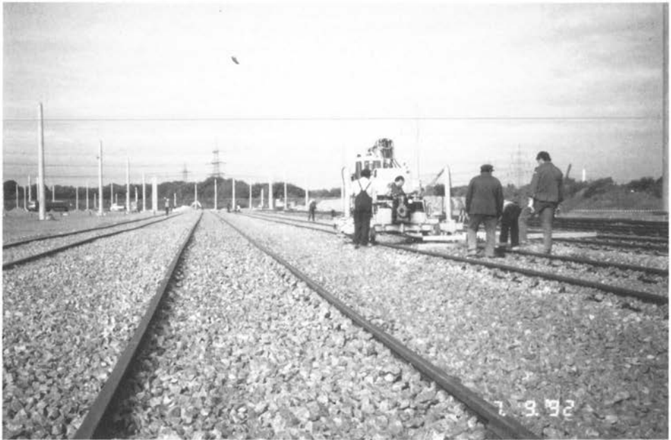
Abbildung 13: Gleise ausrichten und nivellieren (A 39, A 40, A 41)
