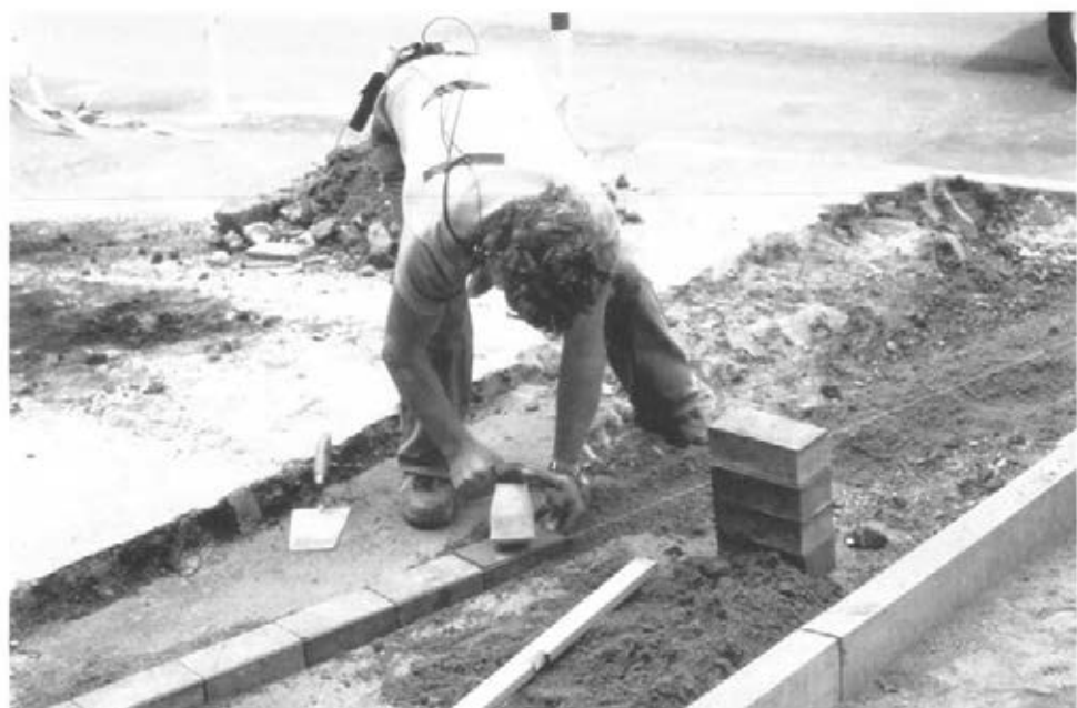
Abbildung 12: Randsteine setzen (C1 17)
