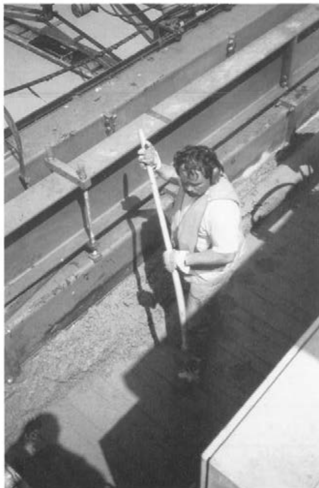
Abbildung 14: Schaufelarbeiten vor der Abziehbahle (C3 19)
