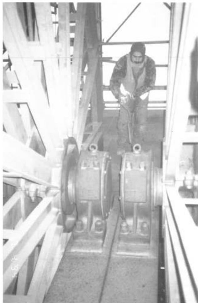
Abbildung 37: Strahlreste abblasen (kleiner Schlauch => geringe Leistung) (E 57)
