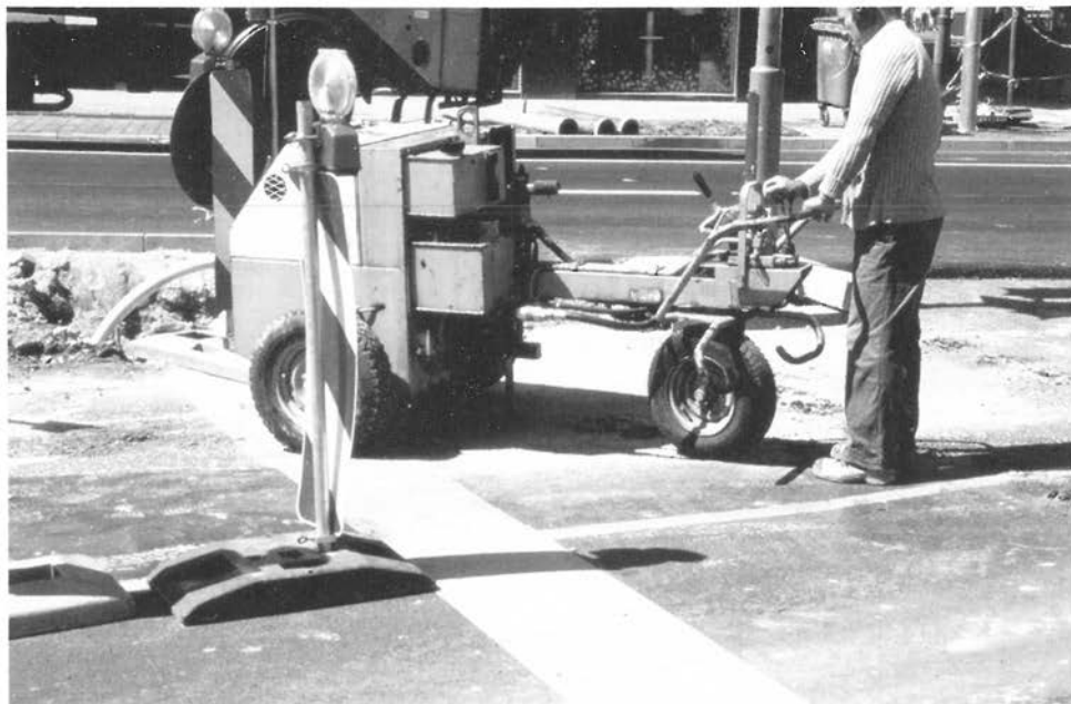
Abbildung 19: Asphaltschneidegerät bedienen (C2 13)
