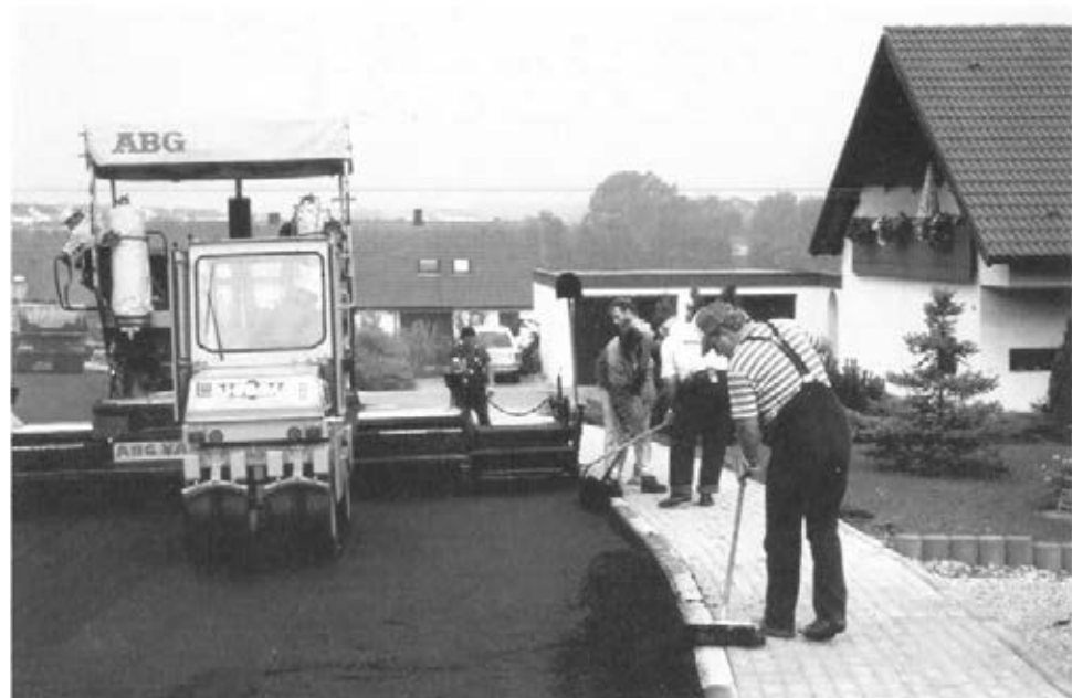
Abbildung 9: Mitgänger am Schwarzdeckenfertiger (C2 2)
