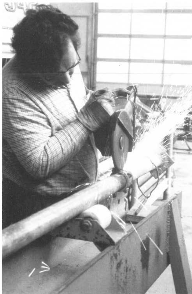
Abbildung 4: Stahlrohrstützen reparieren (B 4)
