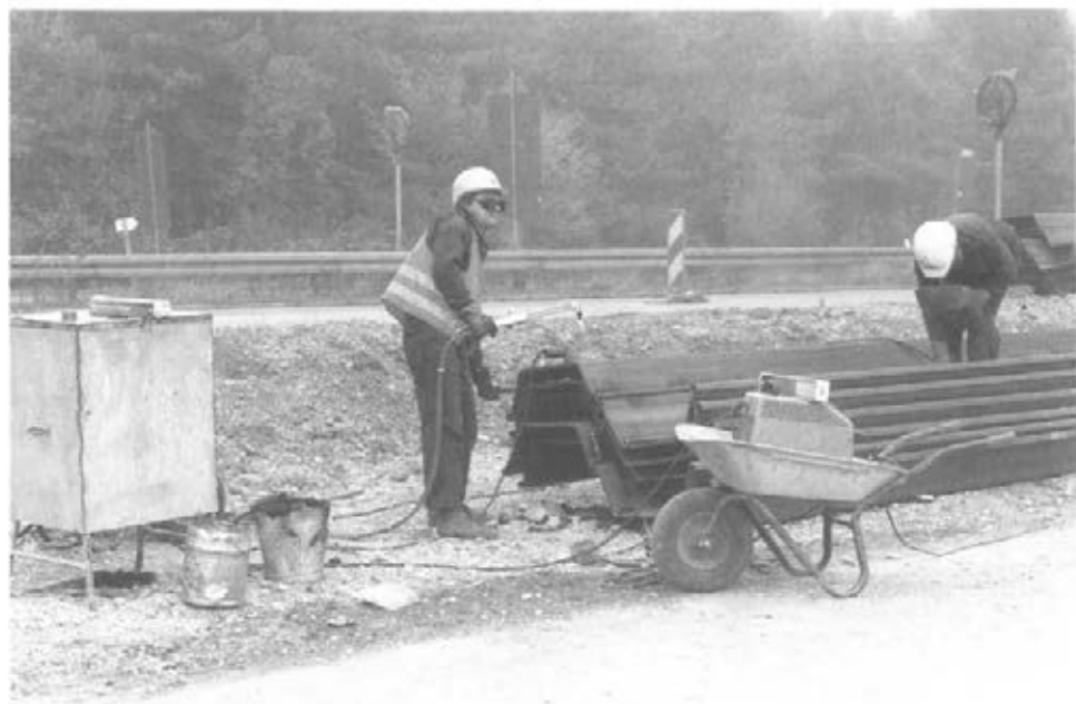
Abbildung 15: Spülrohre montieren (D 1)
