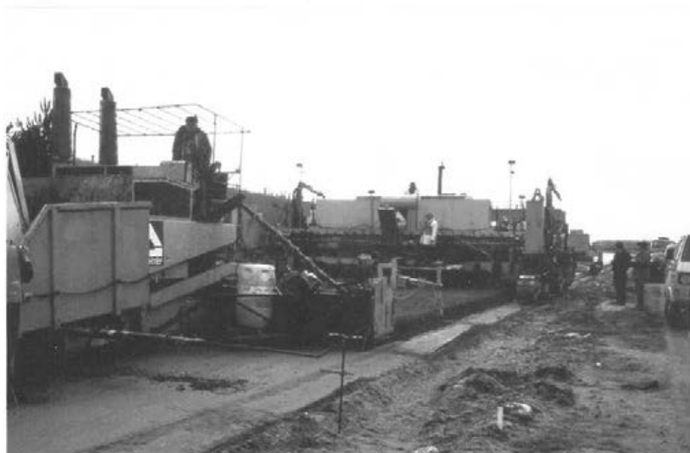
Abbildung 9: Mitgänger am Betondeckenfertiger (C3/10)
