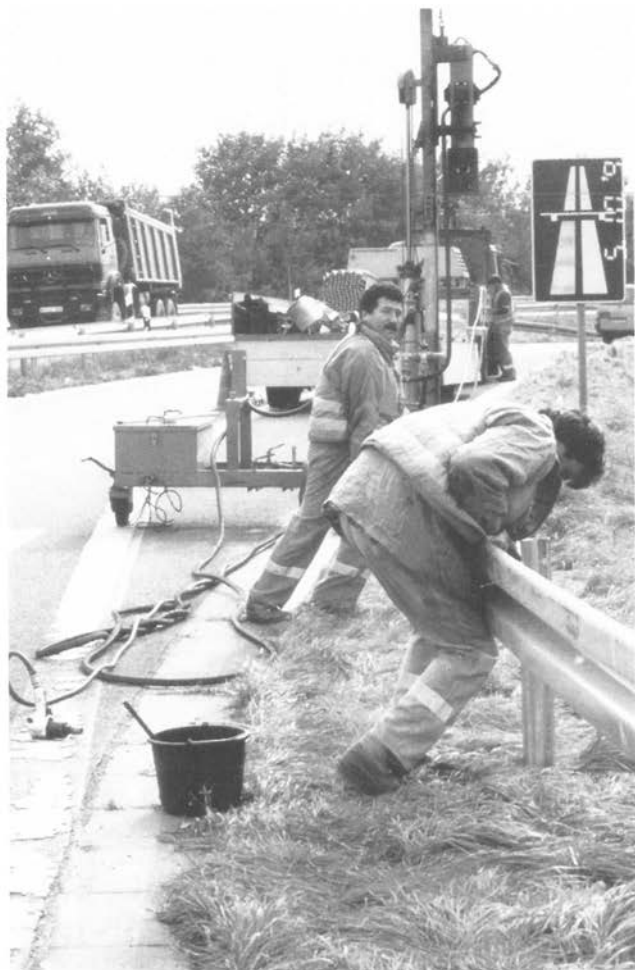
Abbildung 5: Leitplanke richten (C5 2)
