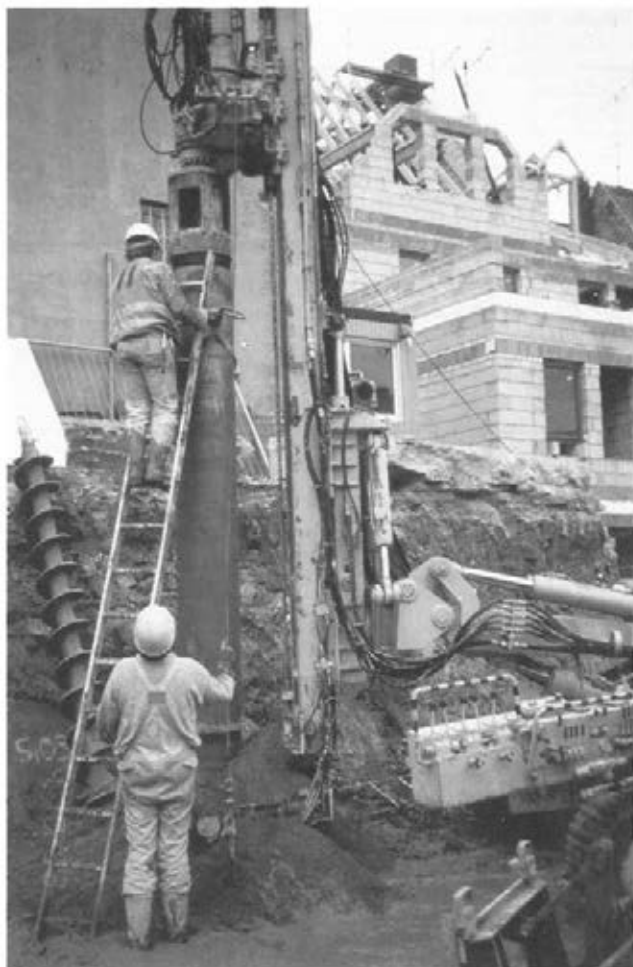
Abbildung 38: Hüllrohr anschlagen (D 34)
