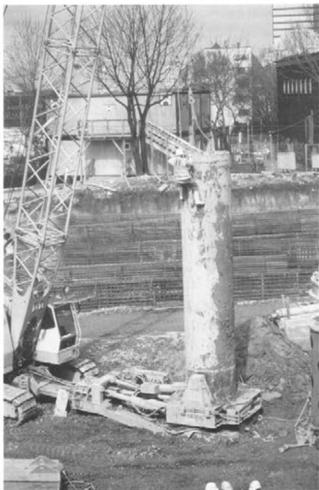
Abbildung 48: Hüllrohrsegment montieren (D 50)
