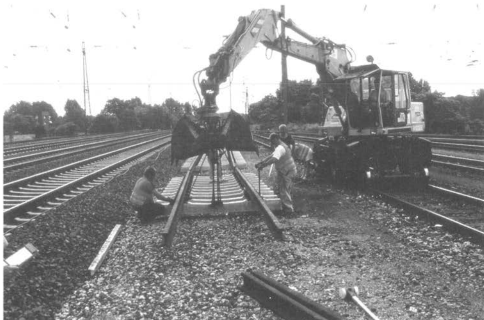
Abbildung 7: Vormontieren der Ersatzgleise (A 23, A 24)
