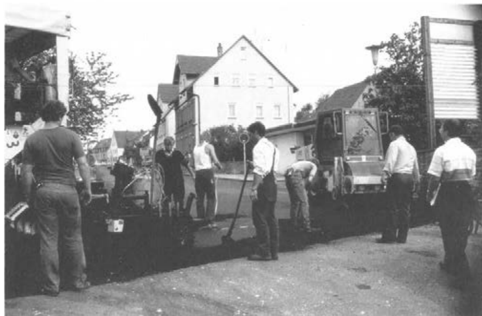
Abbildung 10: Mitgänger am Schwarzdeckenfertiger (C 2 3)
