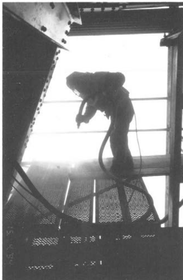
Abbildung 40: Strahlreste abblasen (großer Schlauch => hohe Leistung) (E 63)
