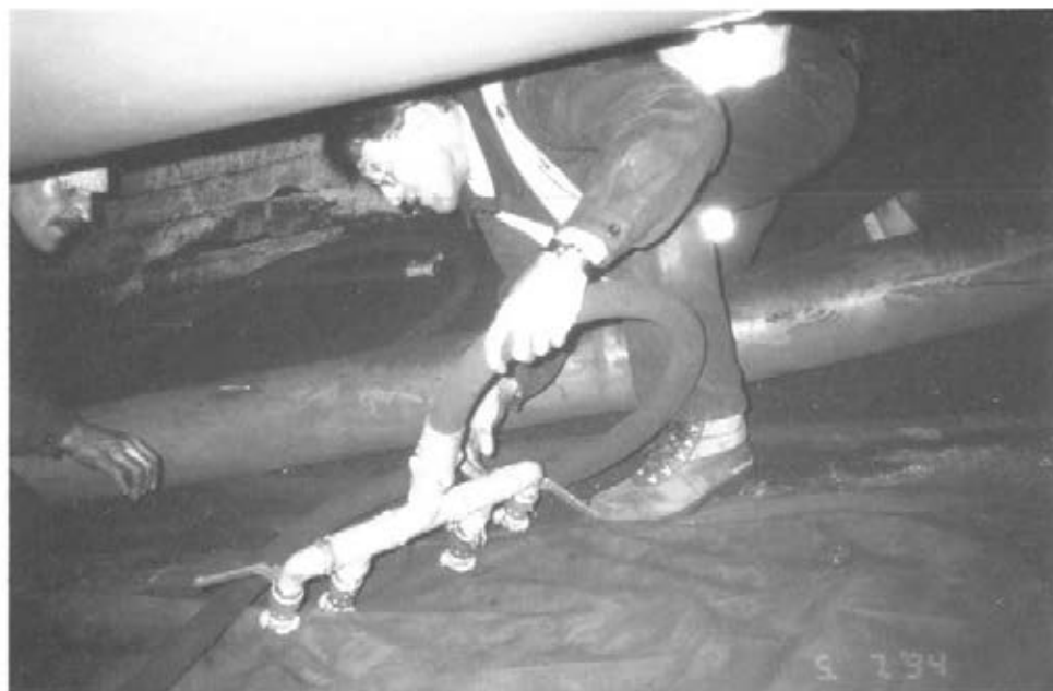
Abbildung 52: Druckluftschläuche ziehen (E 81)
