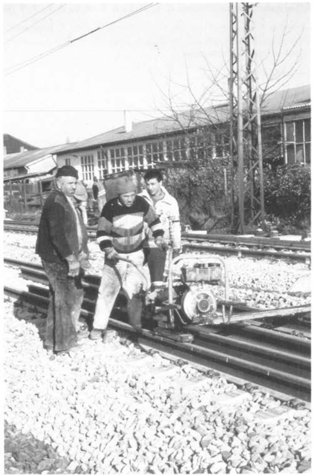
Abbildung 1: Schwellenschraub- und -bohrmaschine bedienen (A 1)
