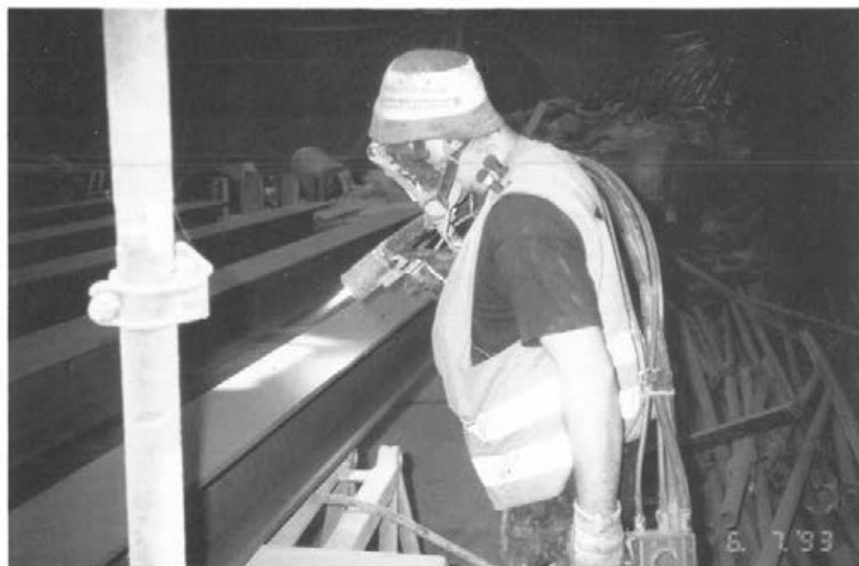
Abbildung 22: Spritzverzinken (E 19)
