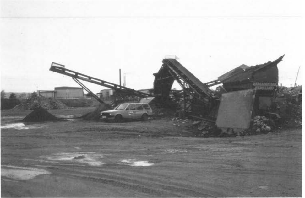
Abbildung 13: Wartungsarbeiten an einer Sortier- und Siebanlage (B 32)
