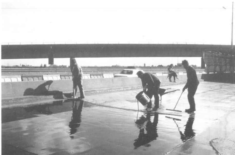
Abbildung 29: Haftbrücke auftragen (C2 31)
