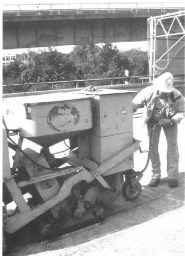
Abbildung 56: Kugelstrahlen (E 86)
