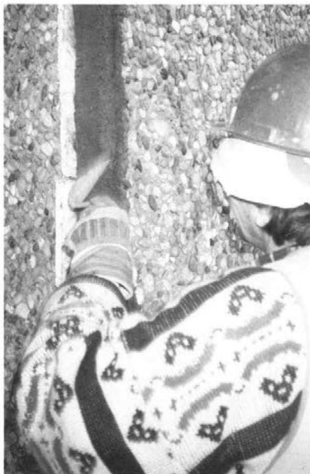
Abbildung 48: Fehlstellen der Wasch- betonfassade ausbessern (Grobarbeit) (E 72)
