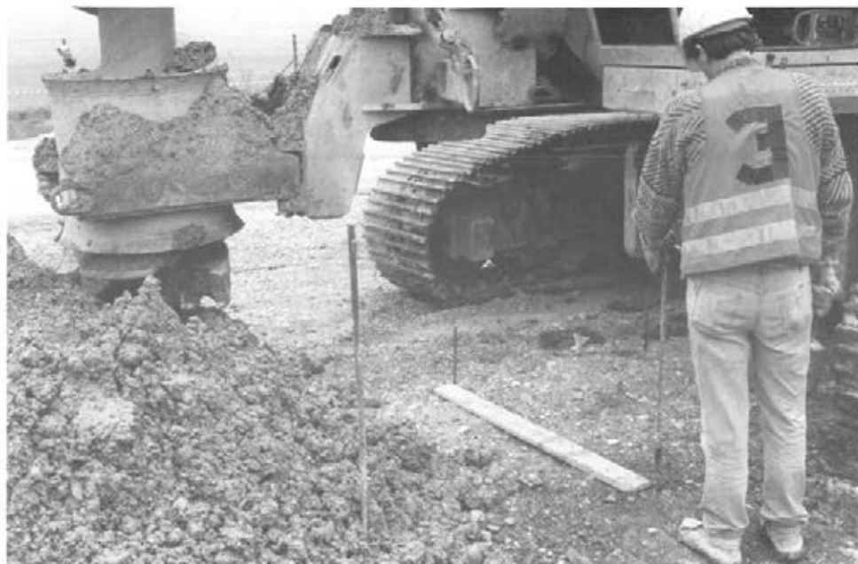
Abbildung 16: Bohrlochmarkierung einschlagen (D 2)
