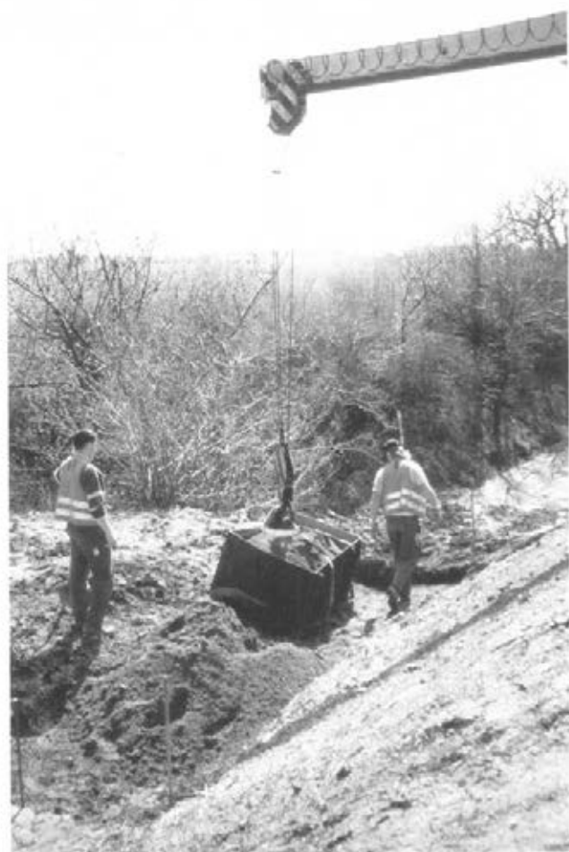
Abbildung 20: Transportbeton annehmen (C1 34)
