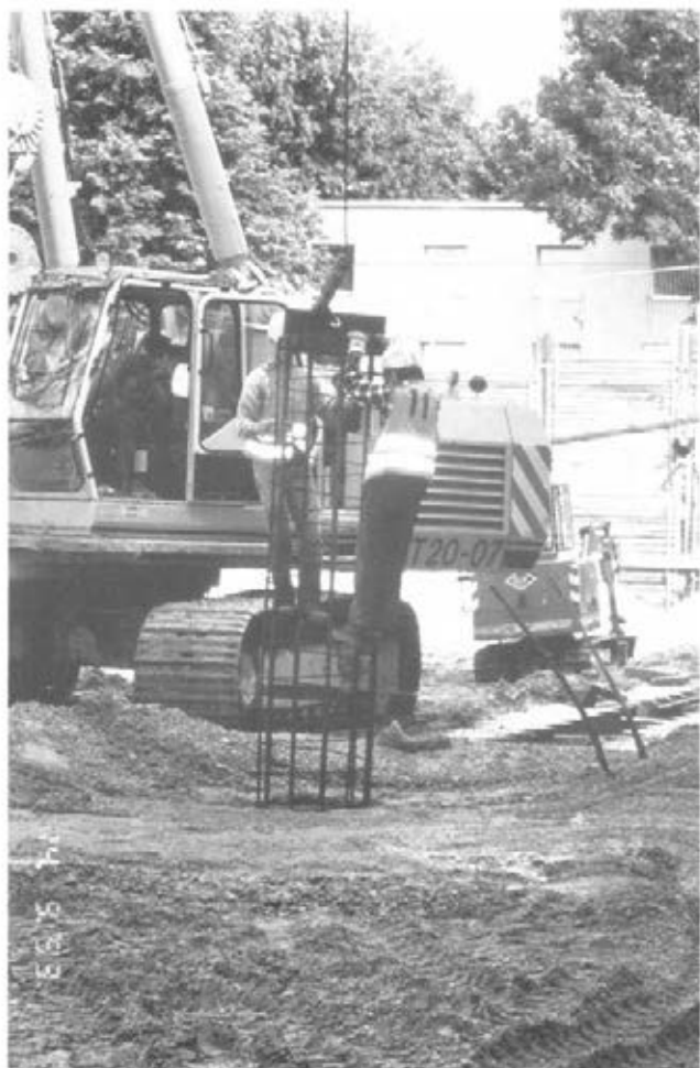
Abbildung 21: Bewehrungskorb einbauen (D 9)
