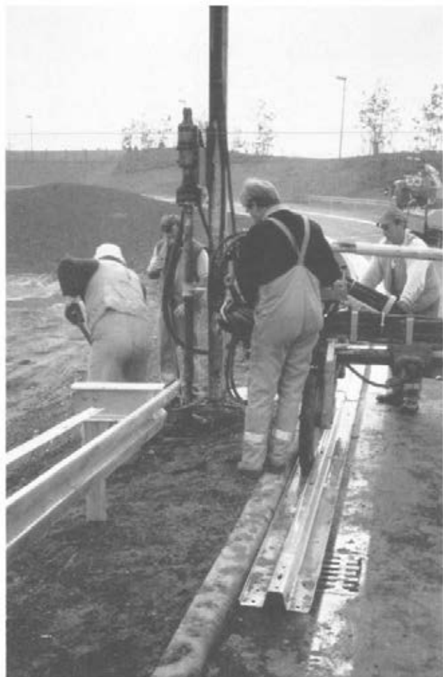
Abbildung 9: Pfostenlöcher mit Schnecke bohren (C5 8)
