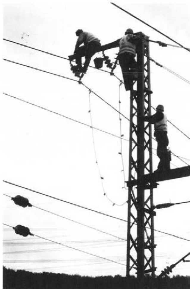
Abbildung 33: Beschichtung auftragen (Pinsel) (E 48)
