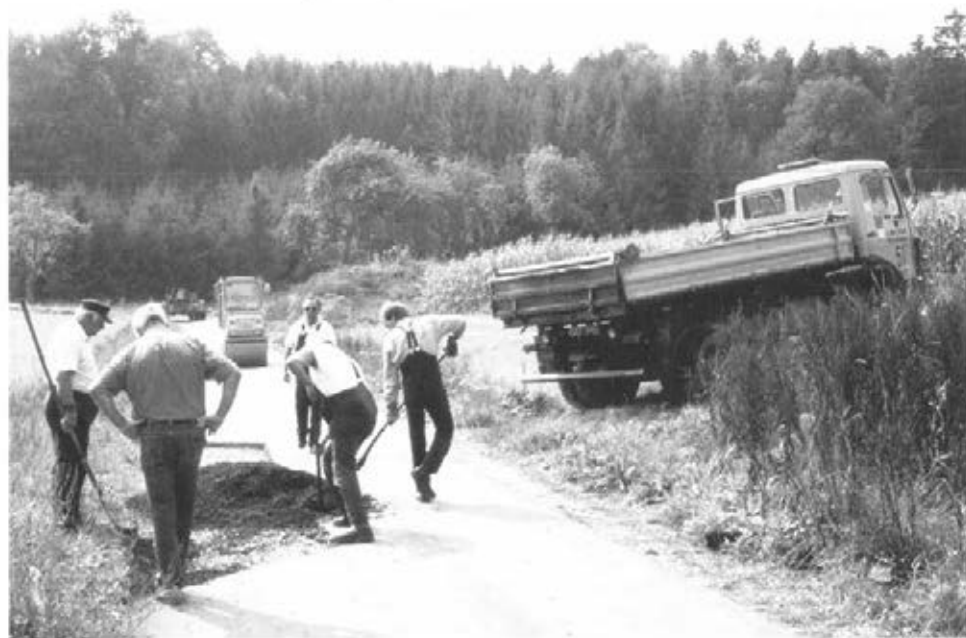
Abbildung 8: Handeinbau einer Ausbesserung (C2 1)
