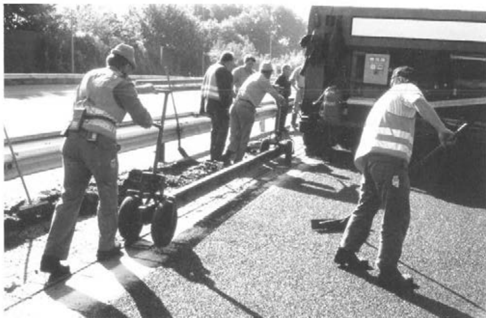
Abbildung 28: Mitgänger am Schwarzdeckenfertiger (C2 30)
