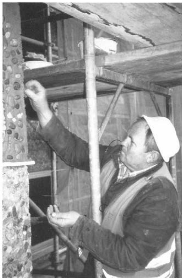
Abbildung 47: Fehlstellen der Wasch- betonfassade ausbessern (Grobarbeit) (E 72)
