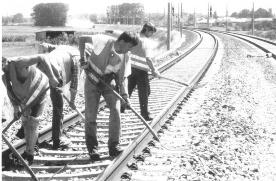
Abbildung 12: Arbeit mit der Schottergabel (A 36, A 37, A 38)
