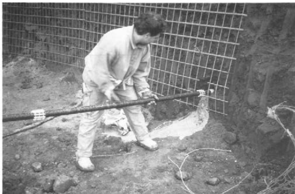
Abbildung 54: Erdnagel einbauen (D 57)
