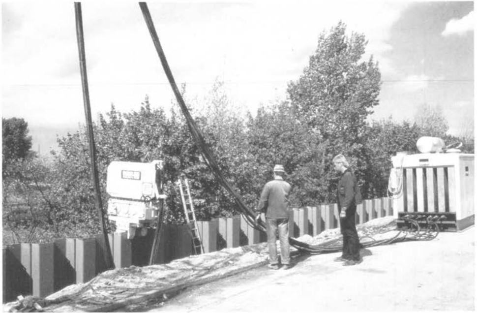
Abbildung 16: Vorbereitung des Spundbohlenziehens mit Vibrationsramme (C1 23)
