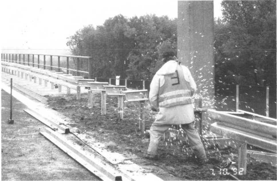
Abbildung 7: Trennen mit Druckluftwinkelschleifer (C5 6)
