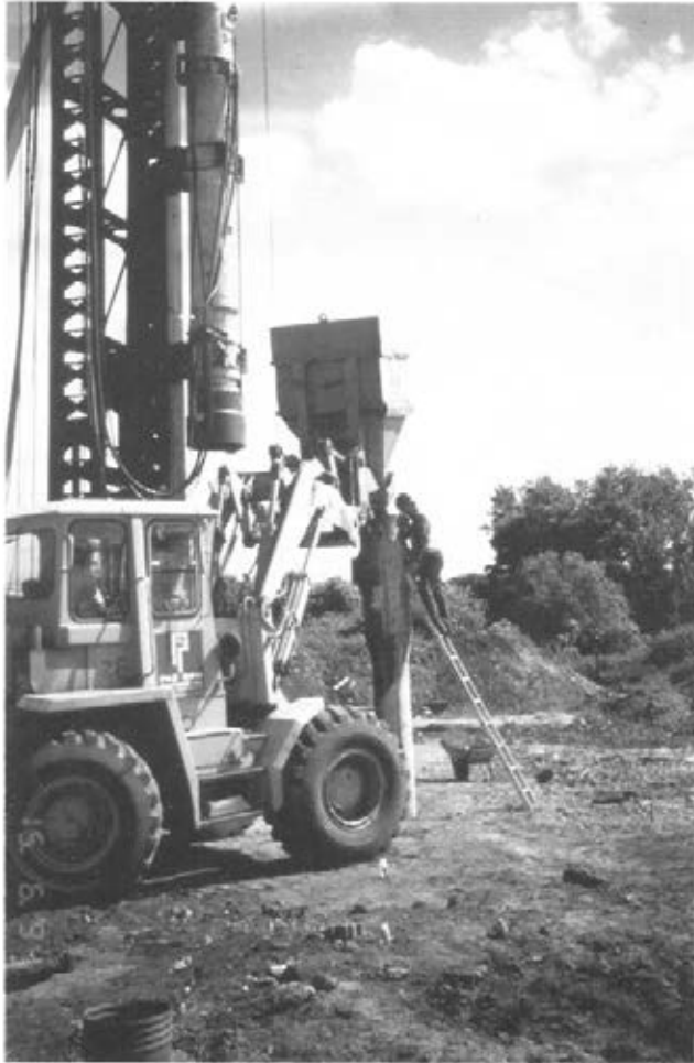
Abbildung 56: Betonieren des Pfahls (D 61)
