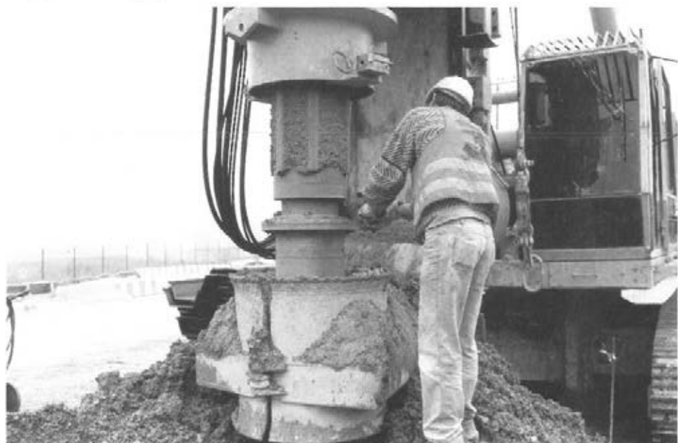
Abbildung 17: Bohrgerät säubern (D 4)
