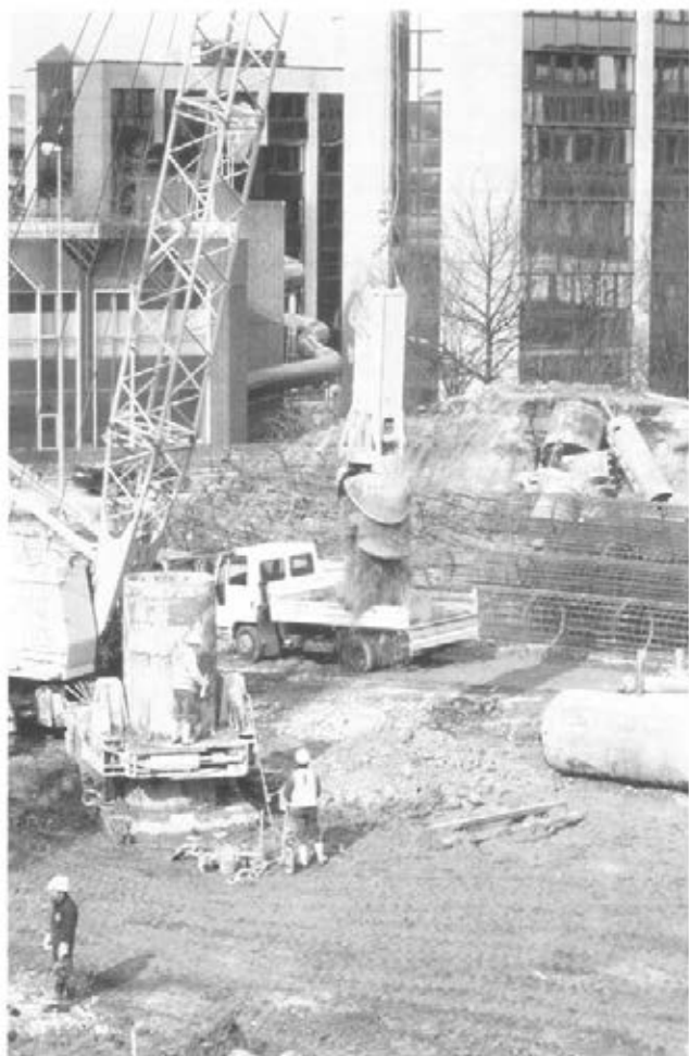
Abbildung 47: Bohrpfahl „greifem“ (D 49)
