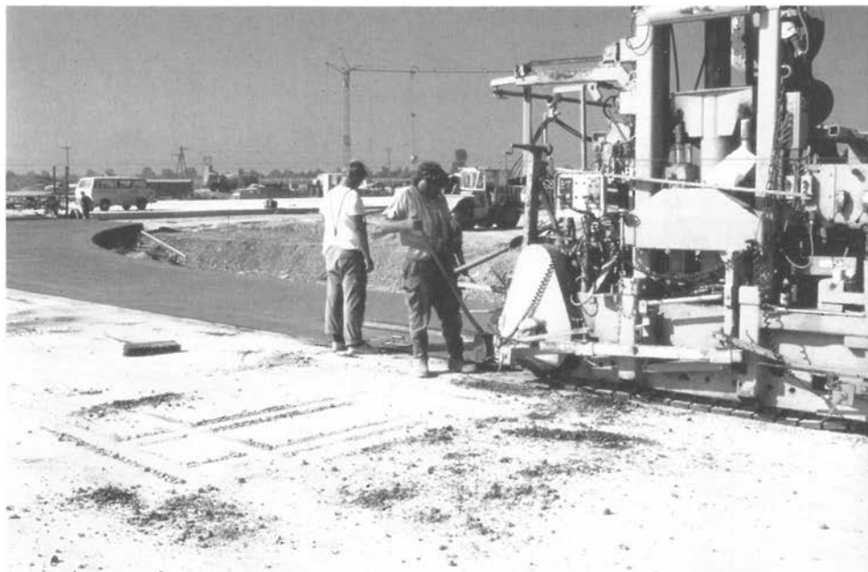
Abbildung 8: Mitgänger am Betondeckenfertiger (C3 8)
