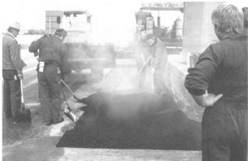
Abbildung 25: Schwarzdeckenhandeinbau (C2 23)
