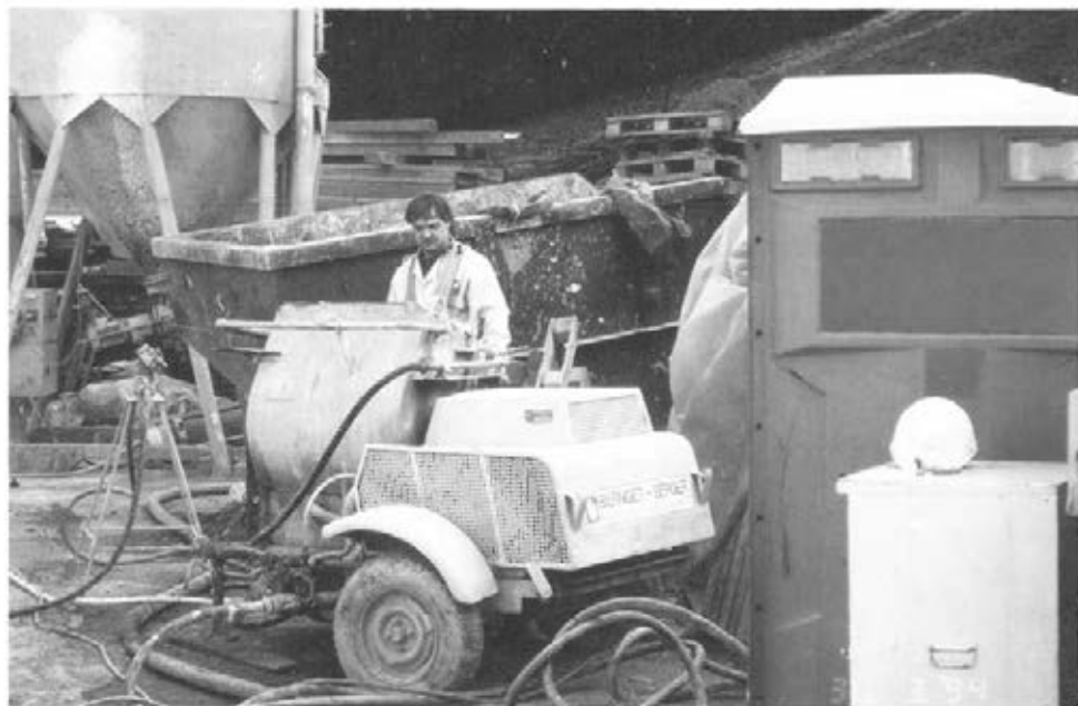
Abbildung 52: Torkret-Maschine bedienen (D 55)
