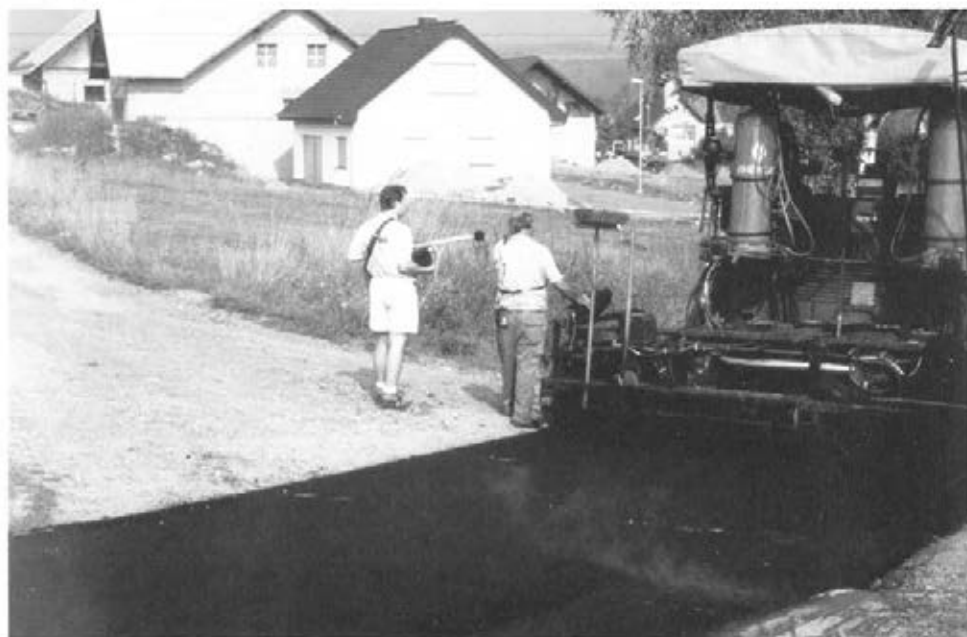
Abbildung 13: Mitgänger am Schwarzdeckenfertiger (C2 7)
