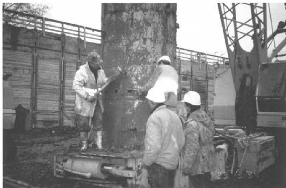
Abbildung 45: Hüllrohrsegment demontieren (D 44)
