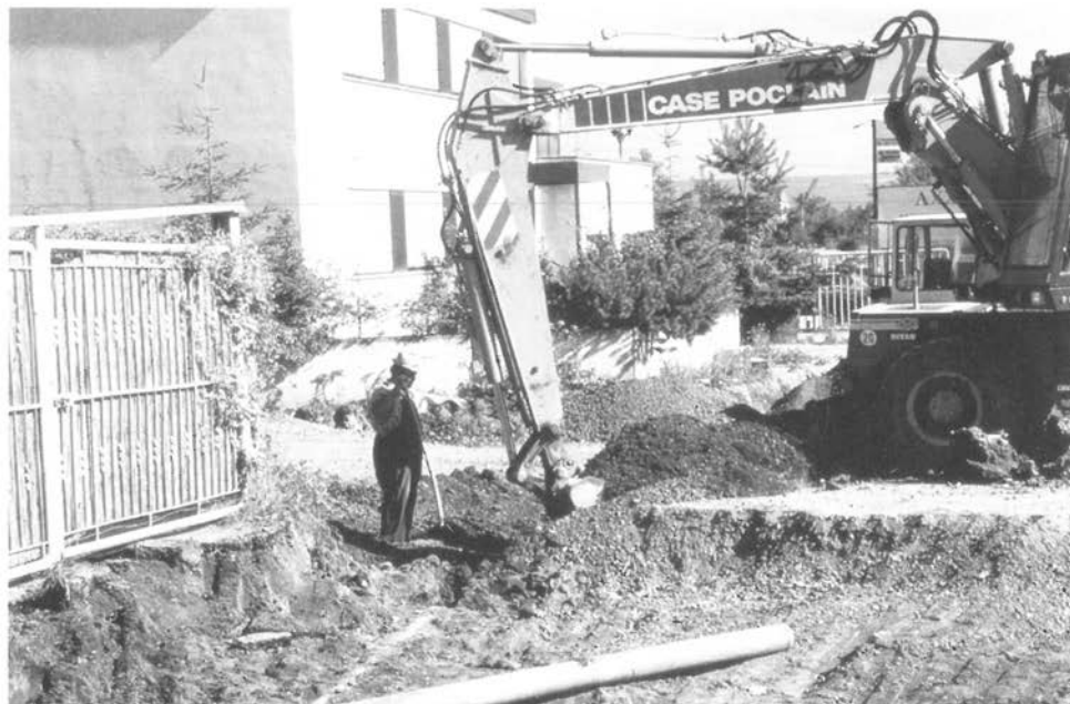
Abbildung 14: Bagger einweisen und nachschichten (C1 21)
