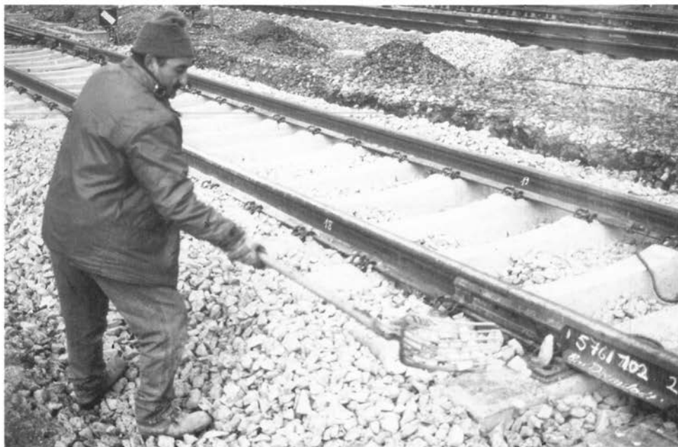
Abbildung 2: Schotter mit der Handgabel verteilen (A 2)
