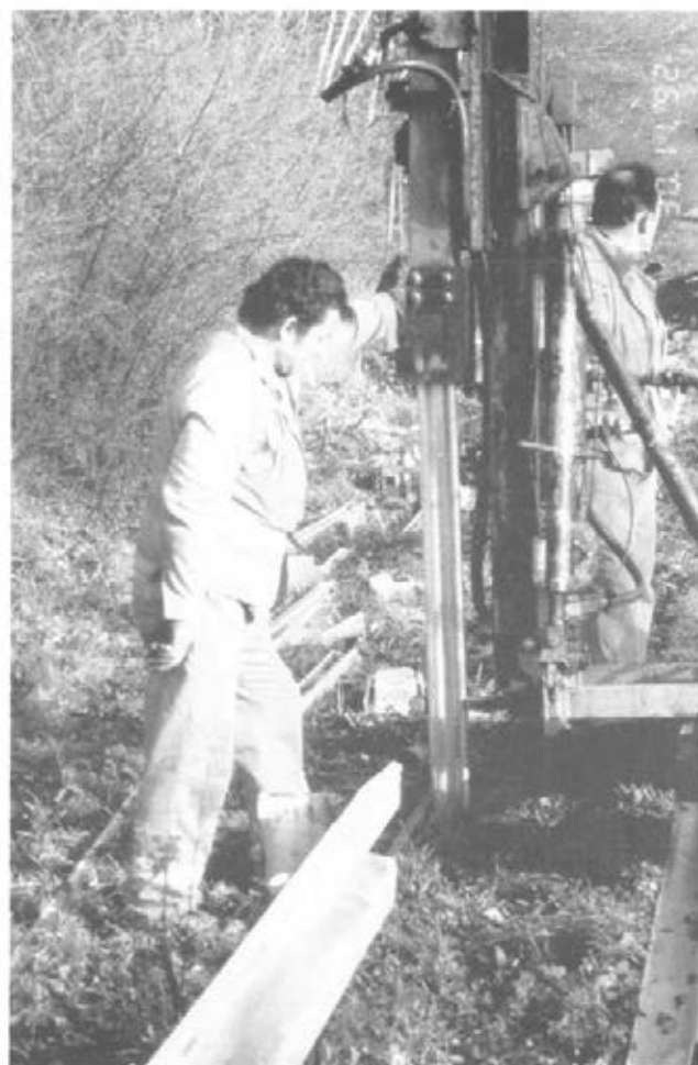
Abbildung 19: Leitplankenpfosten rammen (C5 27)
