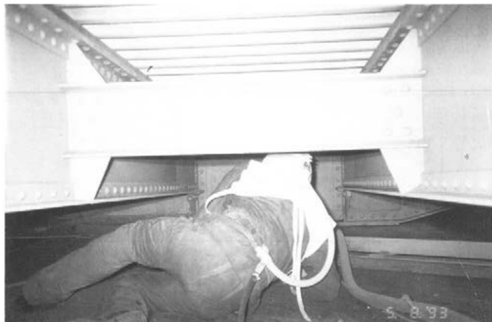
Abbildung 27: Brückenunterseite strahlen (E 35)
