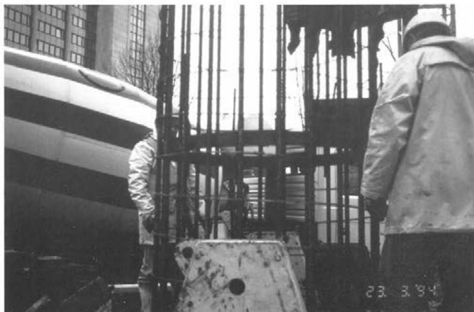
Abbildung 44: Bohrpfahl bewehren (D 43)
