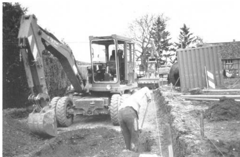
Abbildung 17: Bagger einweisen und nachschichten (C1 28)
