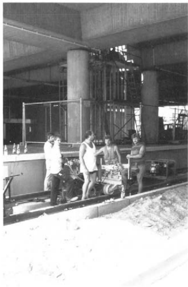
Abbildung 8: Befestigungslöcher bohren (A 25)
