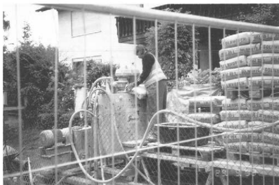
Abbildung 29: Turbomischer/Betonpumpe bedienen (D 23)
