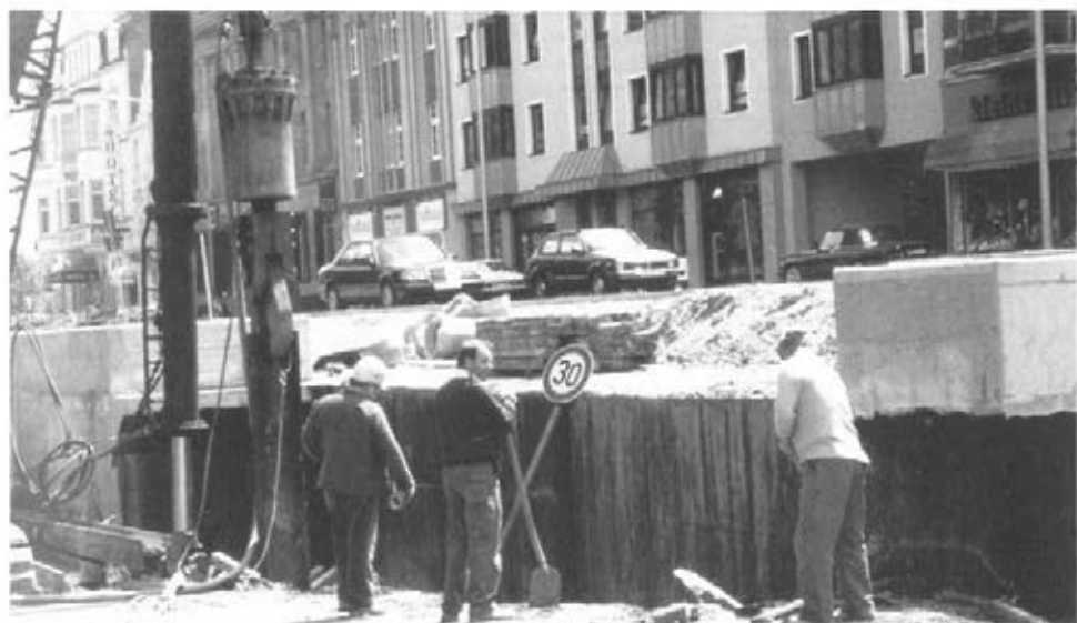
Abbildung 18: Schaufelarbeit in der Nähe eines Druckluftziehgerätes (C2 12)
