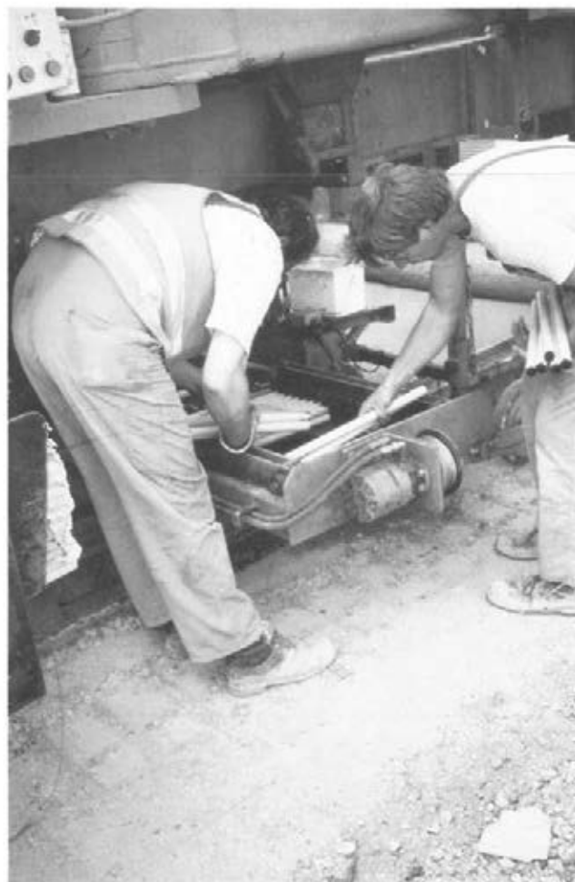
Abbildung 13: Dübel einlegen (C3 18)
