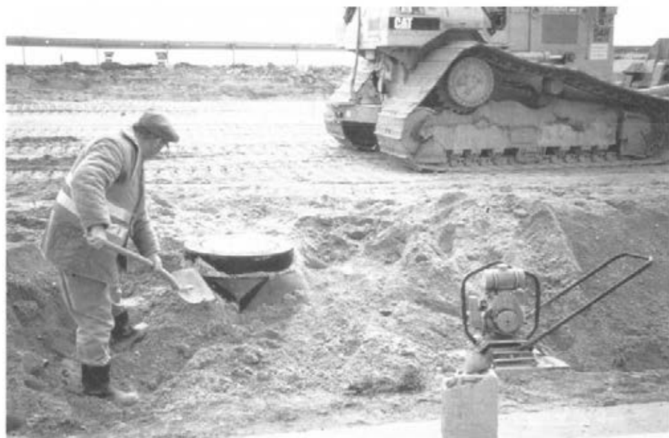
Abbildung 19: Planum um Kanalschacht verdichten (C1 33)
