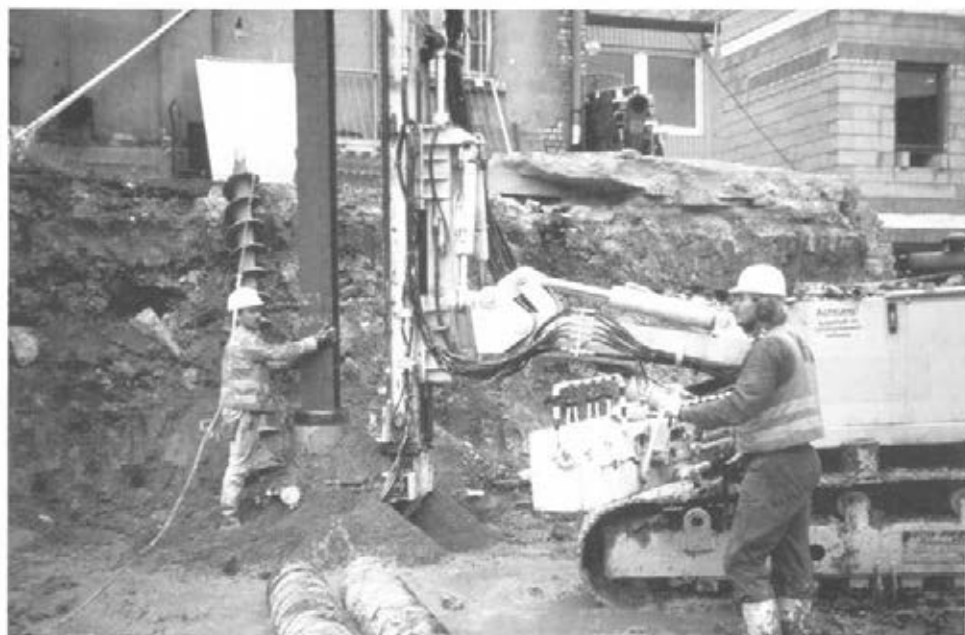
Abbildung 39: Träger einbauen (D 35)
