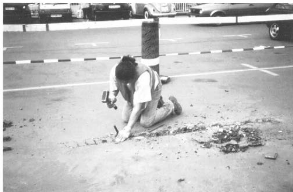
Abbildung 43: Bitumenblasen aufschlagen (E 66)
