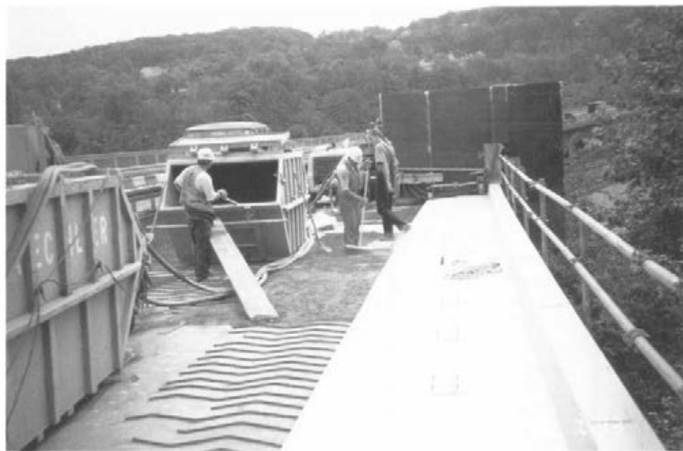
Abbildung 21: Strohgutreste entfernen (E 18)
