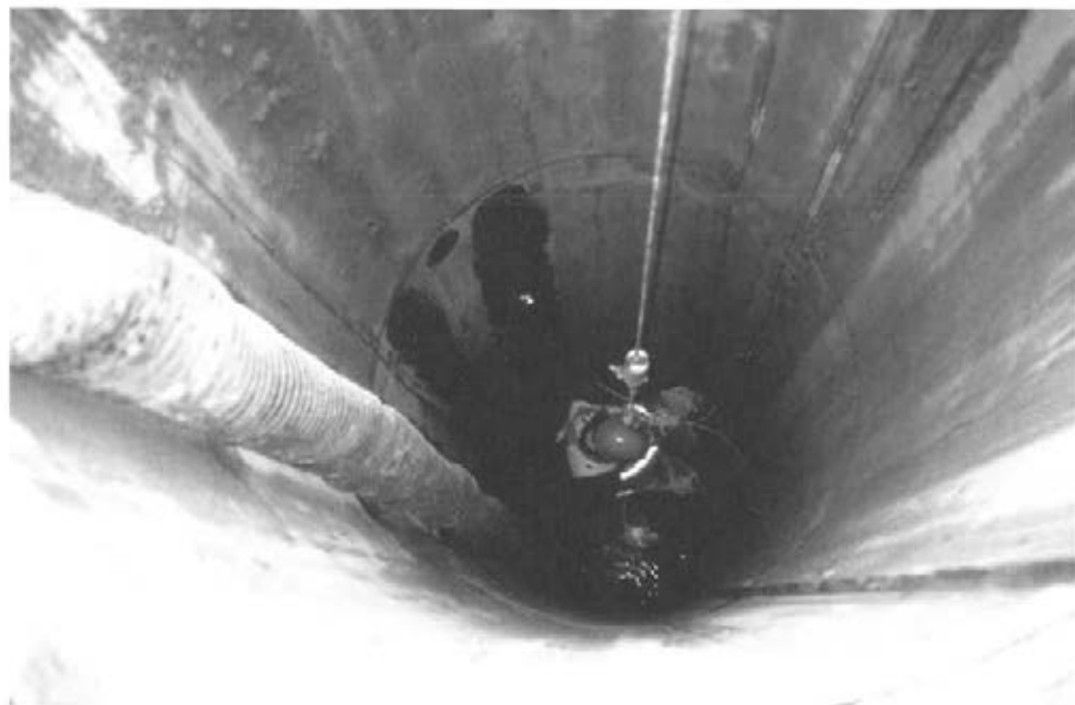
Abbildung 46: Bohrlochgrund säubern (D 48)
