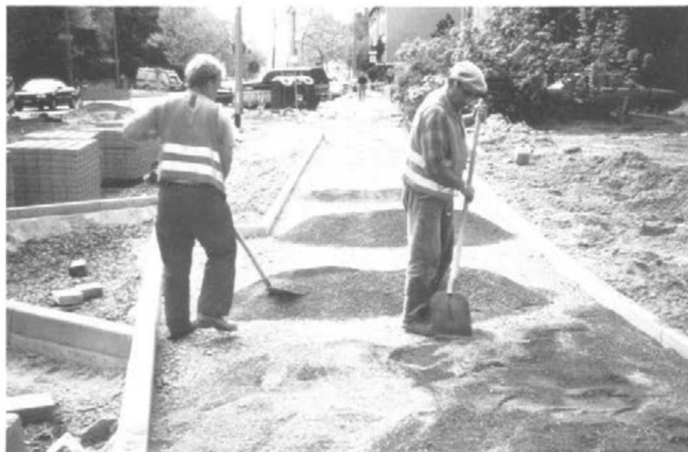
Abbildung 25: Gehwegplanum erstellen (C1 42)
