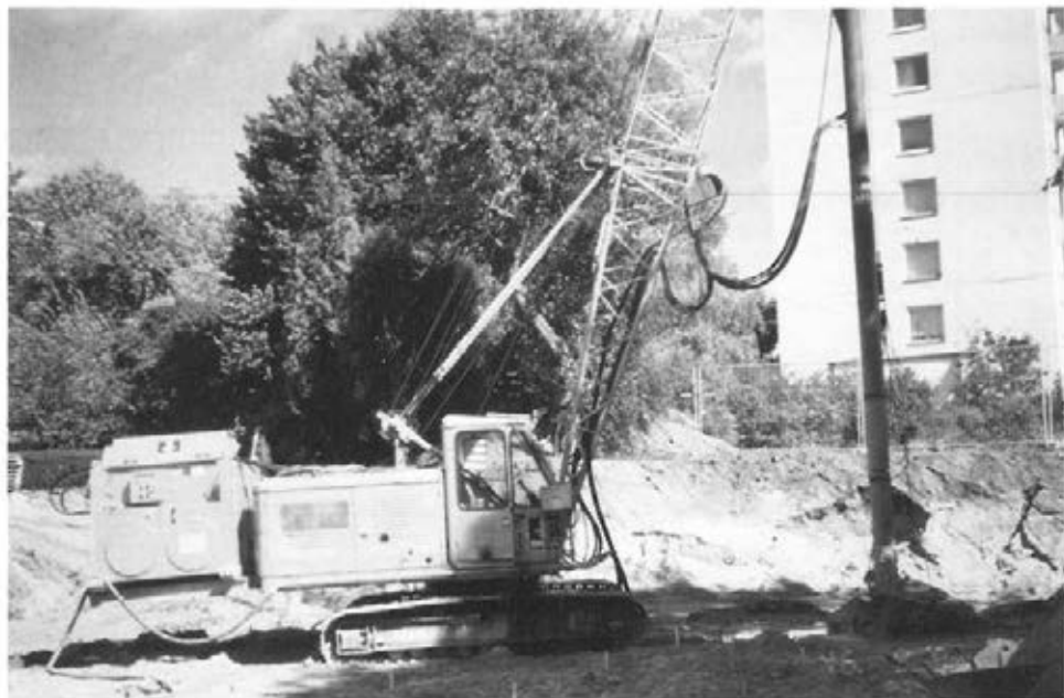
Abbildung 24: Aufsicht über die Tiefenverdichtung (D 14)
