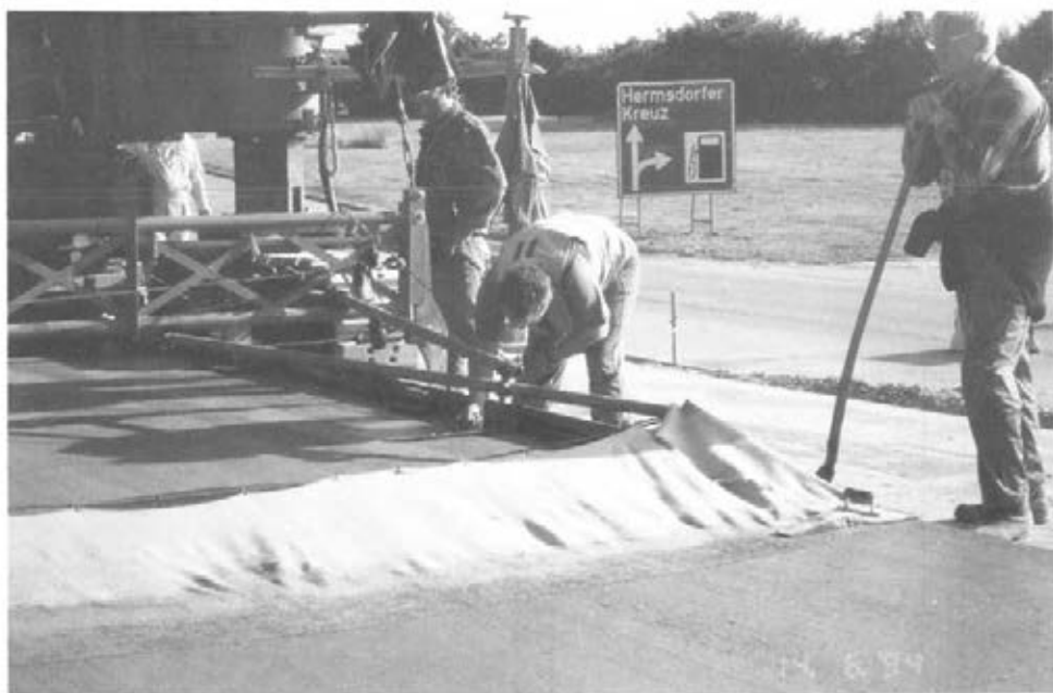
Abbildung 16: Nachglätten der Betondeckenkante (C3 21)
