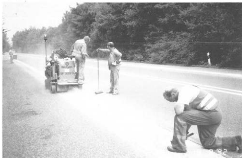
Abbildung 2: Mitgänger an der Straßenfräse (C4 2)
