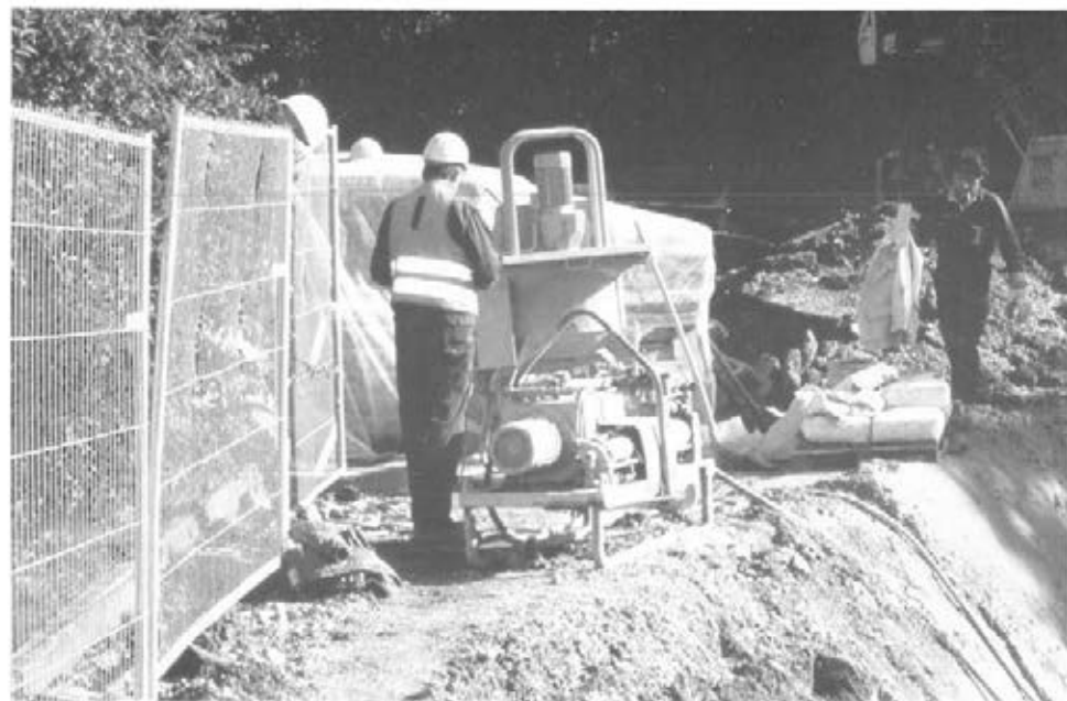
Abbildung 23: Injektionspumpe bedienen (D 11)
