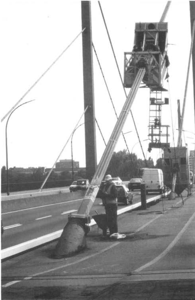
Abbildung 15: Entfernen der alten Besselung (E 3)
