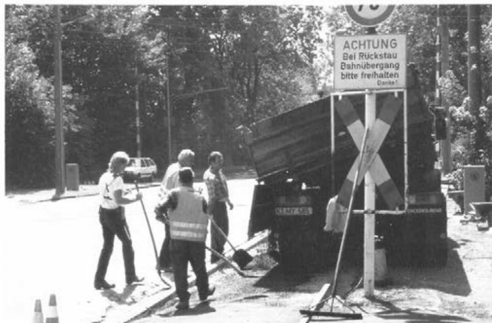
Abbildung 23: Schwarzdeckenhandeinbau (C2 19)
