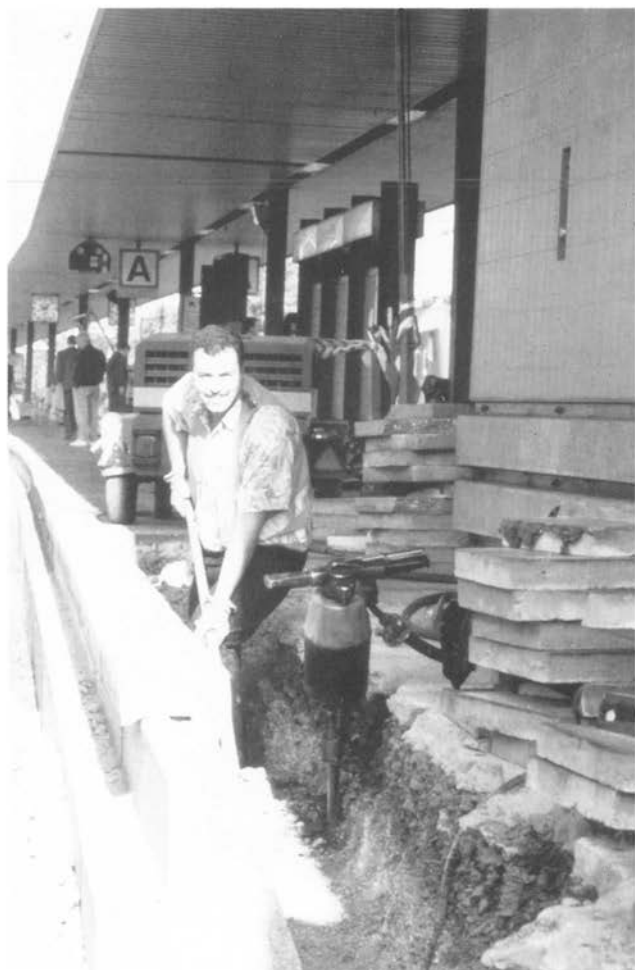
Abbildung 16: Bahnsteigkante mit Druckluft- hammer entfernen (A 47)
