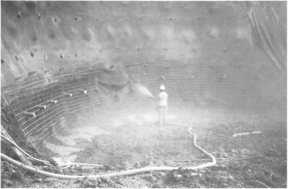
Abbildung 55: Spritzbeton auftragen (D 57)
