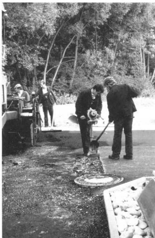
Abbildung 11: Schwarzdeckenkante abstechen (C2 5)
