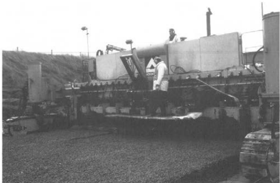
Abbildung 10: Mitgänger am Betondeckenfertiger (C2 11)
