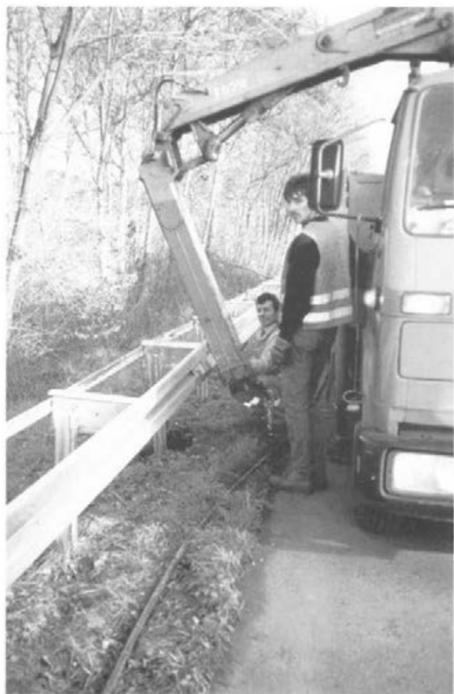
Abbildung 15: Leitplanke richten (Kran) (C5 18)
