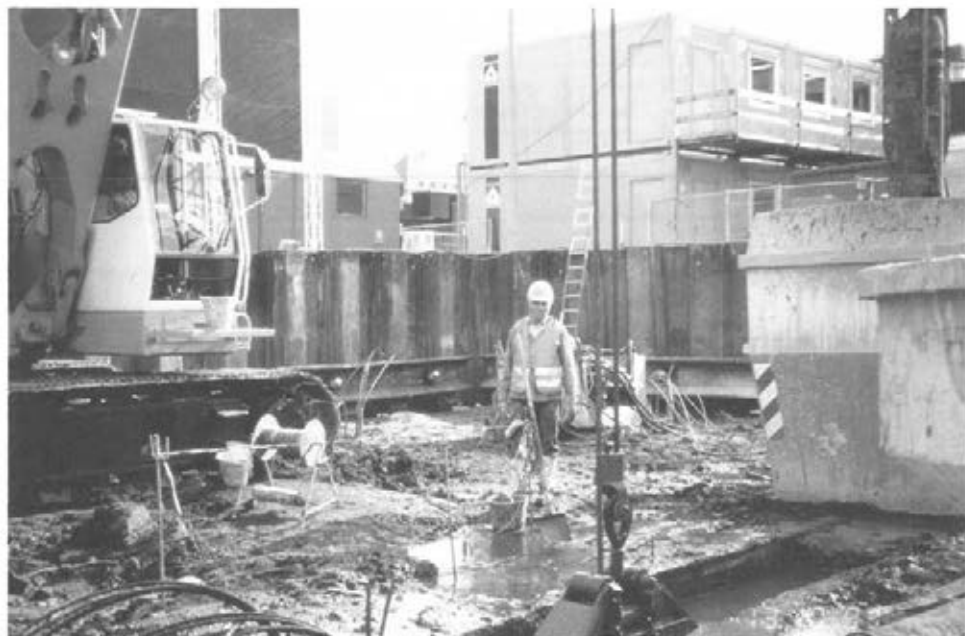
Abbildung 36: Nebenarbeiten, Schlitzwandtiefe messen (D 32)
