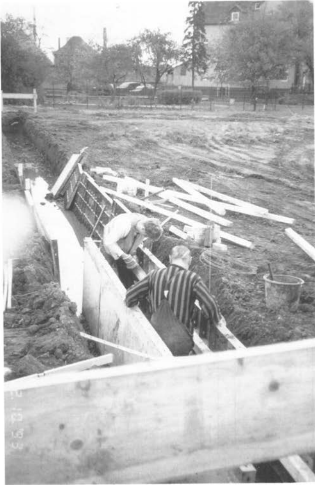
Abbildung 33: Leitwandschalung aufbauen (D 28)
