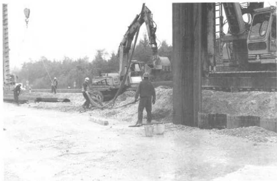
Abbildung 20: Spülschläuche führen (D 7)
