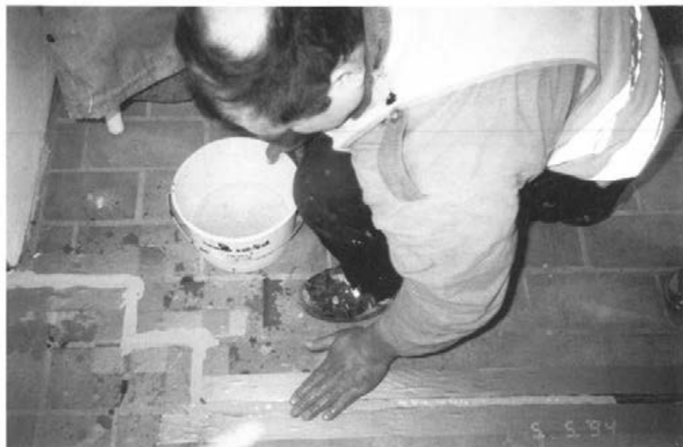
Abbildung 46: Fehlstellen der Waschbetonfassade ausbessern (Feinarbeit) (E 71)
