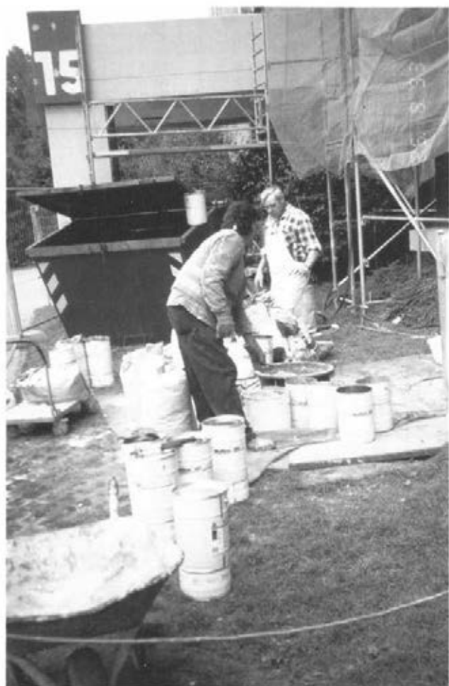
Abbildung 35: Beschichtungsmaterial anrühren (E 53)
