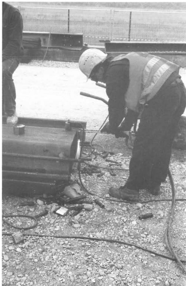
Abbildung 18: Spülrohrleitungen abbrennen (D 5)
