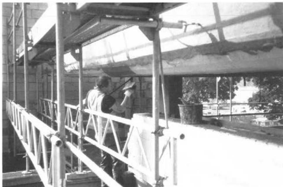
Abbildung 29: Beschichtung auftragen (Glättkelle) (E 37)
