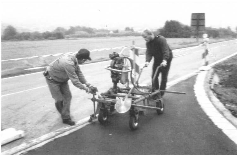
Abbildung 15: Kantenschlagmaschine bedienen (C2 9)
