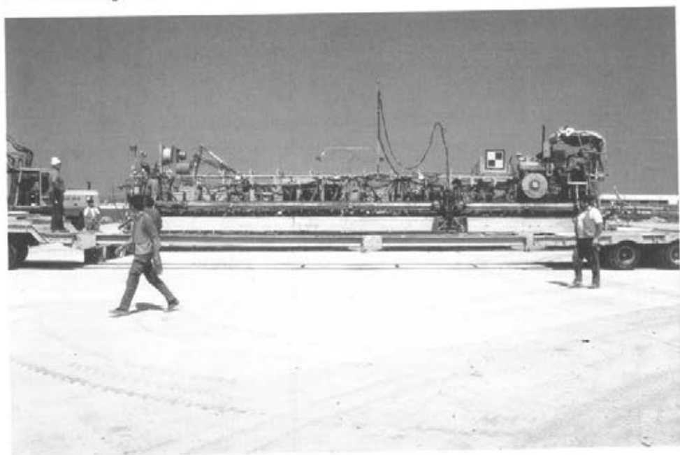
Abbildung 6: Betondeckenfertiger umsetzen (C3 6)
