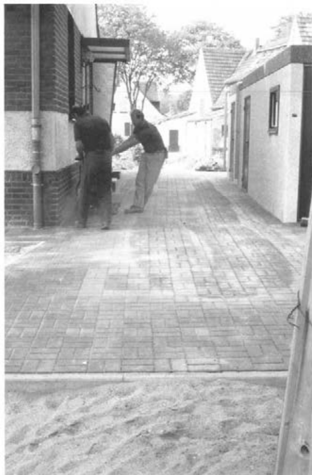
Abbildung 9: Pflaster einer Einfahrt abrütteln (Rüttelplatte mit Gummimatte) (C1 13)
