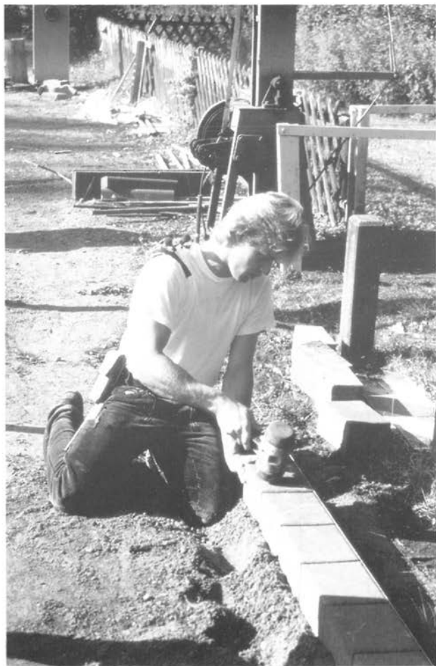
Abbildung 24: Randsteine setzen (C2 21)
