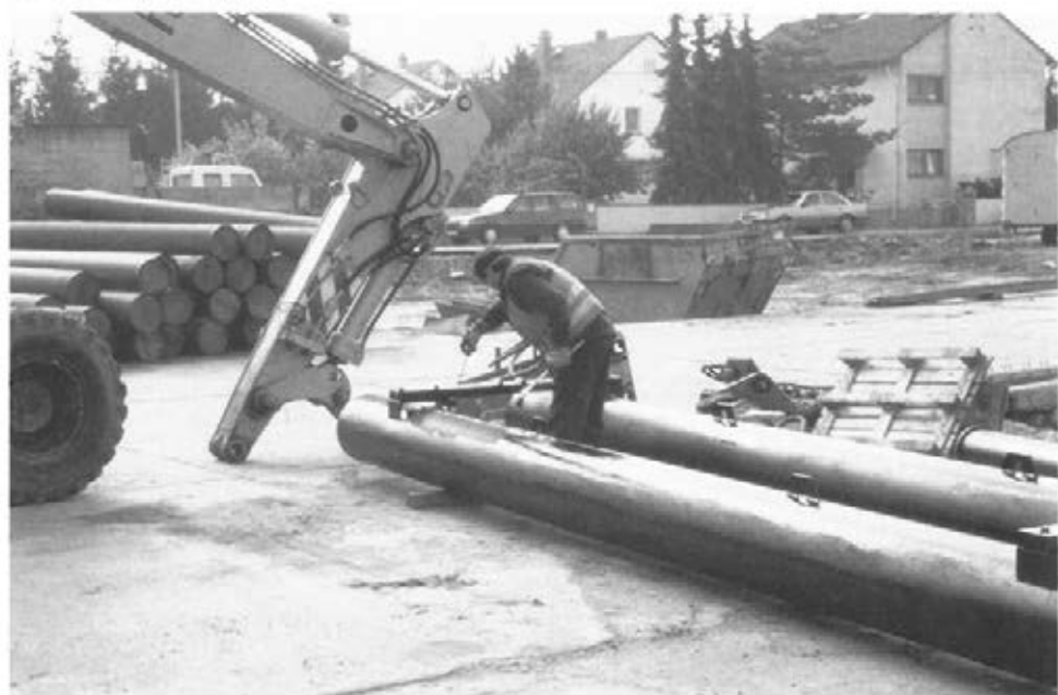
Abbildung 16: Pontone fertigstellen (B 37)
