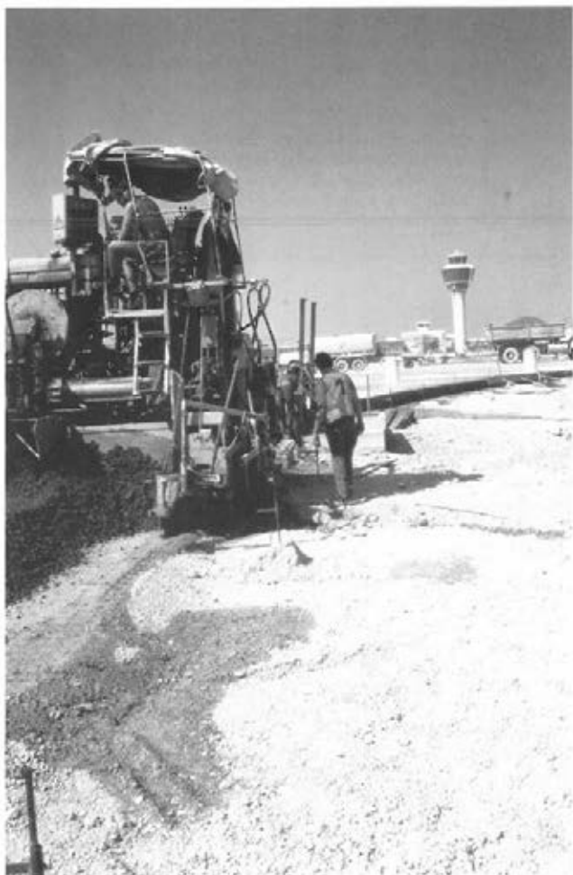
Abbildung 5: Mitgänger am Betondecken- fertiger (C3 5)
