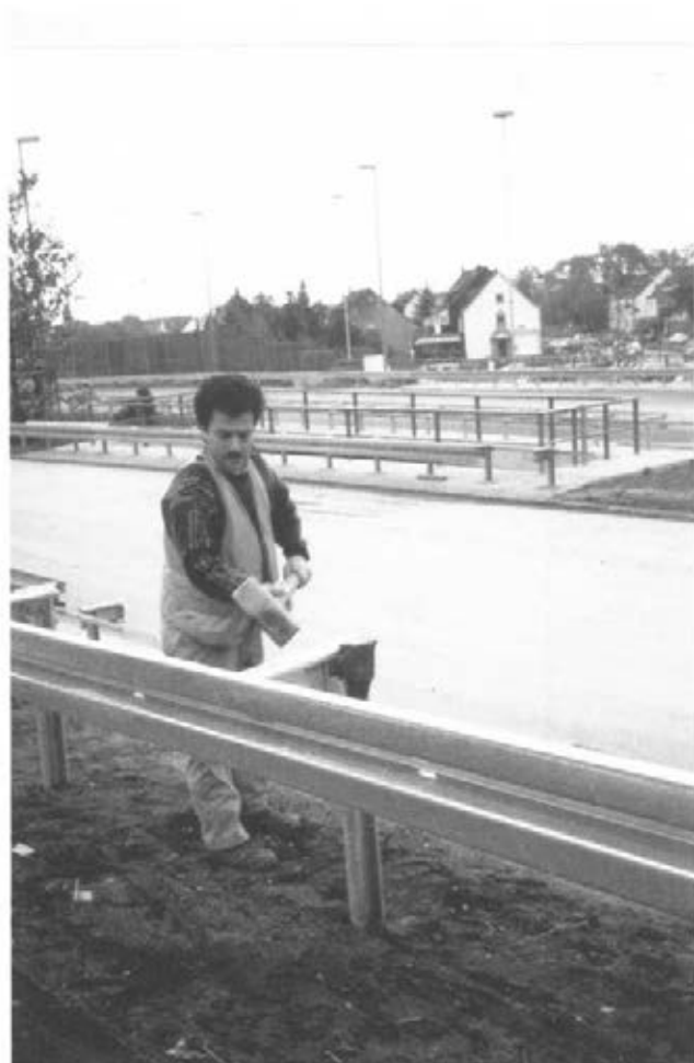
Abbildung 12: Leitplanke richten (C5 13)
