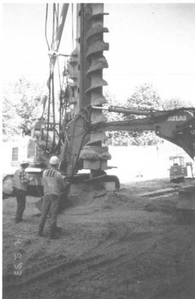
Abbildung 22: Schaufelarbeit am Räumbagger (D 10)
