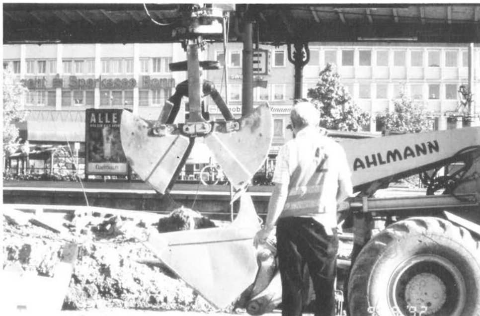
Abbildung 15: Neues Planum anlagen (A 46)
