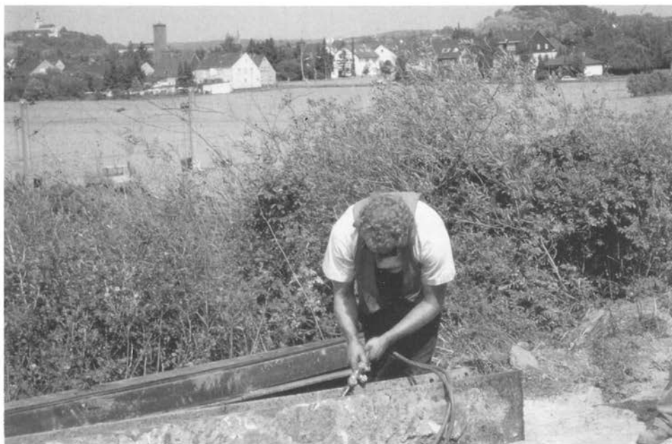
Abbildung 24: Stahlträger abbrennen (B 64)
