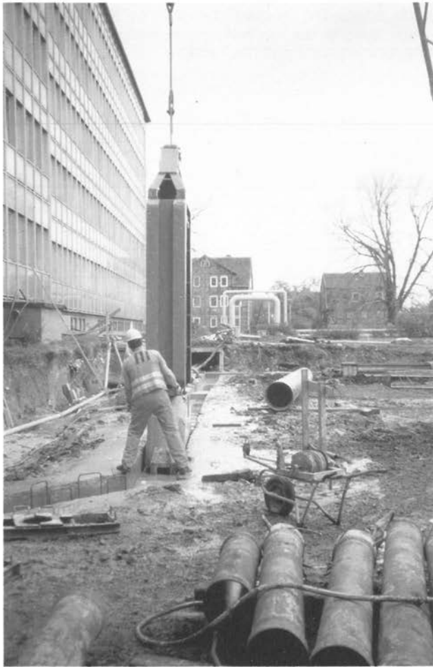
Abbildung 34: Bagger einweisen (D 29)
