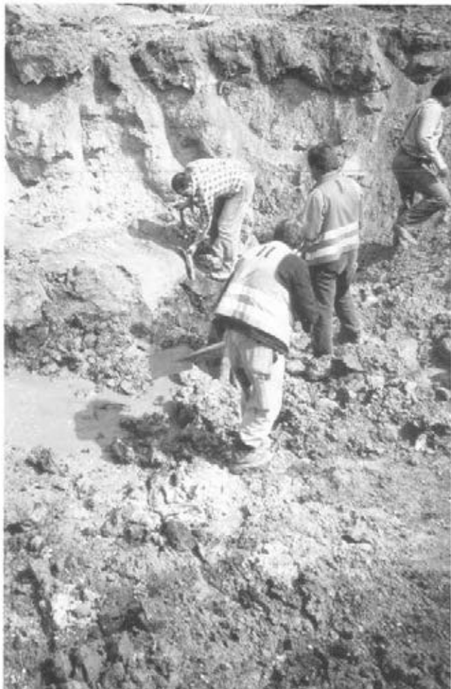
Abbildung 23: Schaufelarbeit nach Rohrbruch (C1 38)
