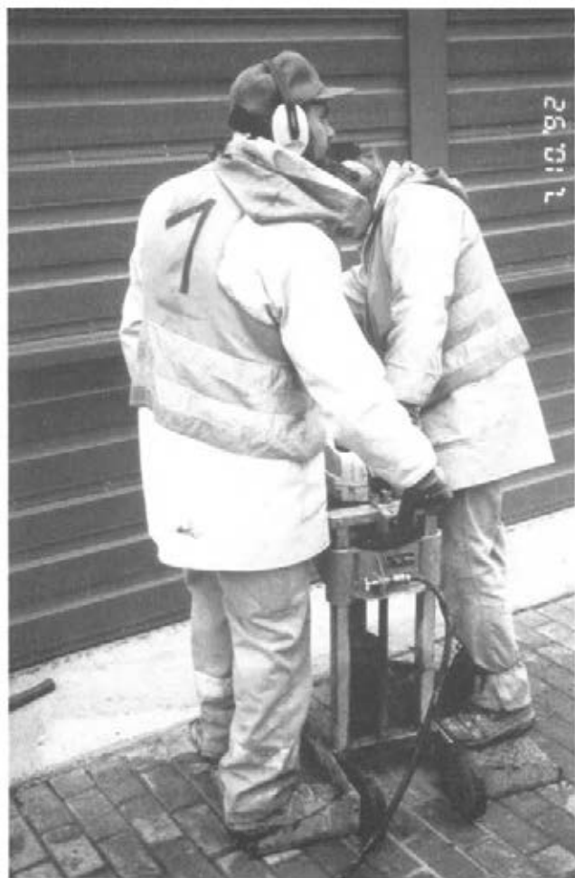
Abbildung 6: Pfostenlöcher in Pflaster bohren (C5 5)
