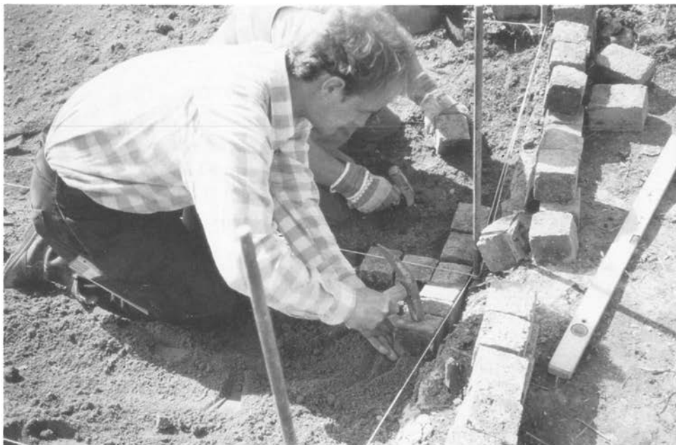
Abbildung 21: Regenwassermulde auspflastern (C1 35)
