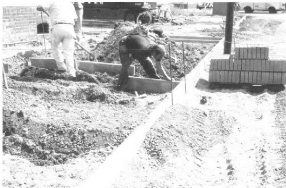
Abbildung 11: Randsteine setzen (C1 16)
