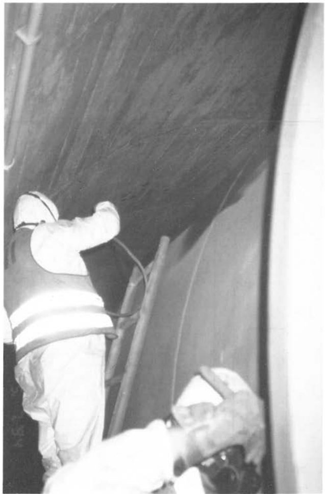
Abbildung 54: Beschichtung „Airless“ spritzen (E 83)
