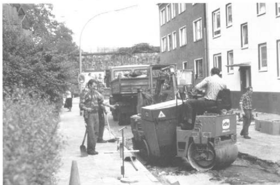
Abbildung 22: Schwarzdeckenhandeinbau (C2 17)
