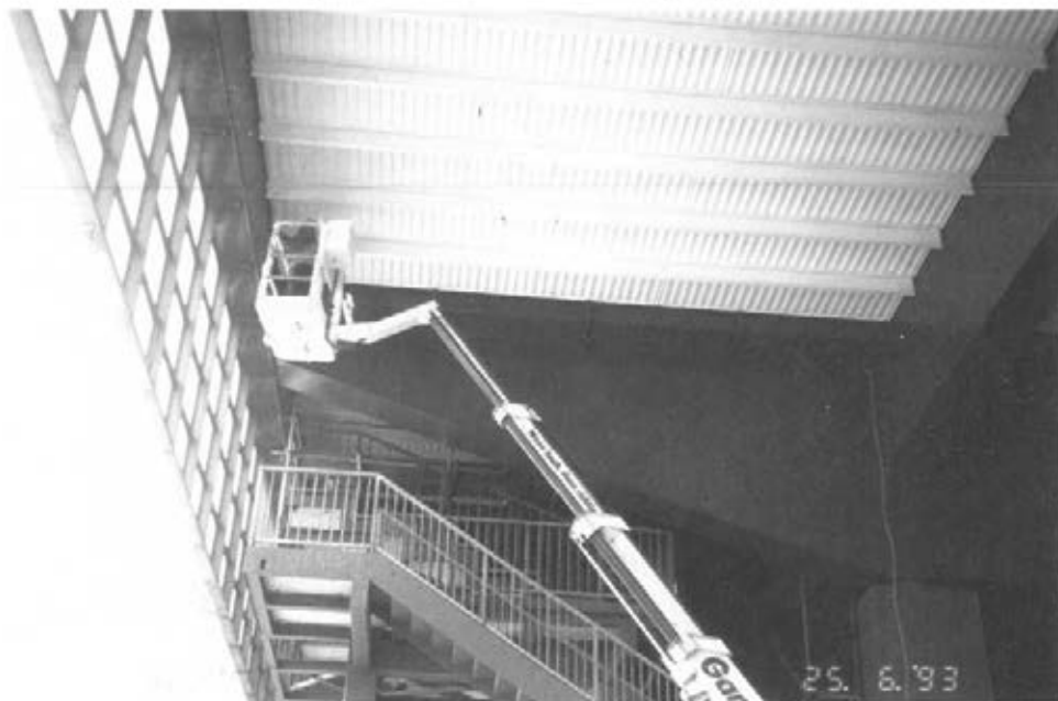
Abbildung 18: Neue Dachinnenbeschichtung von einer Hebebühne aus auftragen (E 15)
