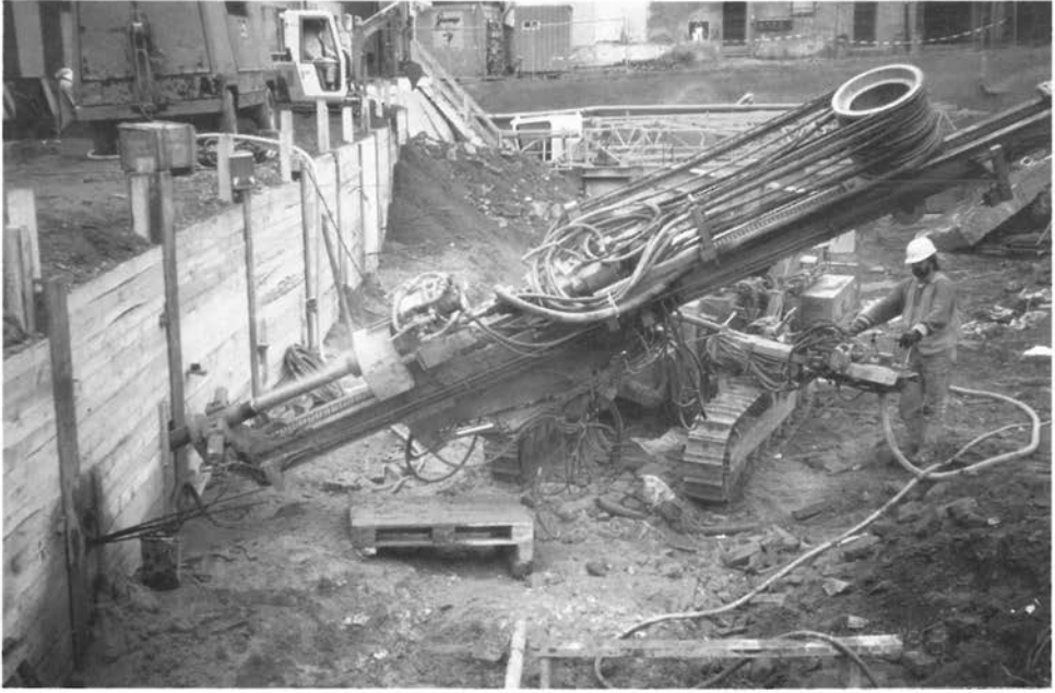
Abbildung 37: Ankerbohrung mit Luftspülung durchführen (D 33)
