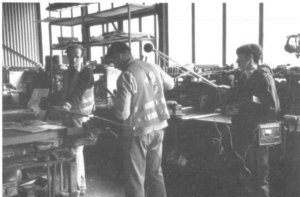
Abbildung 17: Edelstahlanker biegen (B 50, B 51)
