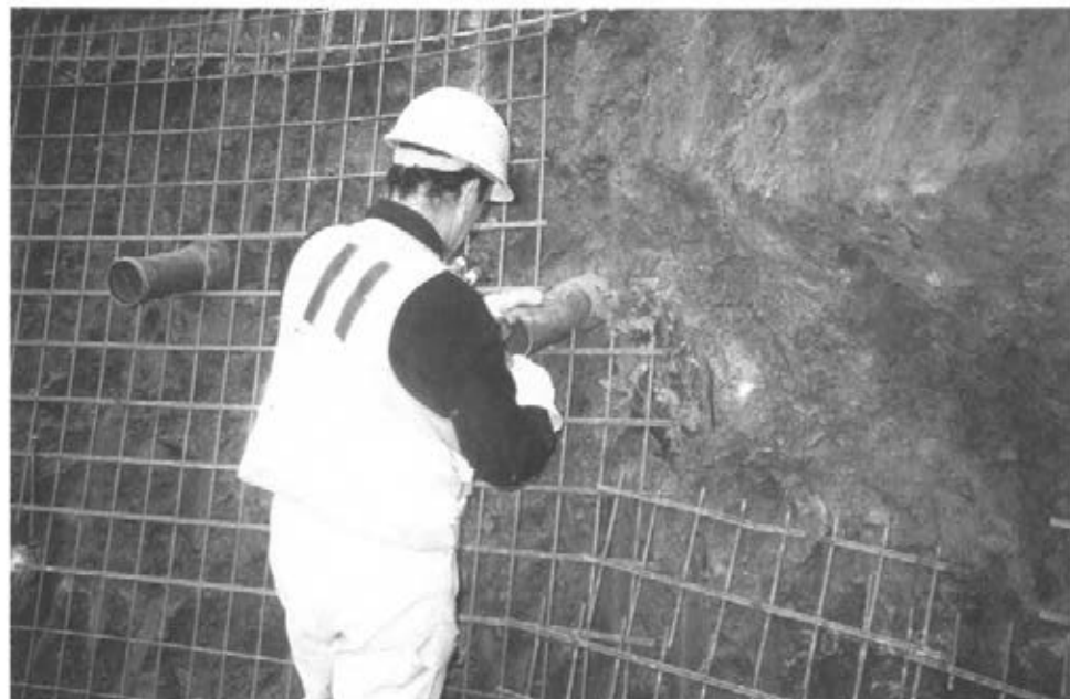
Abbildung 50: Spritzbetonbewehrung anbringen (D 53)
