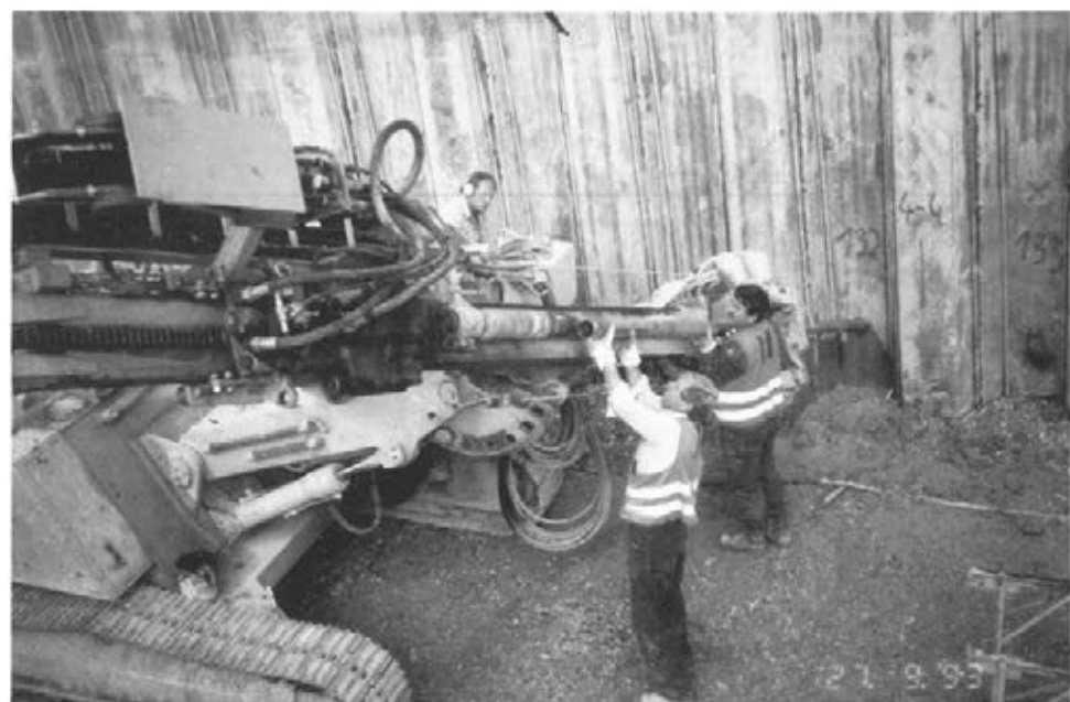
Abbildung 27: Bohrgestänge montieren (D 19)
