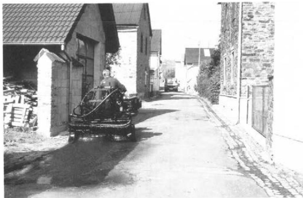
Abbildung 16: Haftgrund aufsprühen (C2 10)
