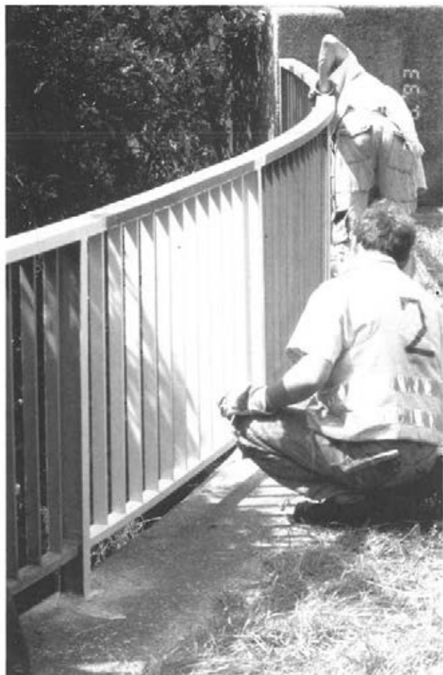
Abbildung 24: Beschichten eines Geländers (E 24)
