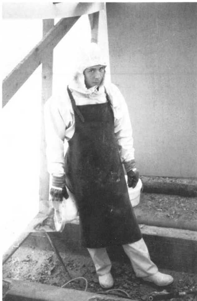
Abbildung 50: Abstrahlen der Betonrippen einer Brücke (E 77)
