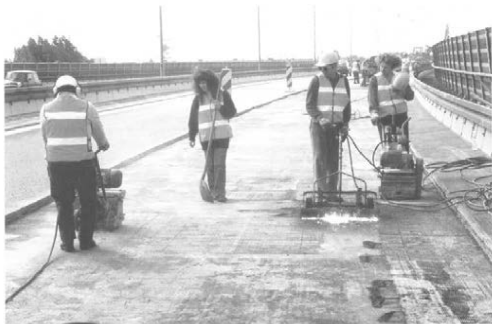
Abbildung 20: Flammstrahlen (C2 15)
