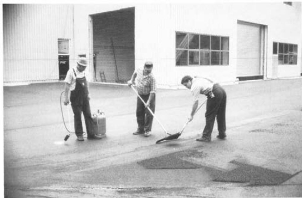
Abbildung 12: Handeinbau von Schwarzdeckenzwickeln (C2 6)
