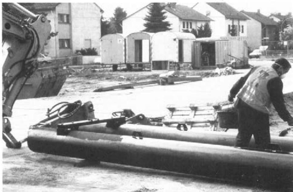
Abbildung 14: Auftriebskörper für Schwimmbagger schweißen (B 33)
