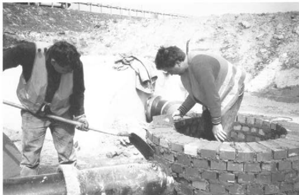
Abbildung 22: Revisionschacht mauern (C1 36)
