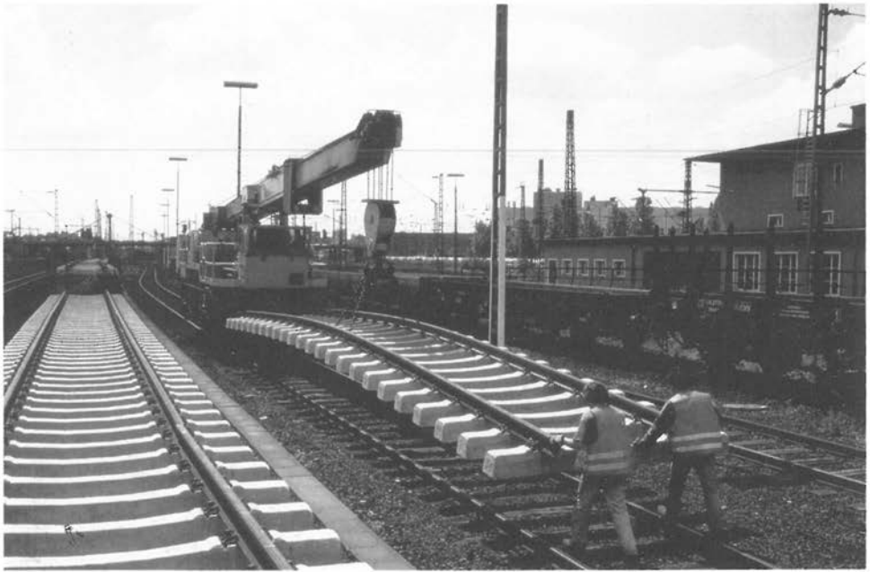
Abbildung 5: Hilfe bei Gleisjochtransport mit Kran (A 16 und A 17)
