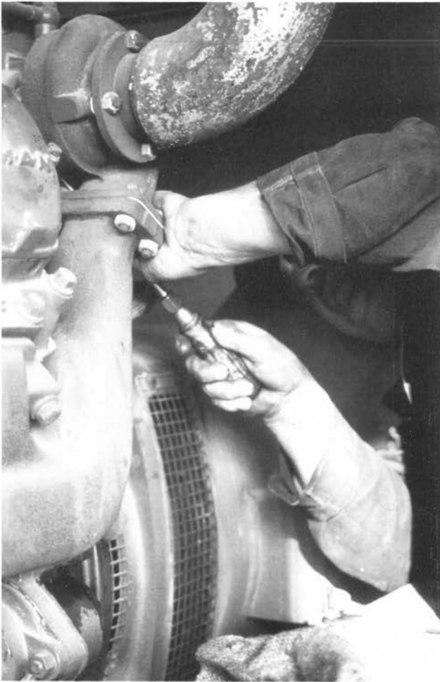
Abbildung 7: Wartungsarbeiten an einem Kompressor (B 8)
