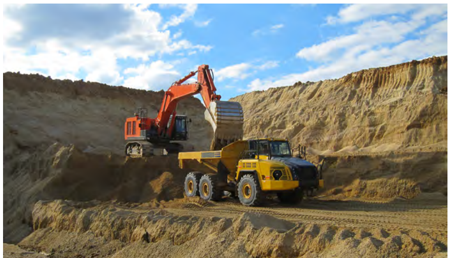
Erdbaumaschinen im Tontagebau
