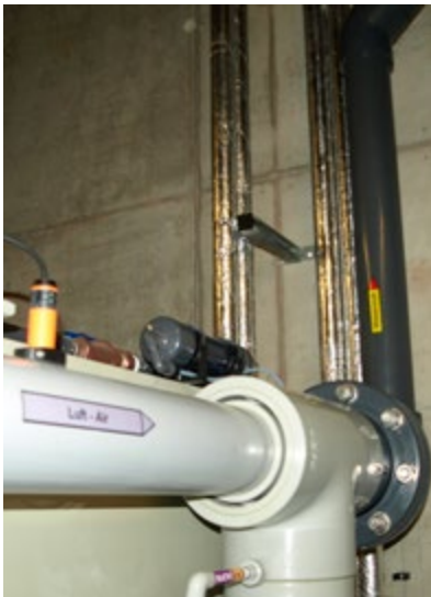
Abb. 5 Luftzufuhr und Wasserstoffableitung
