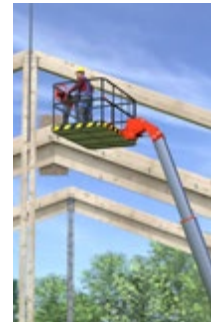
Abb. 131 Montage von Holzbauteilen
