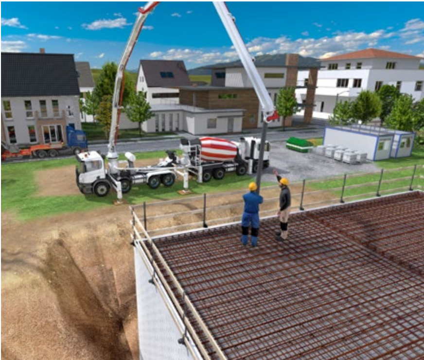
Abb. 105 Einbau von Transportbeton mit Betonpumpe
