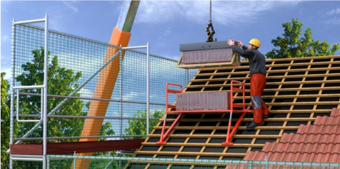
Abb. 137 Ziegelgreifer mit untergehängtem Netz
