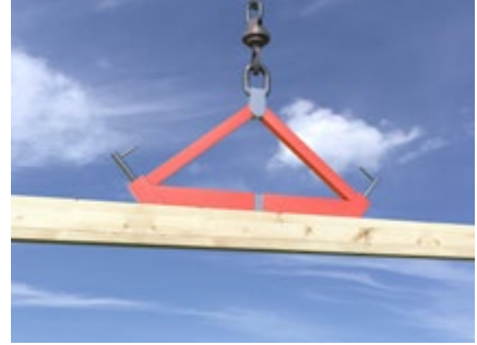
Abb. 132 Beispiel für ein geeignetes Lastaufnahmemittel für Holzbauteile
