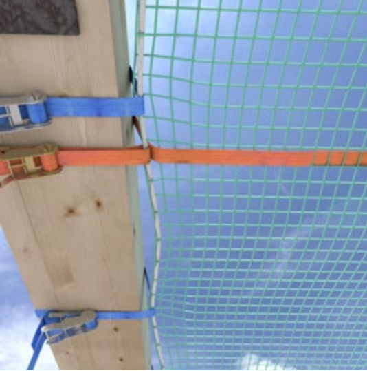
Abb. 63 Spanngurt- Randbefestigung am Holzbalken
