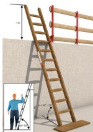
Abb. 42 Sicherung gegen Wegrutschen
