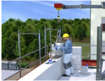
Abb. 98 Verarbeiten großformatiger Steine mit Hilfe eines Steinversetzkrans
