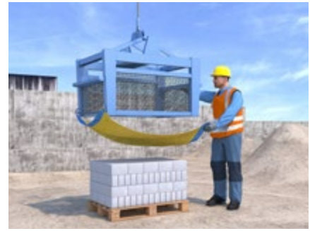
Abb. 99 Steingreifer mit Auffangplane
