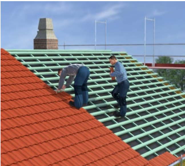
Abb. 134 Arbeiten auf dem Steildach
