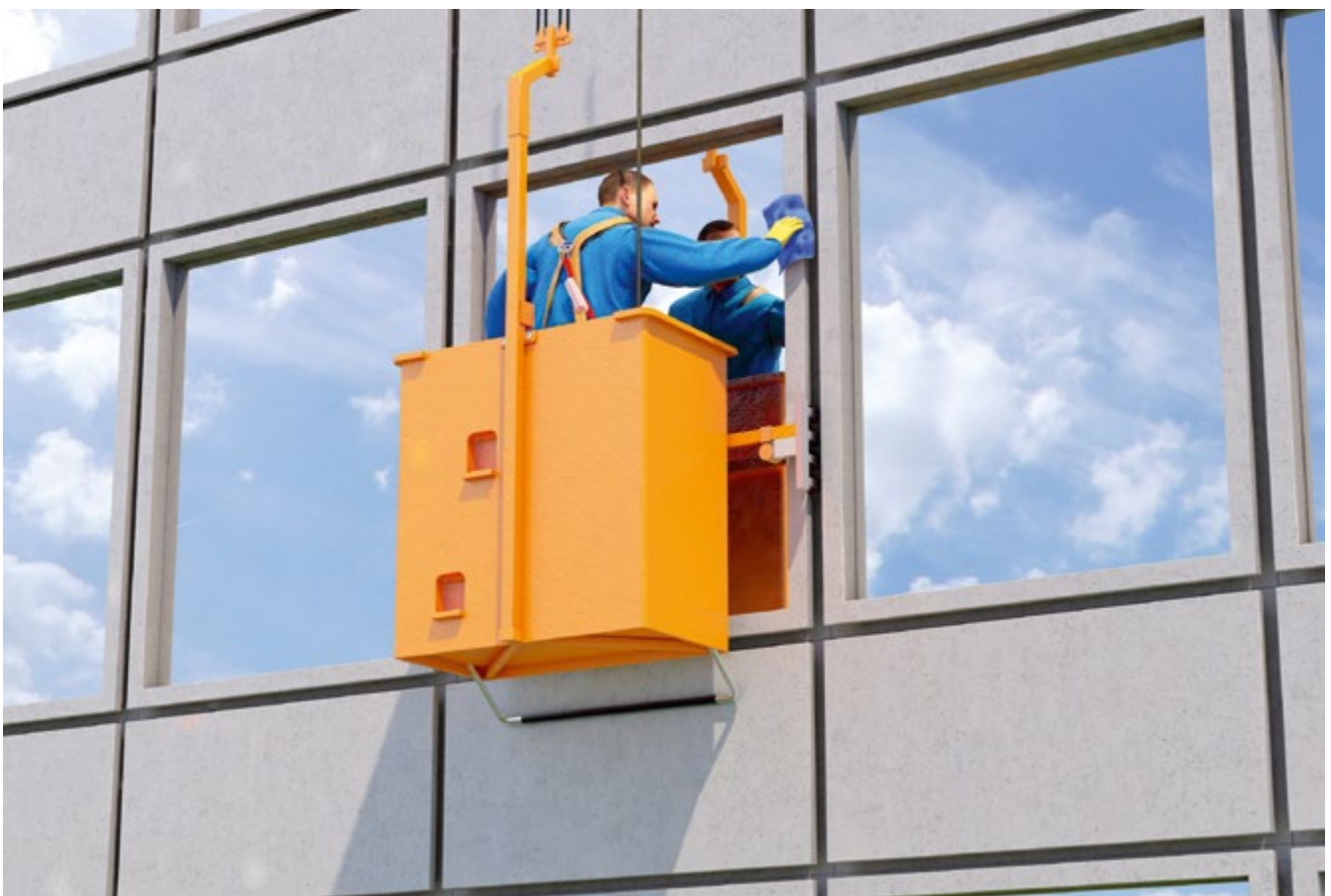
Abb. 77 Befahranlage im Einsatz
