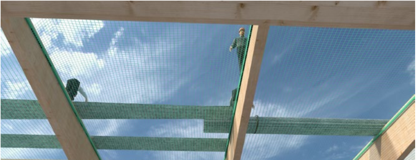
Abb. 58 Schutznetz im Einsatz
