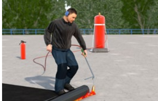
Abb. 21 Dacharbeiten mit Handbrenner
