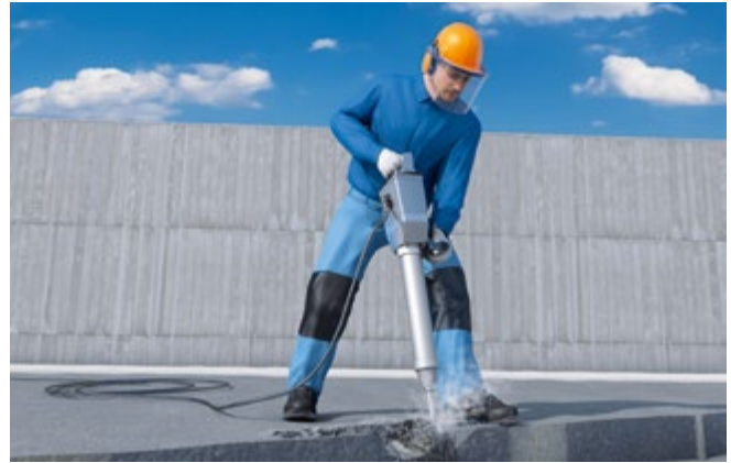
Abb. 40 Stemmarbeiten mit geeigneter PSA
