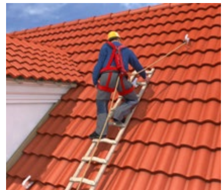
Abb. 6 Arbeiten auf dem Dach mit einer Dachauflegeleiter und PSA gegen Absturz
