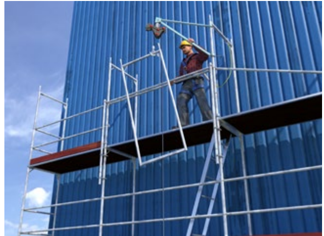
Abb. 117 Ergonomischer Transport von Gerüstbauteilen
