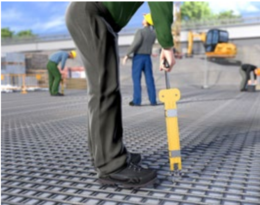
Abb. 30 Bewehrungsbindegerät im Einsatz
