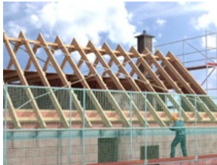
Abb. 129 Anbringen der Traufschalung
