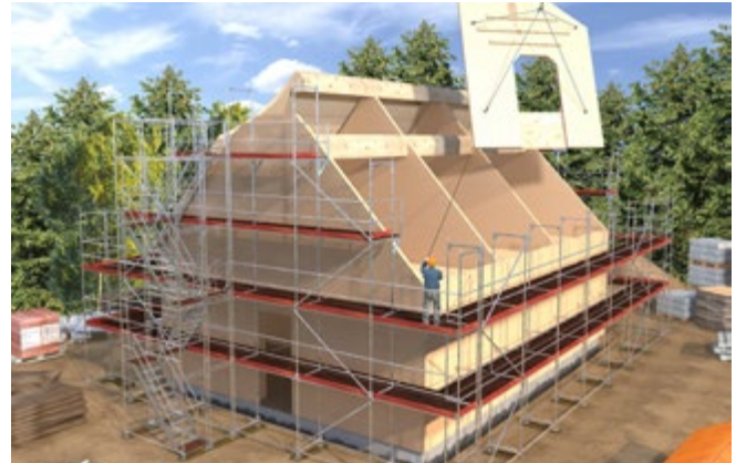
Abb. 110 Montage von Holzbauteilen
