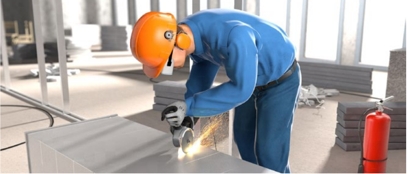
Abb. 1 Persönliche Schutzausrüstung beim Schneiden von Metall
