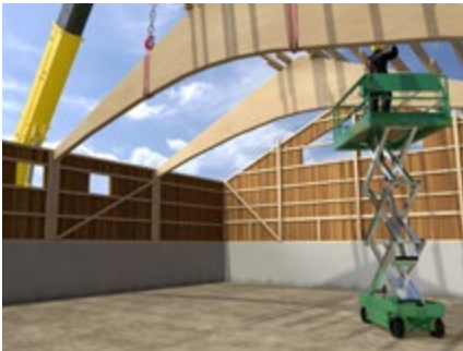
Abb. 128 Bindermontage mit Hubarbeitsbühne
