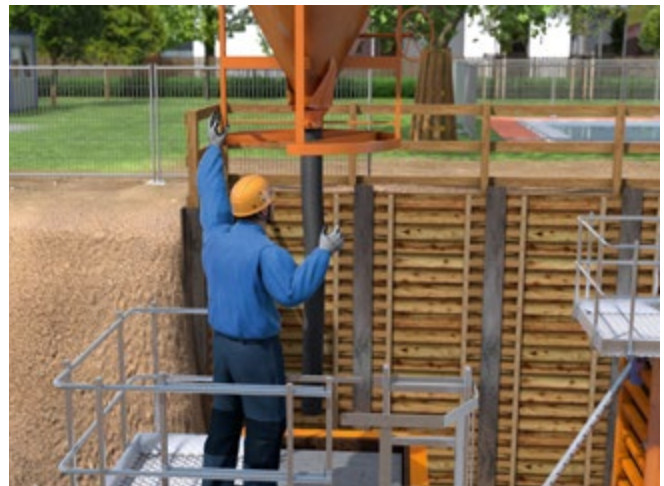
Abb. 38 Persönliche Schutzausrüstungen bei Betonierarbeiten
