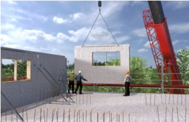
Abb. 109 Montage von Fertigteilen aus Stahlbeton
