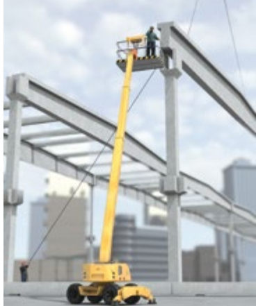
Abb. 111 Sichere Arbeitsplätze bei Montagearbeiten
