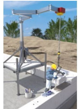
Abb. 32 Versetzgerät zum Mauern von großformatigen Steinen
