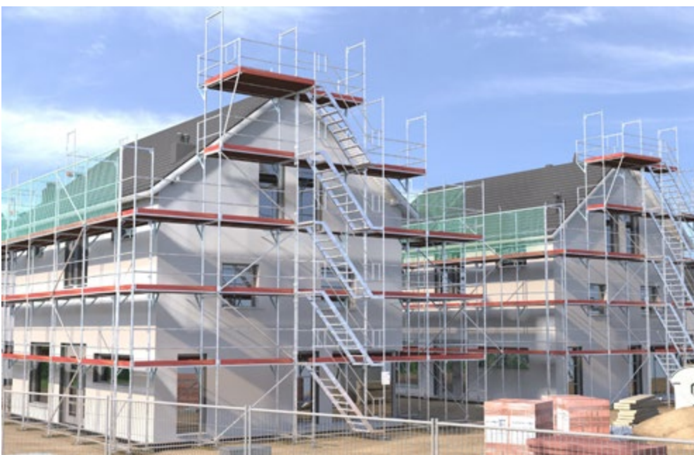
Abb. 53 Fachgerechter Zugang zum Gerüst
