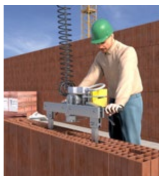
Abb. 102 Versetzhilfe für Mauersteine
