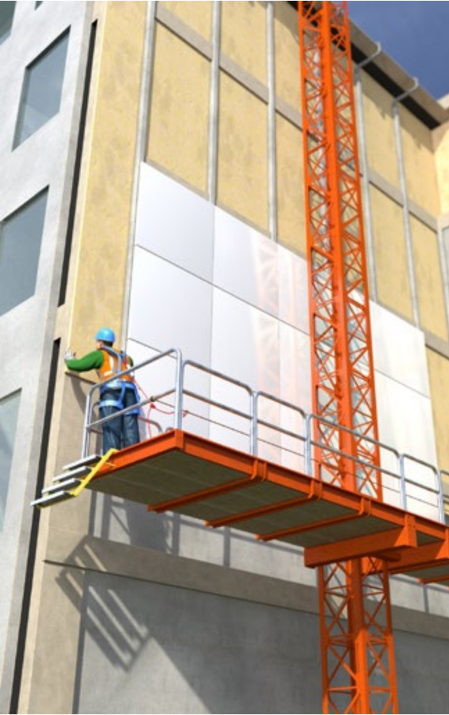
Abb. 126 Montage einer Metallfassade
