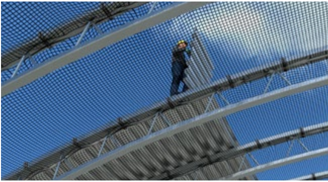
Abb. 59 Schutznetz bei Trapezblechmontage
