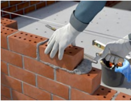
Abb. 97 Mauern mit Klinkern
