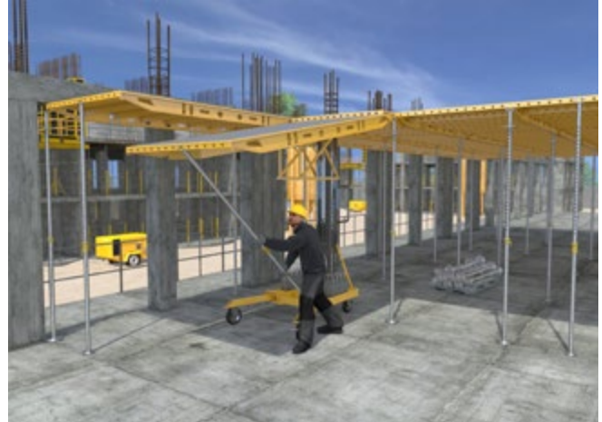
Abb. 119 Montage einer Deckenschalung mit Schalwagen von unten
