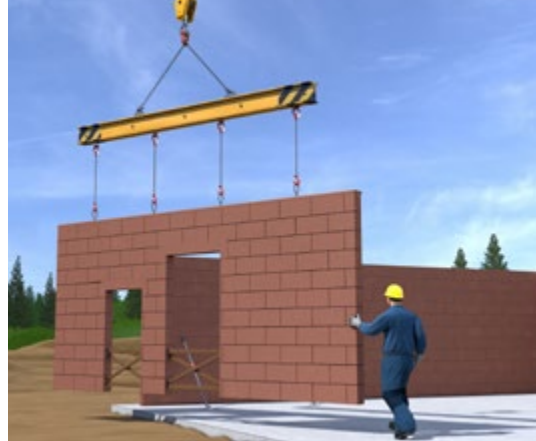
Abb. 113 Angeschlagene Mauertafel mit gesicherten Öffnungen
