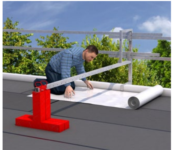
Abb. 135 Absturzsicherung bei Flachdacharbeiten
