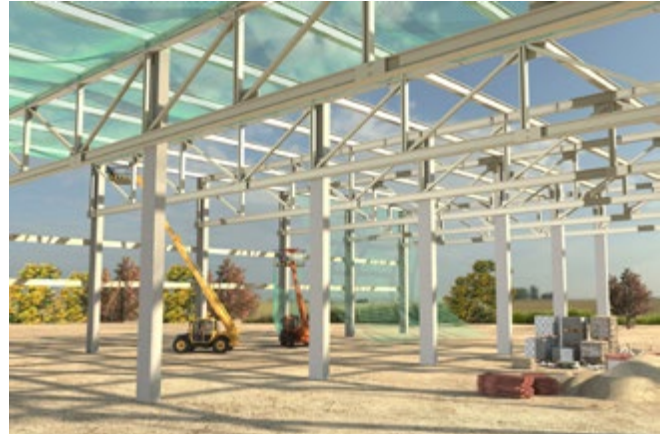
Abb. 57 Montage von Schutznetzen mit Hubarbeitsbühnen
