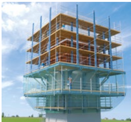
Abb. 141 Kletterschalung an turmartigem Bauwerk
