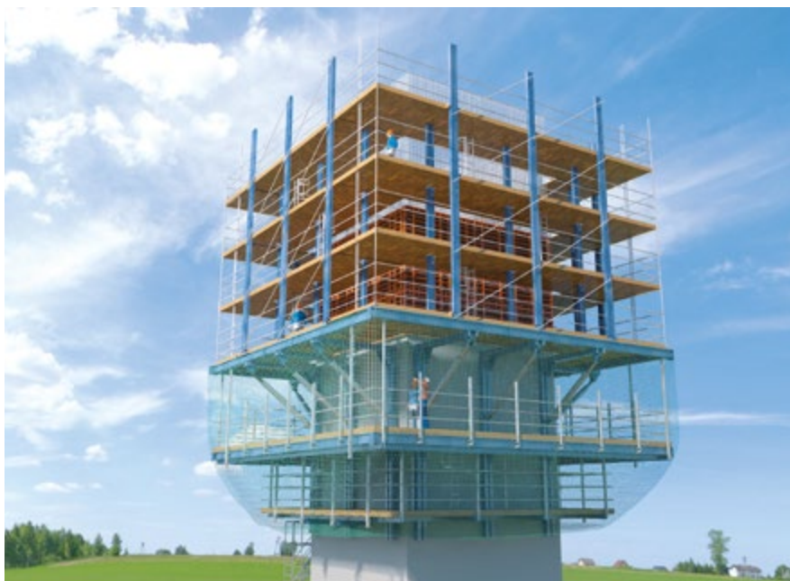
Abb. 54 Kletterschalung an turmartigem Bauwerk
