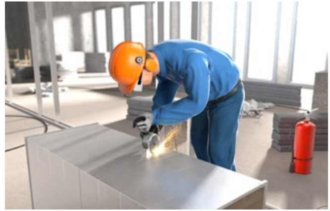
Abb. 28 Persönliche Schutzausrüstung beim Schneiden von Metall
