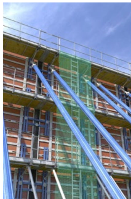
Abb. 55 Wandschalungssystem mit Seitenschutz
