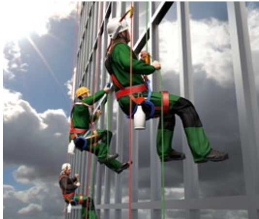
Abb. 145 Endreinigung der Aussenfassade mit SZP
