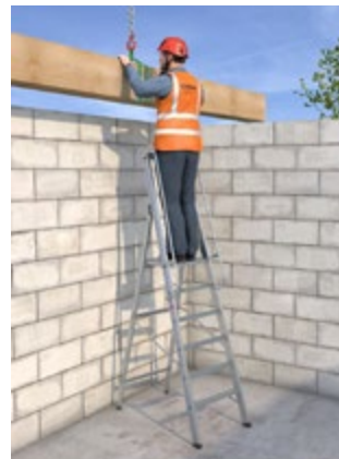
Abb. 43 Abschlagen von Lasten mithilfe einer leichten Plattformleiter
