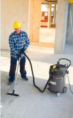
Abb. 1 Baustellenreinigung mit Staubsauger
