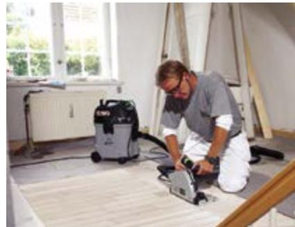
Abb. 5 Entstaubung beim Sägen
