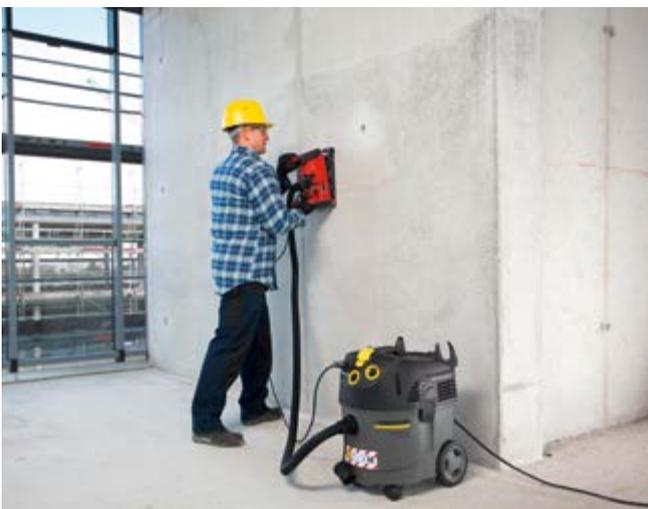
Abb. 3 Abgesaugte Mauernutfräse
