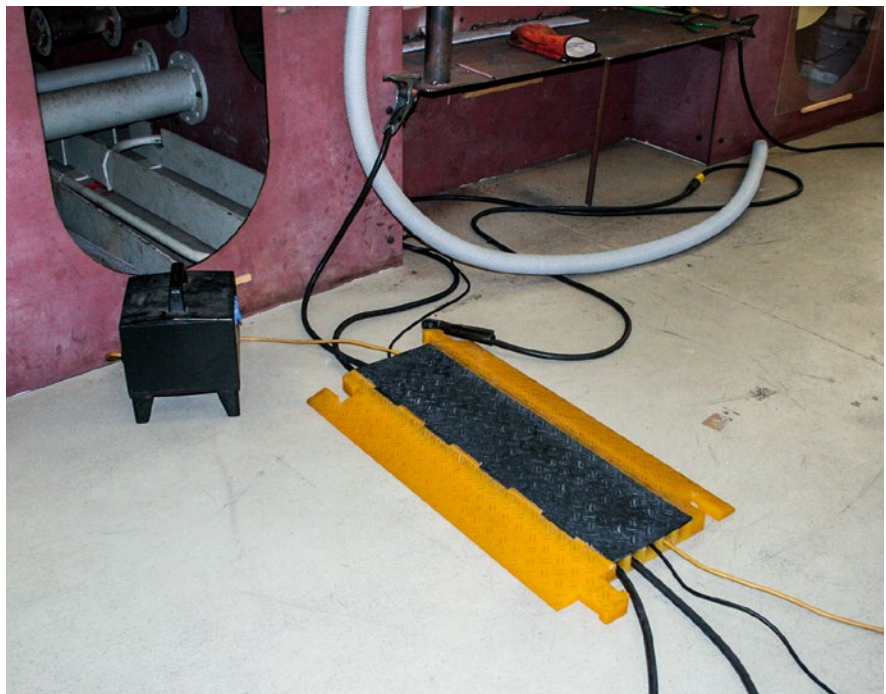
Abb. 3-4 Sicherung der Schweißleitung gegen Beschädigung beim Überfahren.
