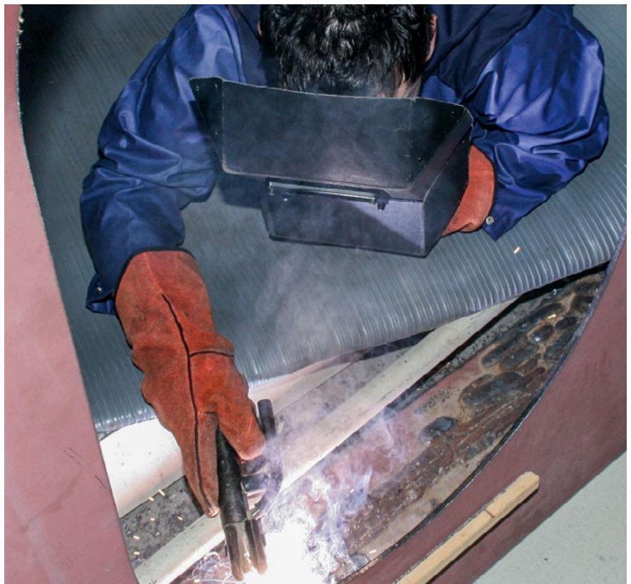
Abb. 5-2 Lichtbogenschweißen unter erhöhter elektrischer Gefährdung mit Hilfe isolierender Zwischenlage
