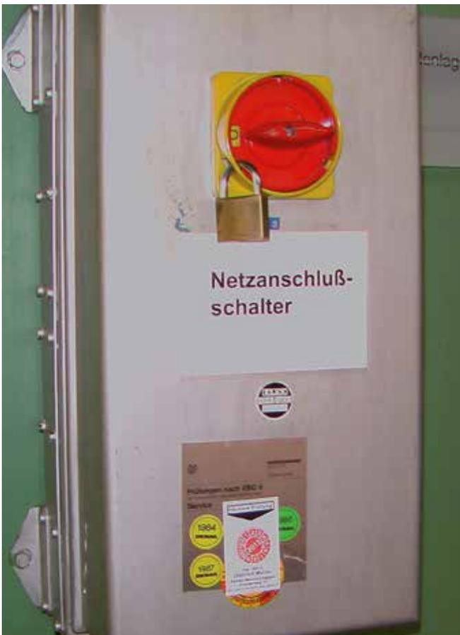
Bild 7-2: Der Kranführer schaltet den Netzanschlusschalter aus
