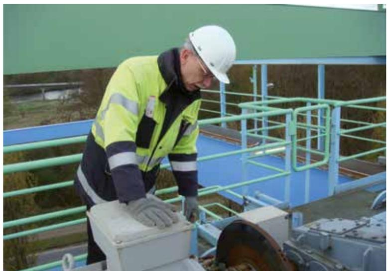
Bild 4-6: Der Kranführer nimmt die Bremse in Augenschein
