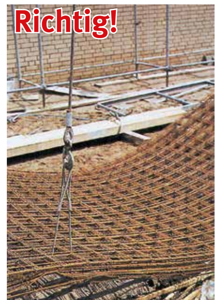
Bild 16-6: Baustahlmattenhaken oder diese kurzen Durchsteckseile sind die richtige Methode!
