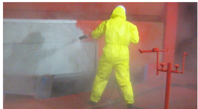
Abb. 20 Reinigung mit einem manuellen Hochdruckreiniger
