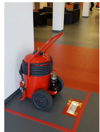
Abb. 46 Fahrbarer Schaum-Feuerlöscher
