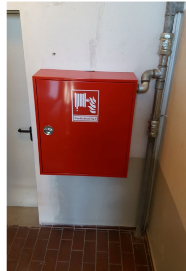
Abb. 55 Wandhydrantenschrank
