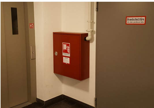
Abb. 66 Wandhydrantenschrank
