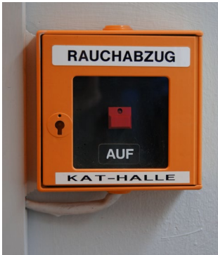
Abb. 40 Auslöseeinrichtung Rauchabzug
