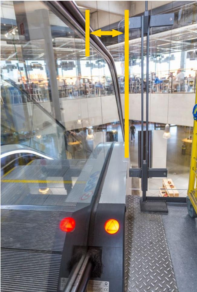
Abb. 45 Der Abstand zwischen Handlauf der Fahrtrepppe und feststehenden Teilen muss mind. 80 mm betragen.
