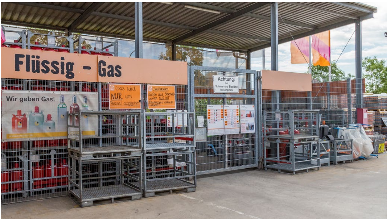
Abb. 92 Größere Mengen an Flüssiggasflaschen am besten im Freien lagern, da durch die natürliche Belüftung das Vorhandensein explosionsfähiger Atmosphären weitgehend verhindert wird.
