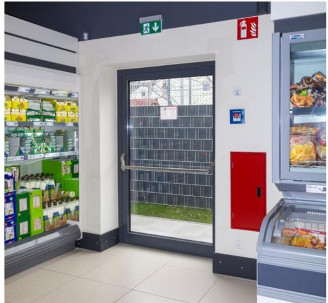
Abb. 27+28 Kennzeichnen Sie Flucht- und Rettungswege durch nachleuchtende Piktogramme und installieren Sie ggf. Sicherheitsbeleuchtungen.
