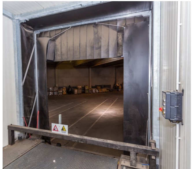
Abb. 62 Der sich ergebende Spalt kann mit flexiblen Abdichtungen zwischen Fahrzeugaufbau und Gebäudewand geschlossen werden.
