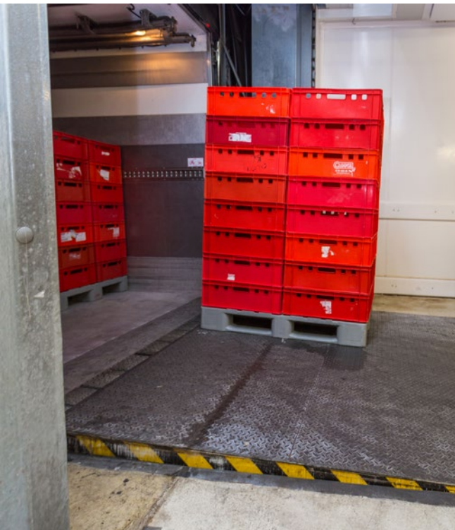
Abb. 63 Ladebrücken/-bleche müssen rutschhemmend und ausreichend breit sowie mit einer selbsttätig wirkenden Sicherung gegen Verschieben ausgerüstet sein.
