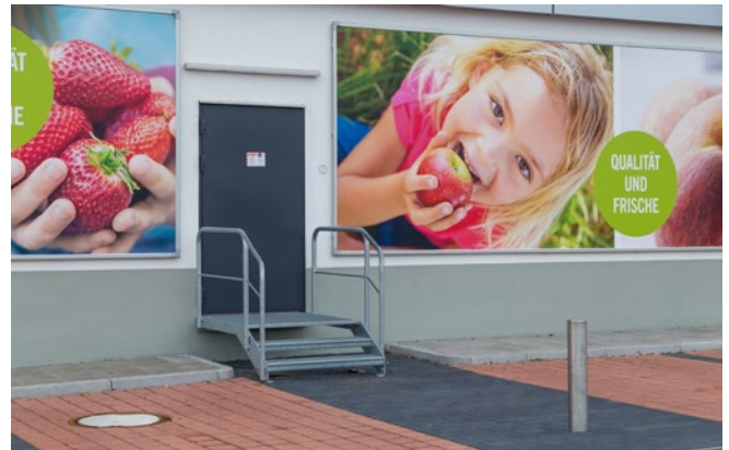
Abb. 31 Auch die Abgrenzung des Bereiches durch Poller ist möglich.
