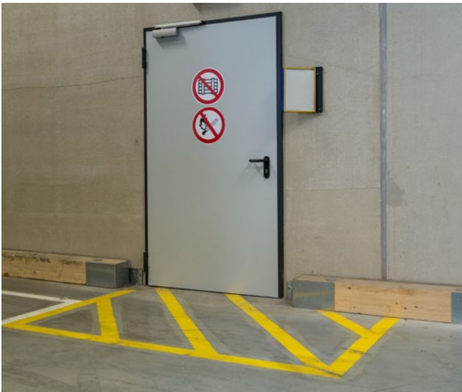
Abb. 30 Um einem Zustellen der Türe entgegenzuwirken, sollte auf der Außenseite das Verbotsschild „Abstellen oder Lagern verboten“ angebracht sein.
