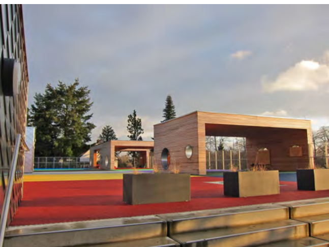
Abbildung 21: Eindruck von der beispielbaren Dachfläche
