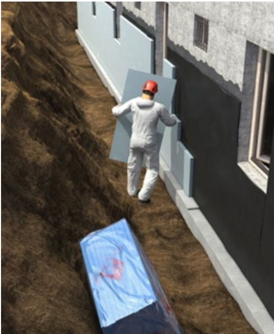
Abb. 91 Abdichtungsarbeiten am Kellergeschoss
