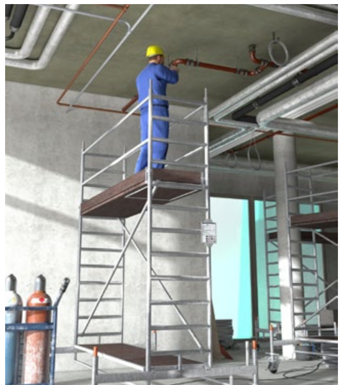
Abb. 118 Montage mit Fahrbarer Arbeitsbühne
