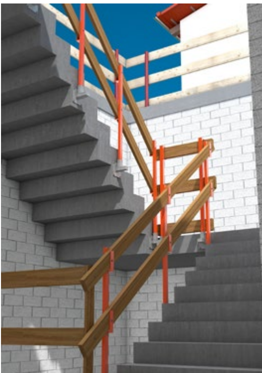
Abb. 4 Treppenaufgang mit Seitenschutz
