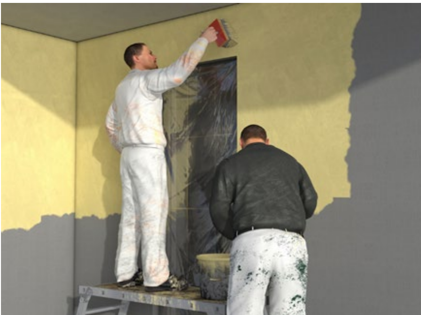
Abb. 130 Streichputzauftrag
