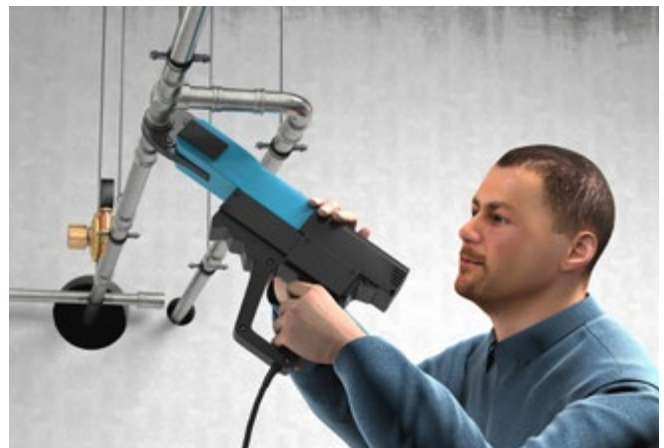
Abb. 117 Herstellung einer Pressverbindung
