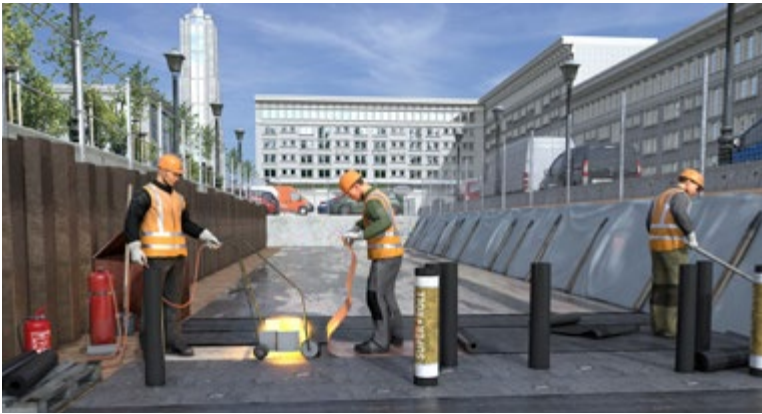
Abb. 89 Abdichtungsarbeiten
