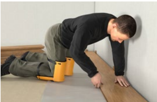
Abb. 93 Verlegen von Parkettboden
