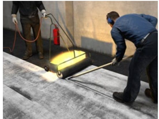
Abb. 90 Aufbringen von Schweißbahnen
