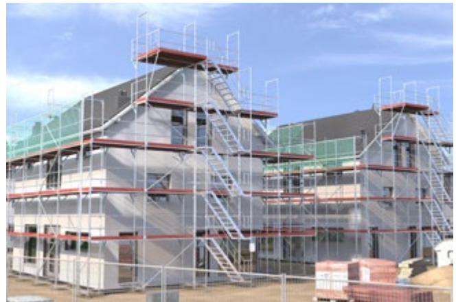
Abb. 60 Fachgerechter Zugang zum Gerüst
