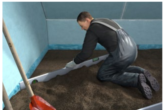
Abb. 106 Estricheinbau
