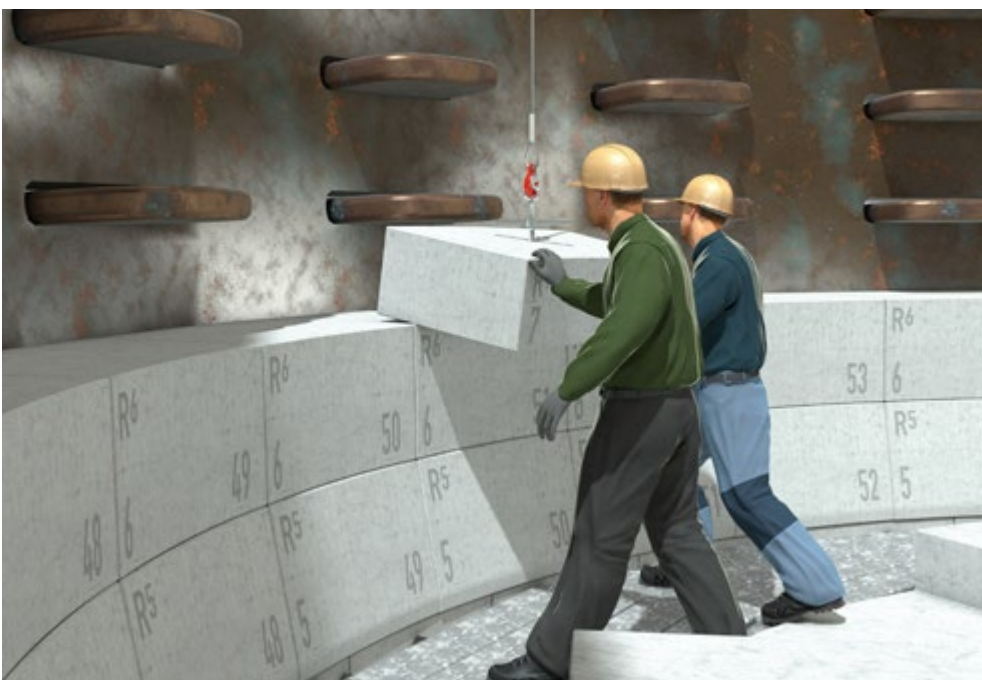
Abb. 137 Versetzen von Feuerfestfertig- teilen im Hochofen
