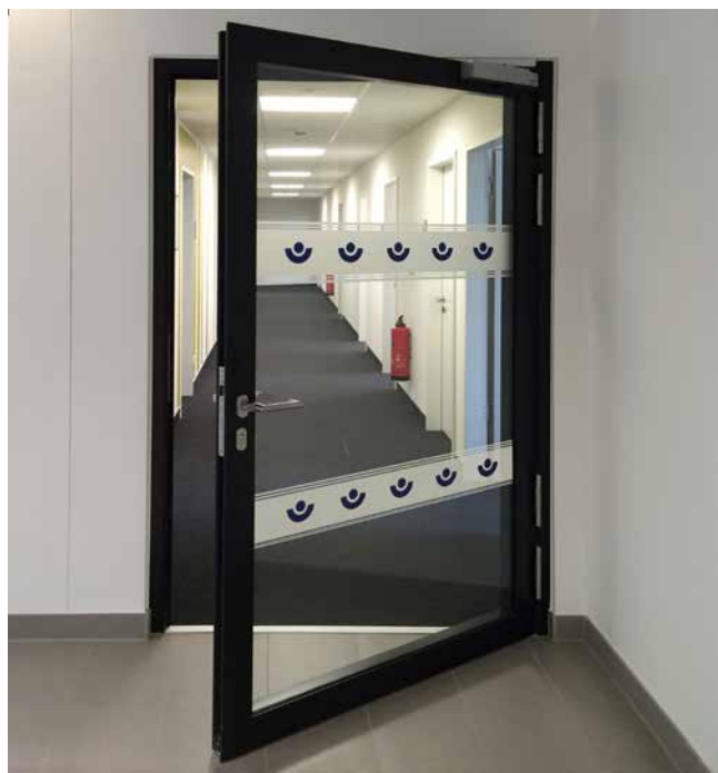
Abb. 3 Glasfläche mit barrierefreier Kennzeichnung in Augenhöhe
