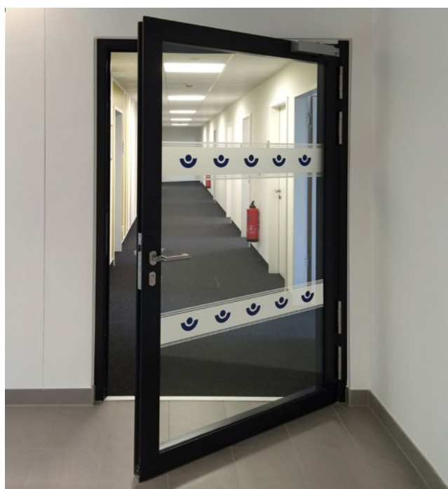
Abb. 3 Glasfläche mit barrierefreier Kennzeichnung in Augenhöhe
