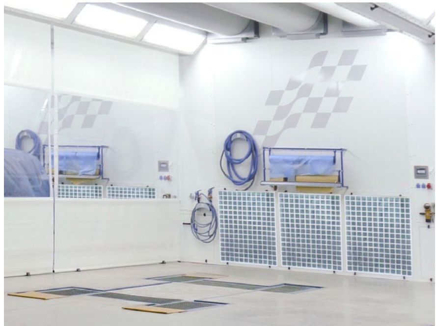
Abb. 5 Vorbereitungsplatz mit diagonaler Luftführung (senkrechte wandseitige Absaugung)
