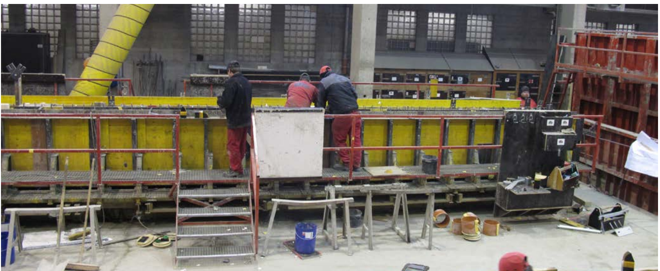
Abb. 32 Betonieren eines Betonfertigteilsbinders mit seitlichen Laufstegen
