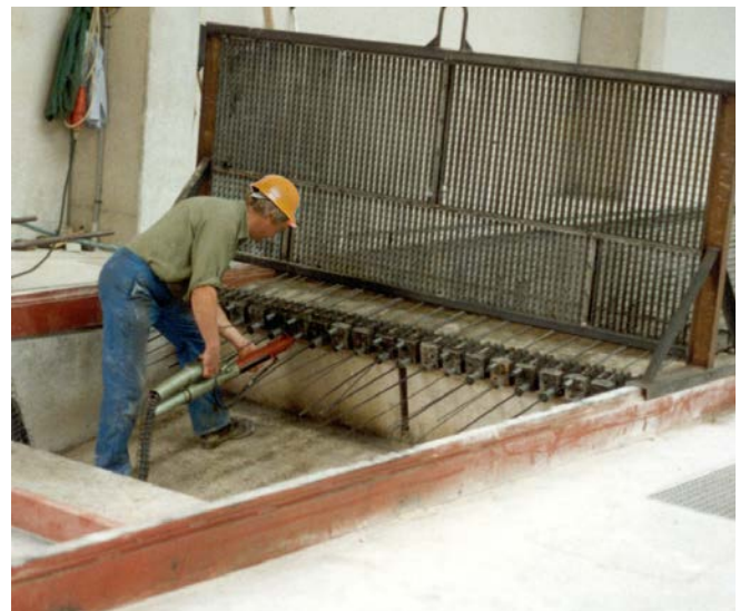
Abb. 36 Schutzzaun beim Spannen
