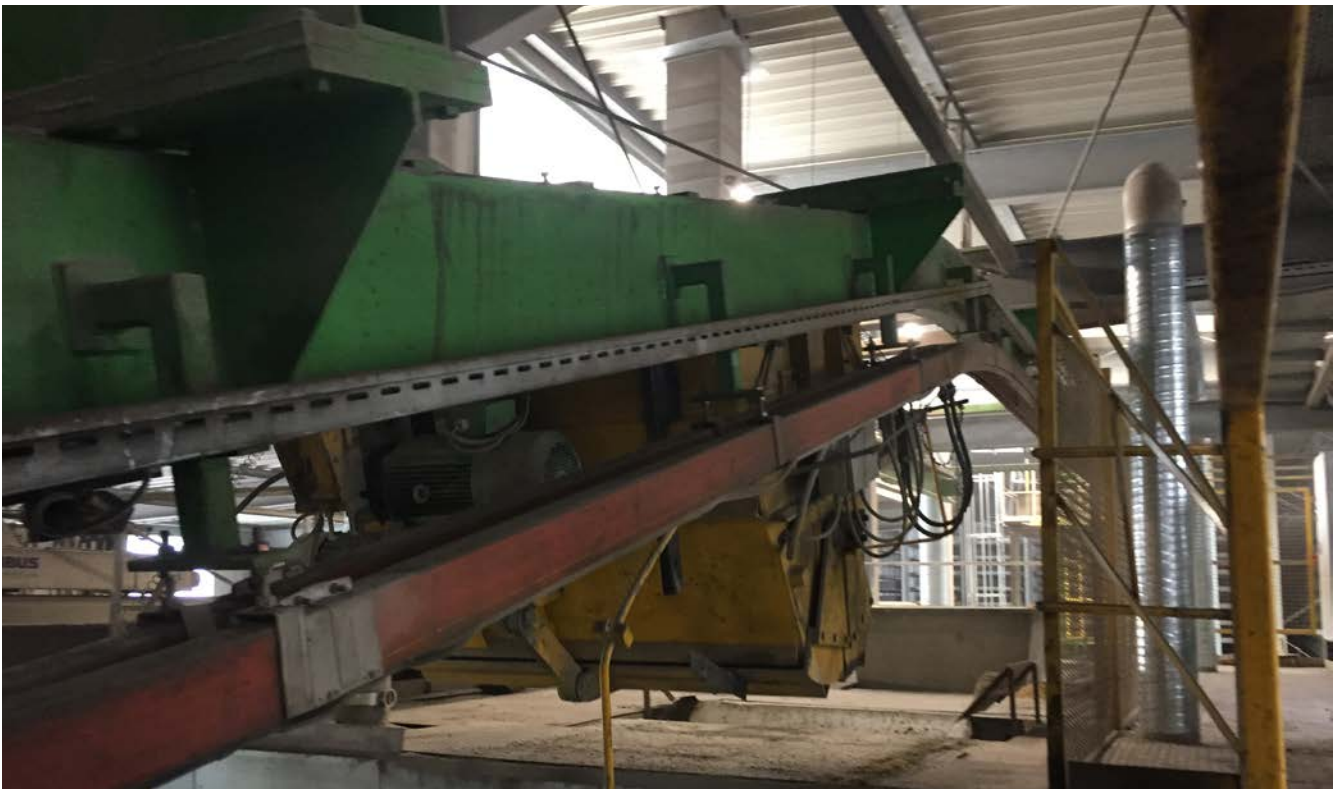
Abb. 102 Betontransport mit Kübelbahn
