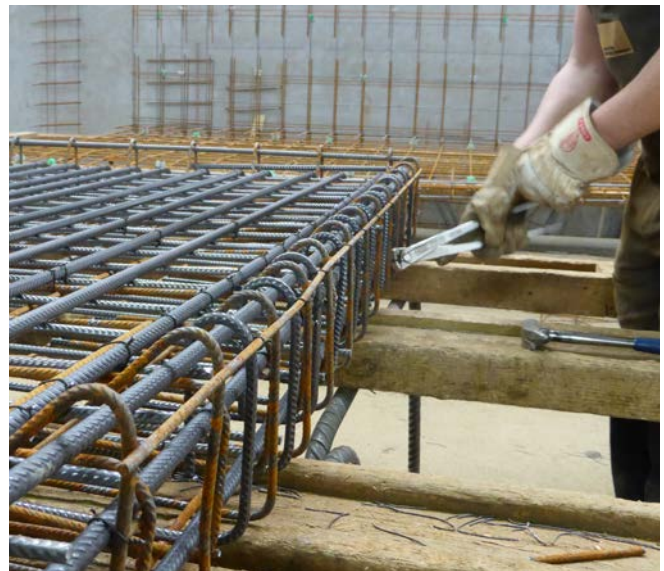
Abb. 25 ergonomisch günstige Arbeitshaltung bei Bewehrungsarbeiten
