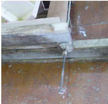
Abb. 22 Stolpergefahr durch überstehende Verbindungsmittel
