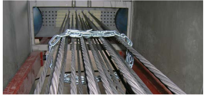
Abb. 30 Absicherung der Spanndrähte durch Ketten
