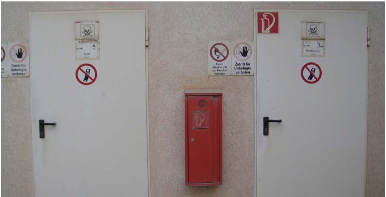
Abb. 88 getrennte Lagerung von Härter und Beschleuniger
