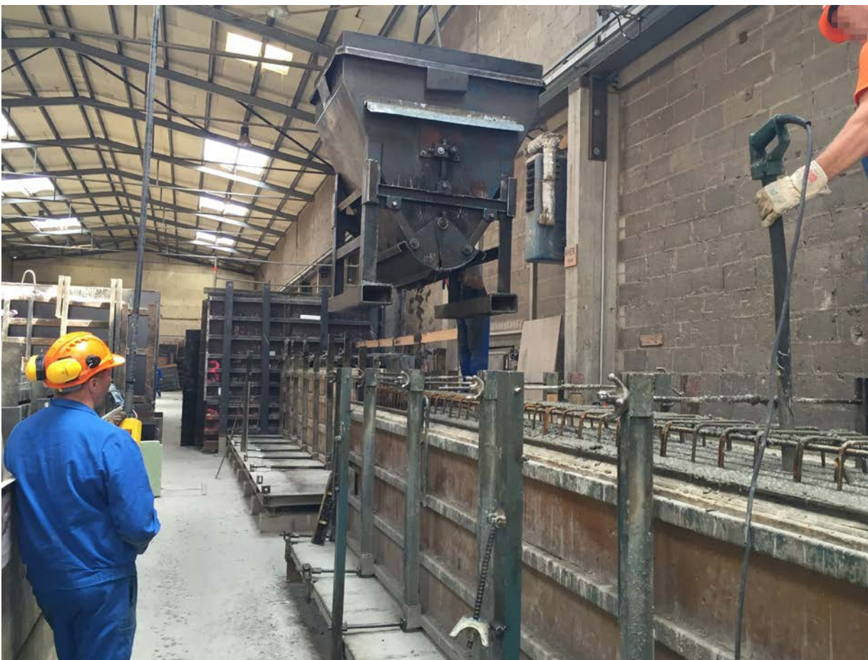
Abb. 104 Betonkübel am Kran
