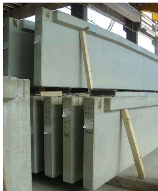
Abb. 34 Negativbeispiel für die Lagerung von Betonfertigteilen
