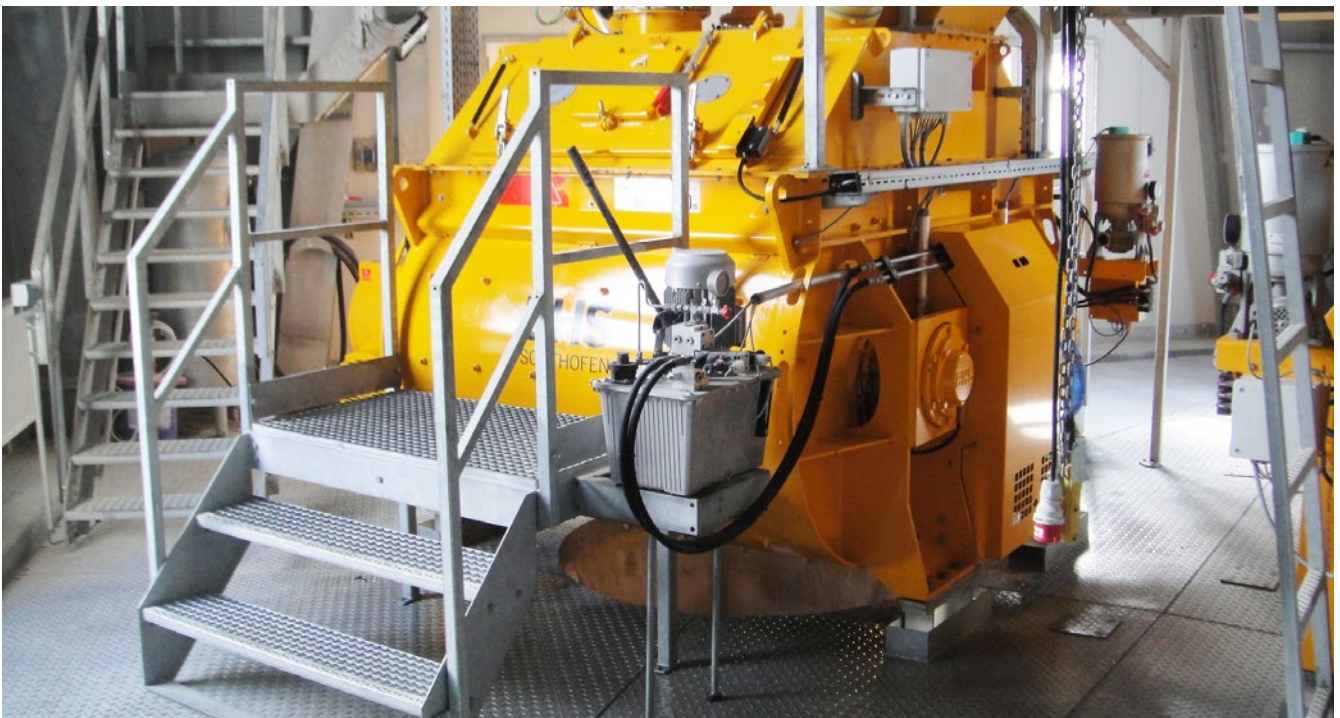
Abb. 31 Betonmischer mit Einstiegshilfe – Podest
