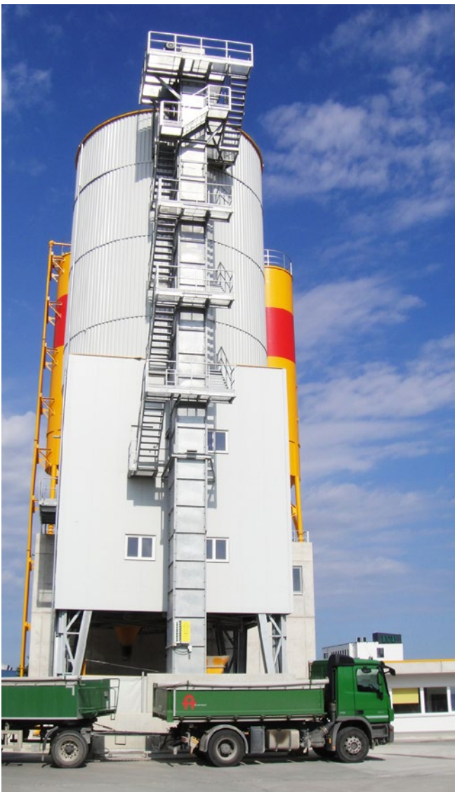
Abb. 19 Turmanlage mit Becherwerk
