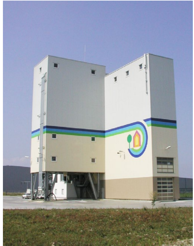
Abb. 2 Eingehauste Frischbetonanlage
