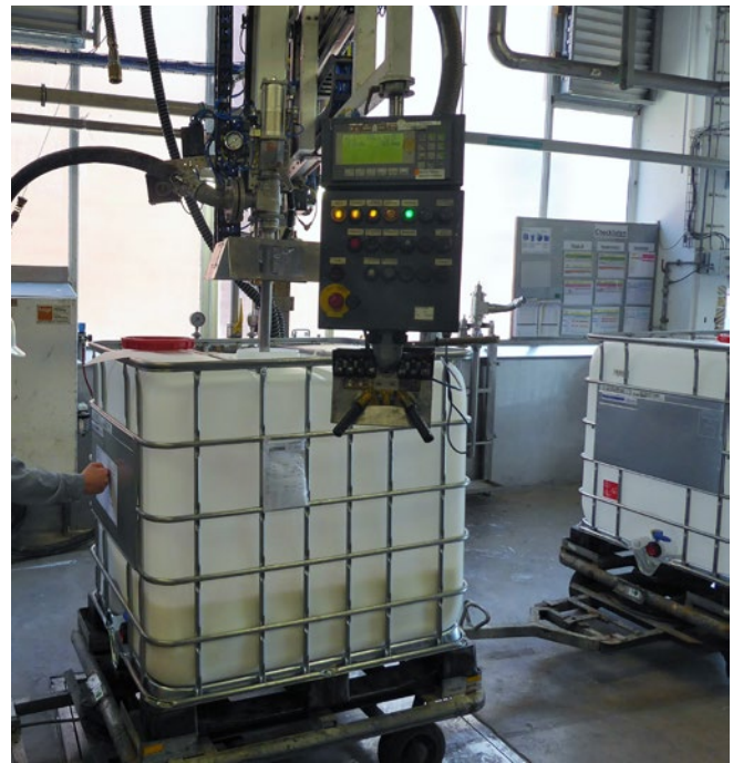
Abb. 39 Containerabfüllung mit Erdungsüberwachung
