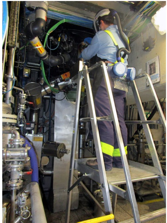
Abb. 24 Aufstiegshilfe zur Probenahmestelle
