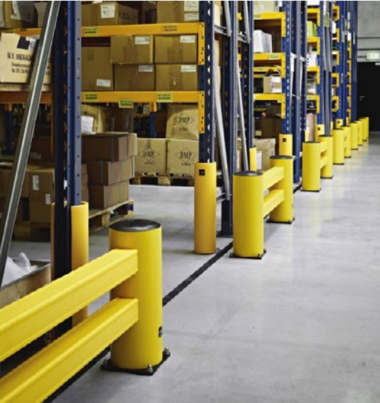
Abb. 44 Positivbeispiel eines Regals mit Anfahrtschutz
