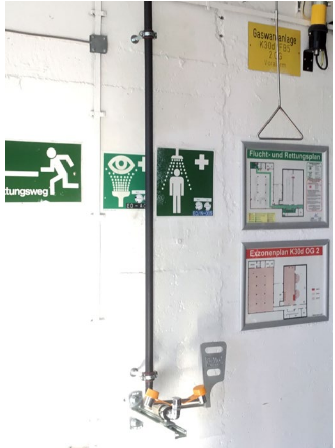
Abb. 5 Körper- und Augennotdusche
