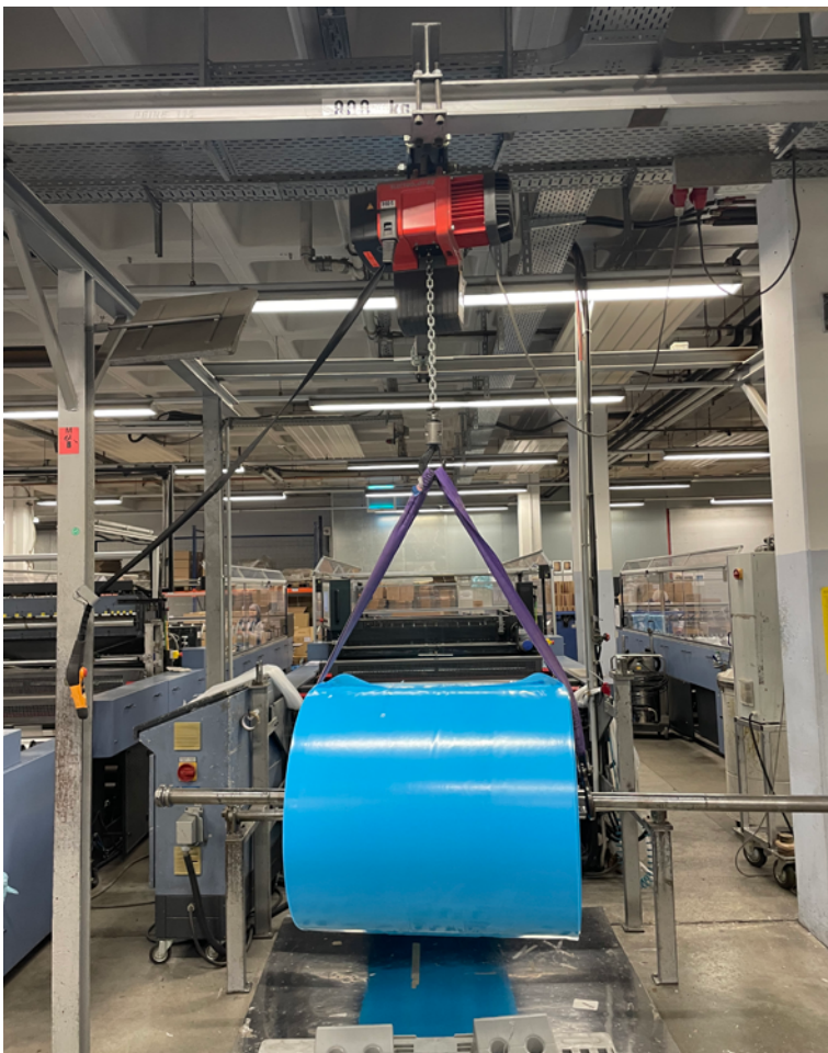
Abb. 65 Krananlage in einer Folienfertigung
