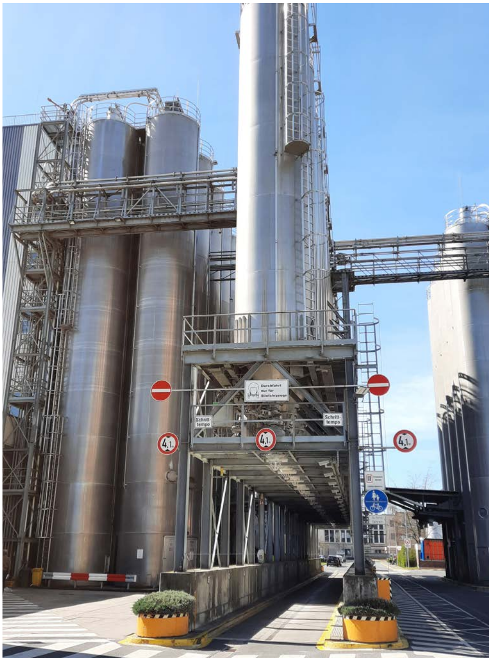
Abb. 68 Silos für Kunststoffgranulat
