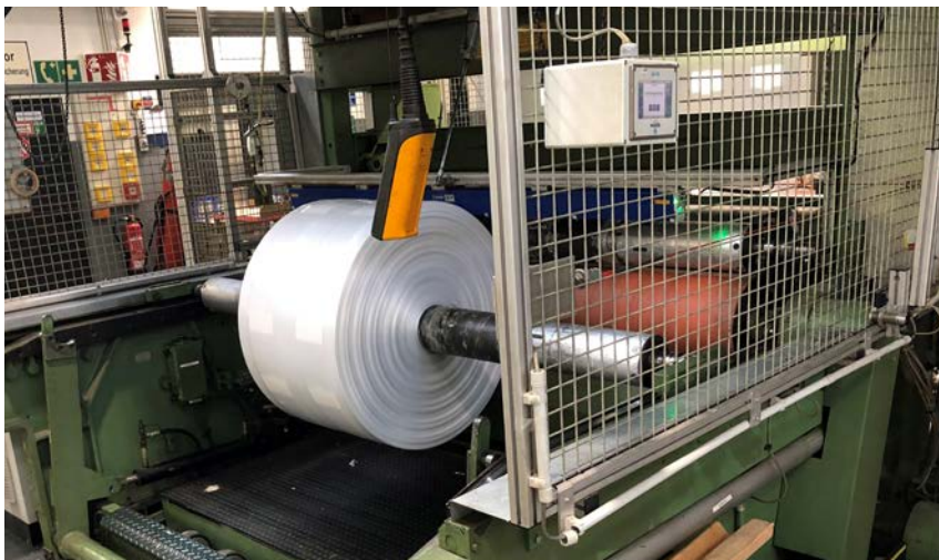
Abb. 38 Kontaktwickler mit nachgerüstetem Schutzgitter
