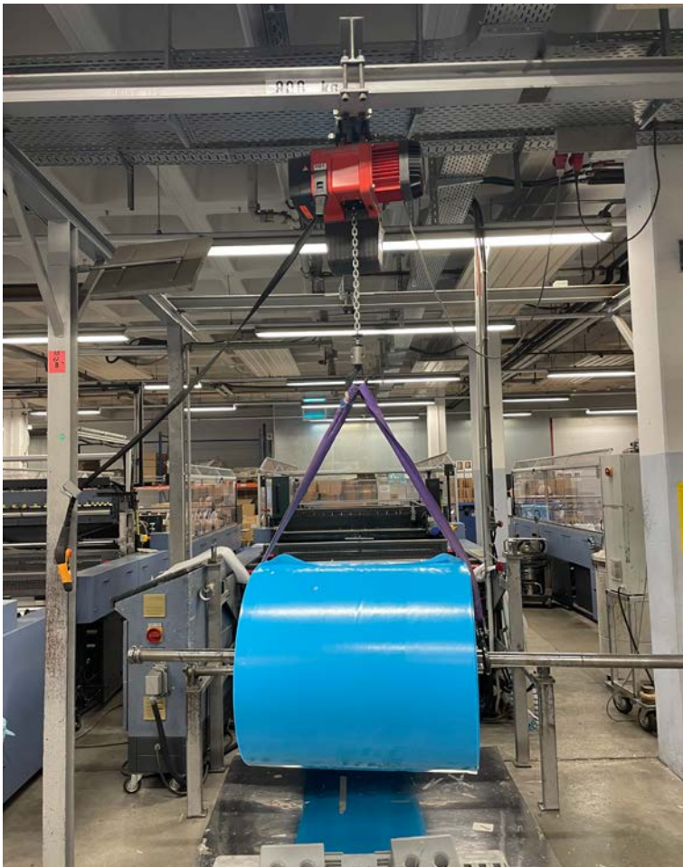
Abb. 65 Krananlage in einer Folienfertigung
