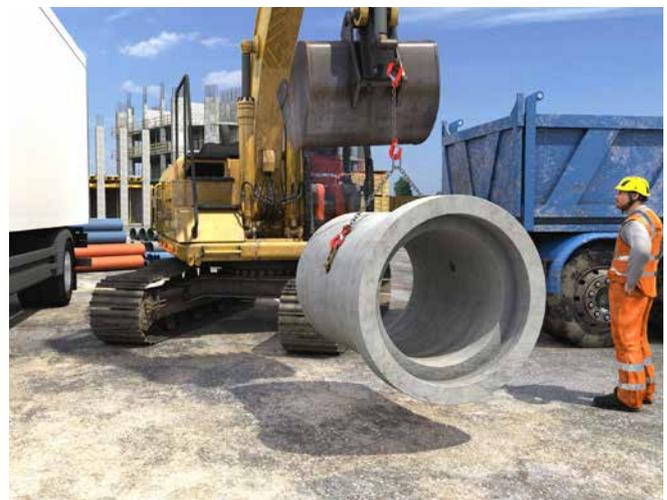
Abb. 88 Transport einer formschlüssig angeschlagenen Last
