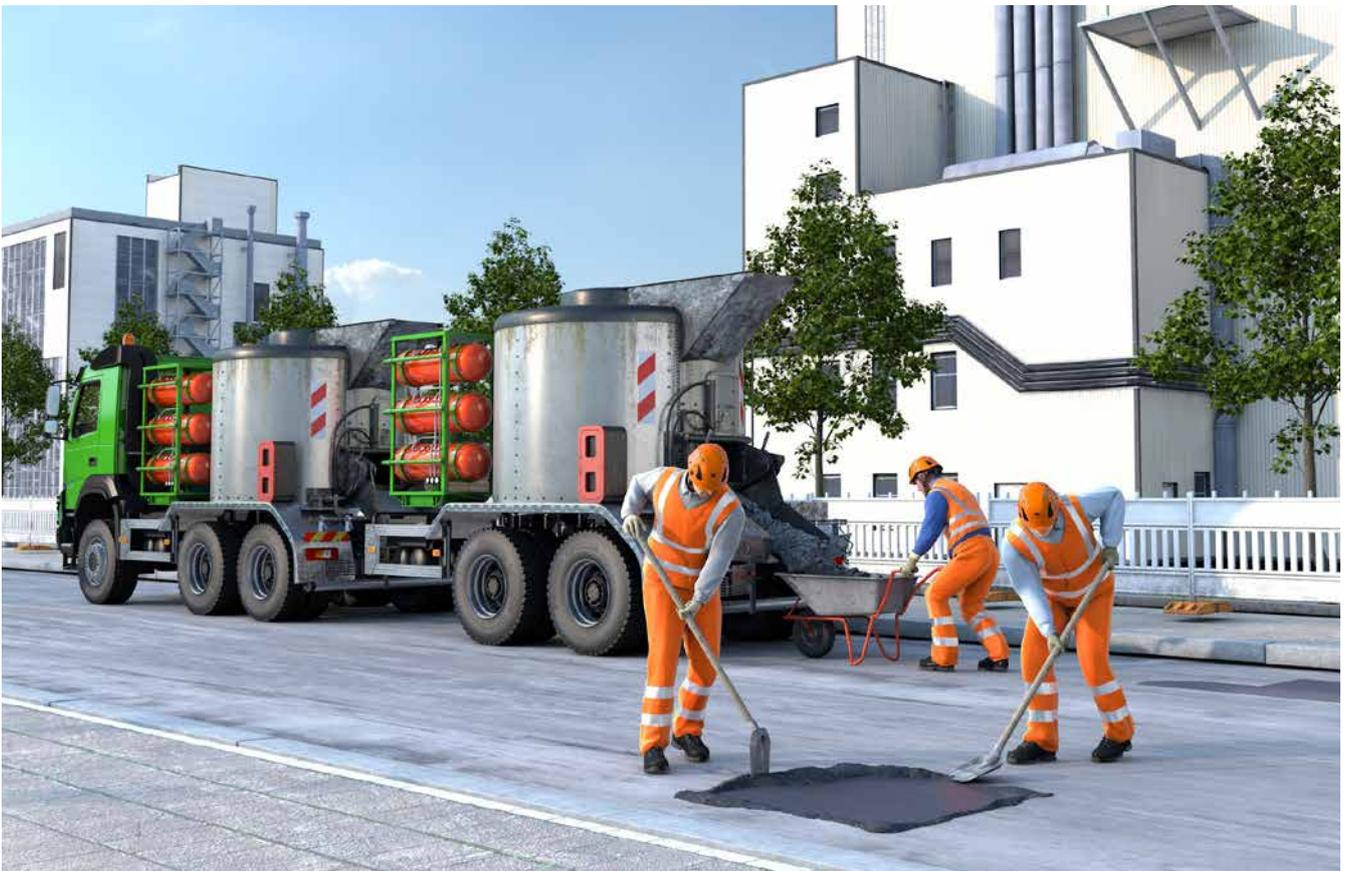
Abb. 34 Arbeiten mit einem gasbetriebenen Asphaltkocher
