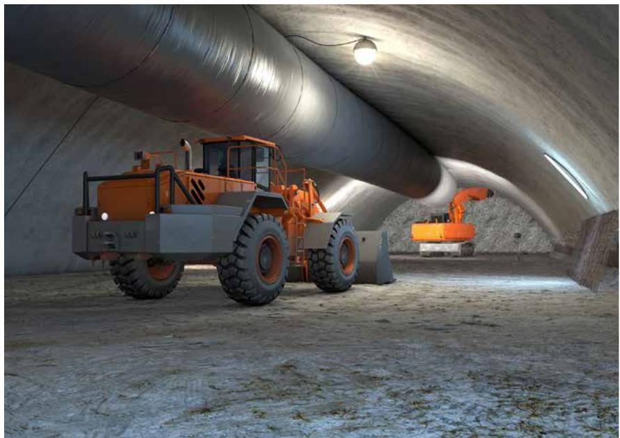
Abb. 139 Belüftung im Kalottenvortrieb
