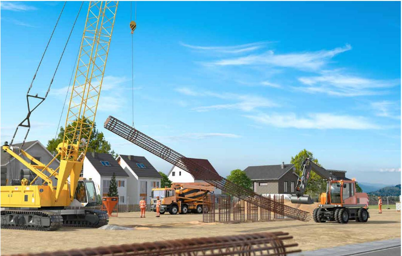
Abb. 126 Heben eines Bewehrungskorbes
