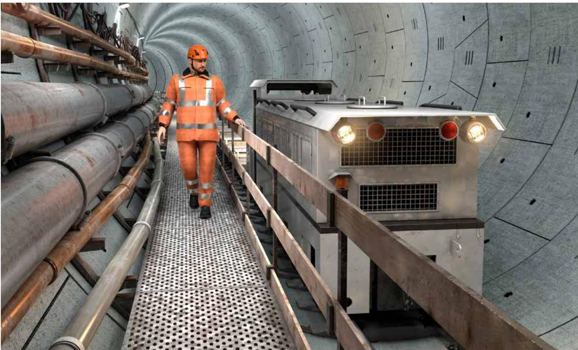
Abb. 136 Trennung von Fahr- und Fußweg
