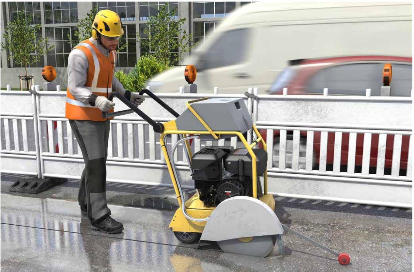
Abb. 12 Staubminimierung durch Nassschneiden
