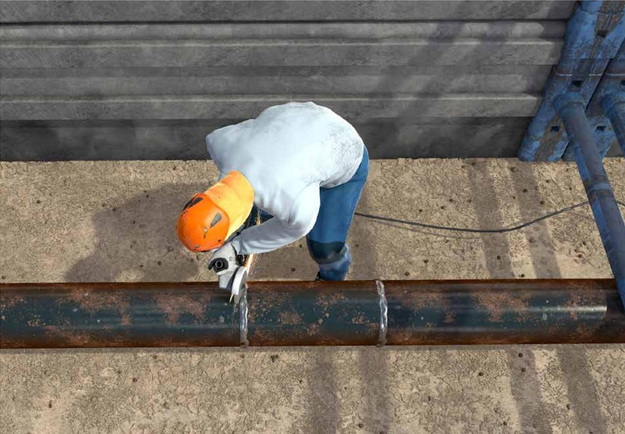
Abb. 40 Persönliche Schutzausrüstungen bei Arbeiten mit dem Winkelschleifer
