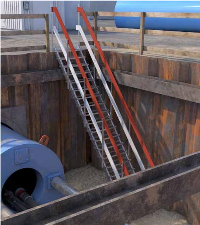
Abb. 5 Treppe als Zugang zur Baugrube
