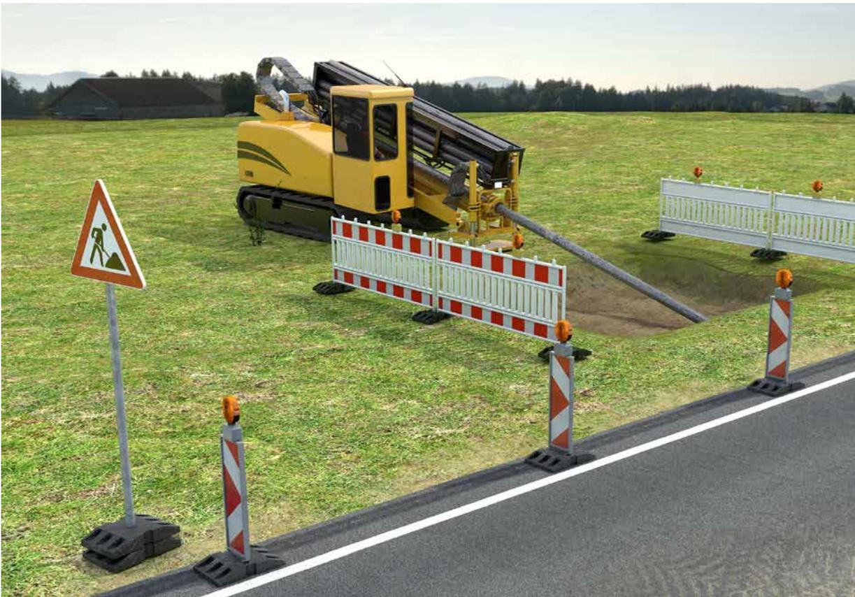
Abb. 134 Horizontalspülbohranlage
