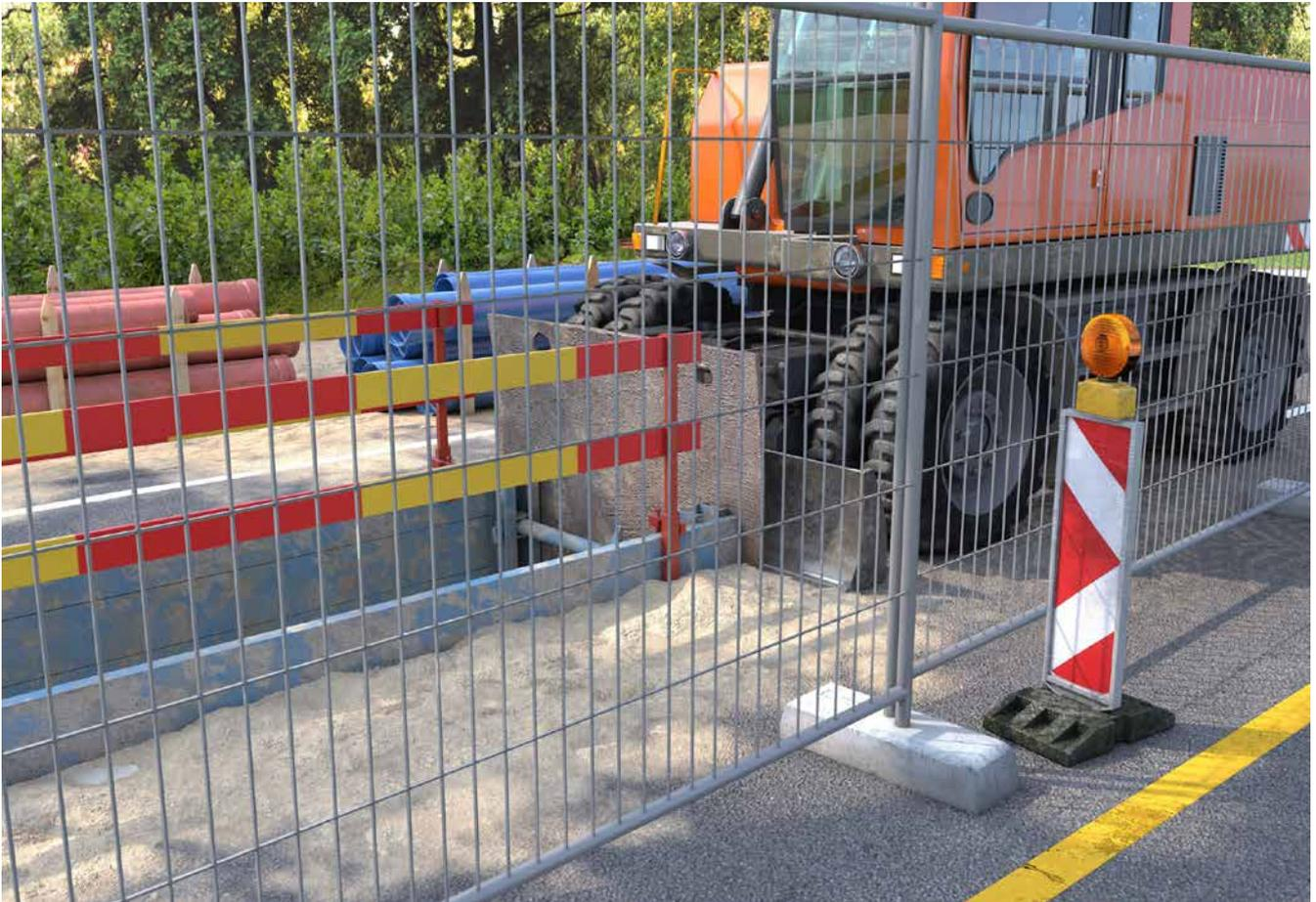
Abb. 109 Sicherung der Stirnseite des Verbaus
