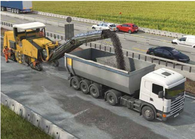
Abb. 102 Großfräse mit Absaugung
