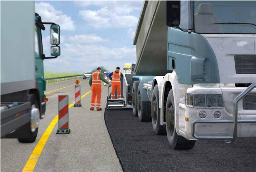
Abb. 8 Absicherung durch Leitbaken
