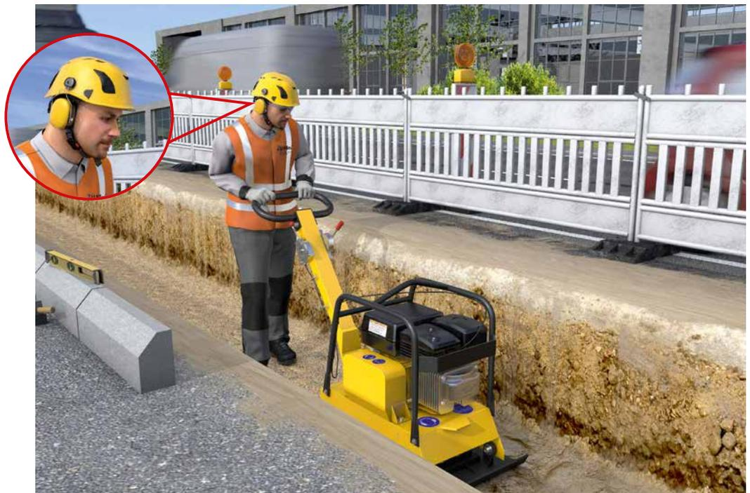
Abb. 54 Verdichtungsarbeiten mit geeignetem Gehörschutz
