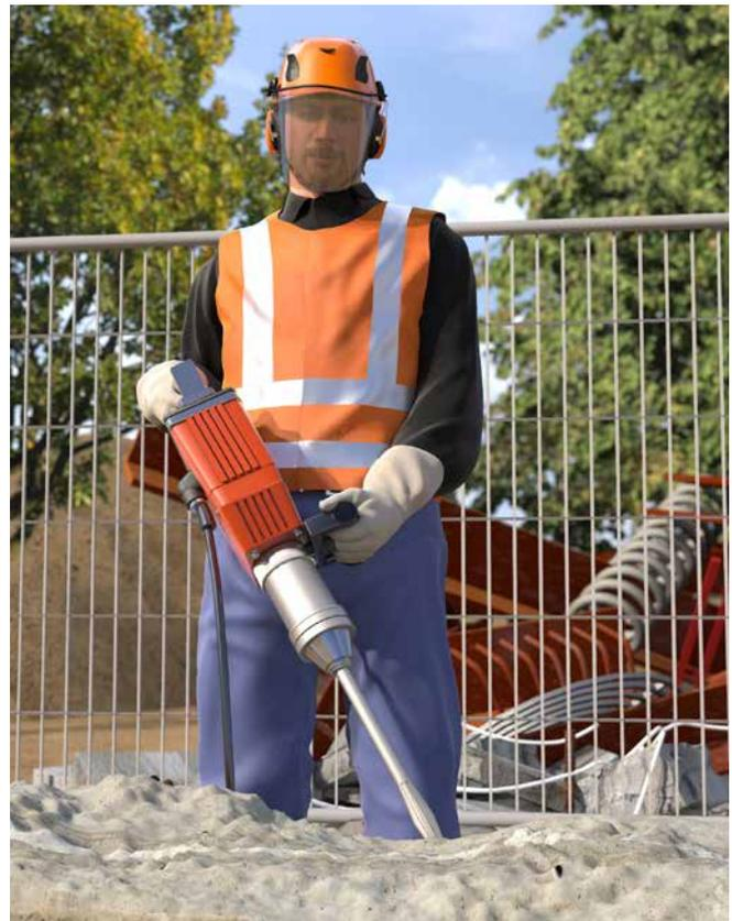
Abb. 44 Persönliche Schutzausrüstungen bei Arbeiten mit dem Stemmhammer
