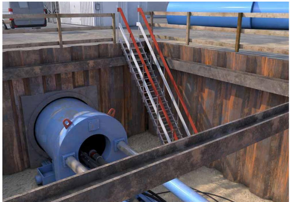
Abb. 135 Unbemannte Rohrvortriebsarbeiten, Baugrube mit Treppenzugang
