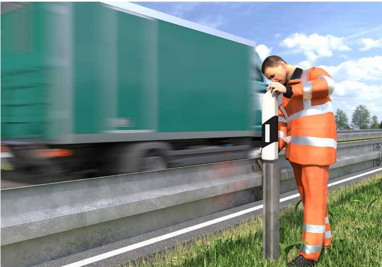
Abb. 9 Warnkleidung Klasse 3 (bei erhöhter Gefährdung)
