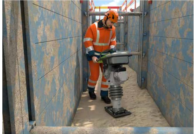
Abb. 93 Verdichtungsarbeiten mit einem Akku betriebenen Stampfer
