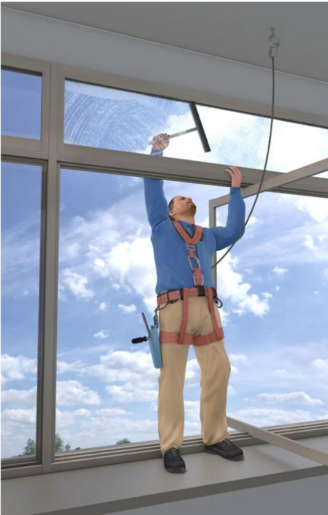
Abb. 1 Einsatz von PSAgA bei Fensterreinigung
