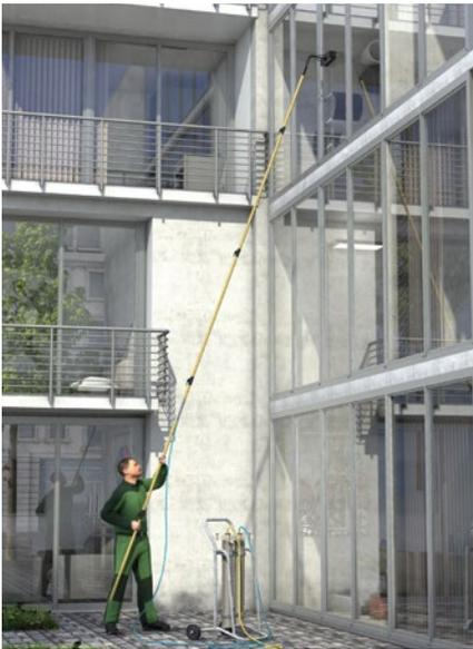
Abb. 63 Reinigen mit entmineralisiertem Wasser
