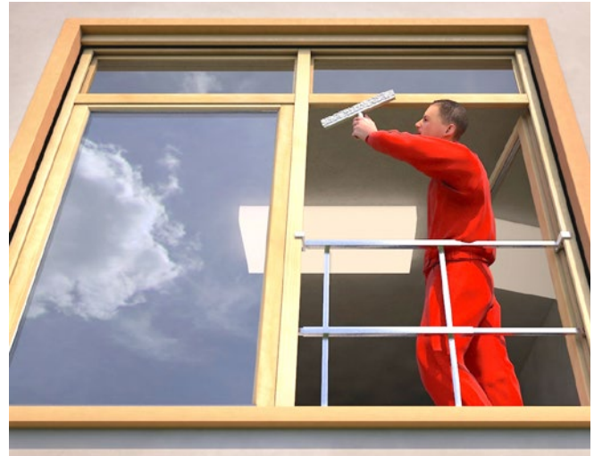
Abb. 3 Mobiles Schutzgeländer in Fensterrahmen
