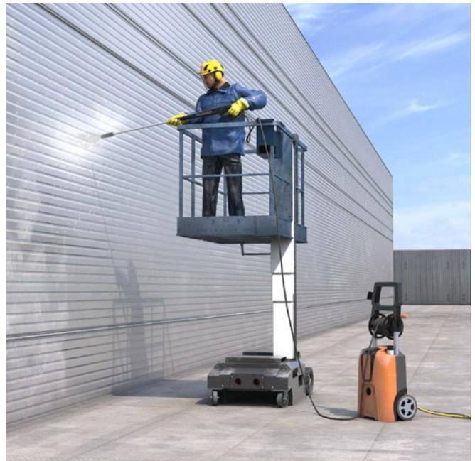
Abb. 61 Hochdruckreinigen
