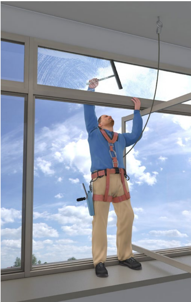
Abb. 1 Einsatz von PSAgA bei Fensterreinigung
