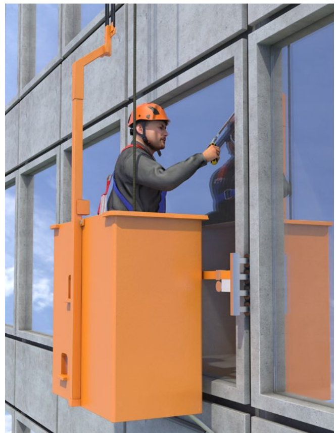
Abb. 62 Fassadenreinigung mit Fassadenbefahranlage
