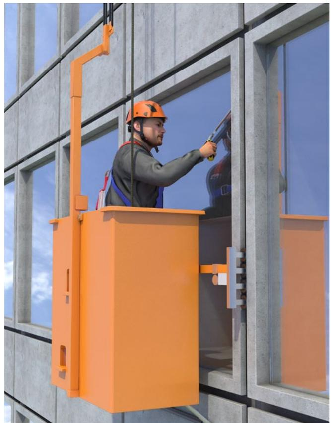
Abb. 62 Fassadenreinigung mit Fassadenbefahranlage
