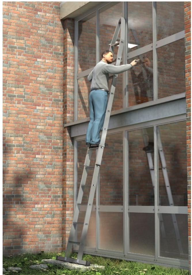
Abb. 46 Glasreinigerleiter mit Fußverbreiterung auf tragfähigen Untergrund
