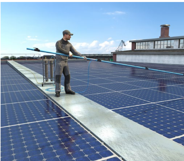
Abb. 16 Reinigung von Photovoltaikanlagen mit entmineralisiertem Wasser
