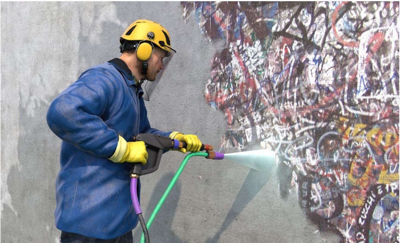
Abb. 30 PSA bei Hochdruckreinigung
