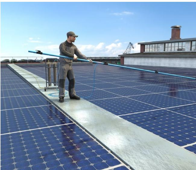
Abb. 16 Reinigung von Photovoltaikanlagen mit entmineralisiertem Wasser
