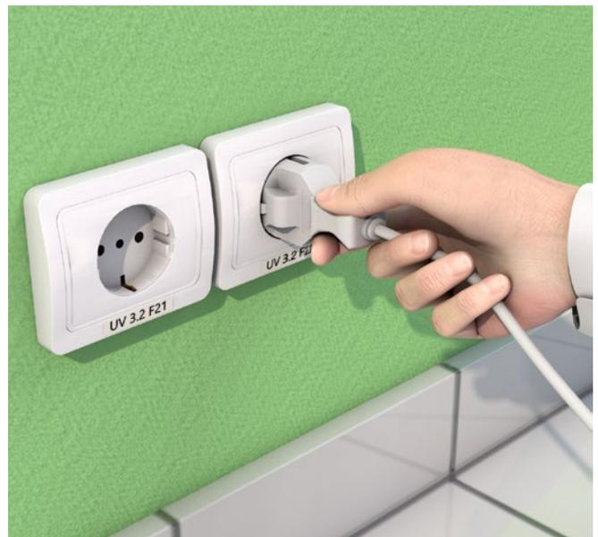
Abb. 17 Richtiges Ziehen des Steckers
