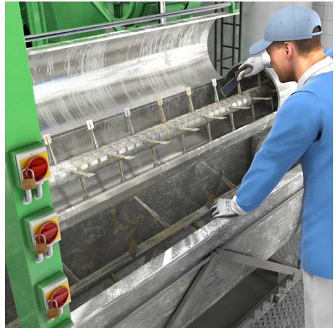
Abb. 73 Anlage gegen Einschalten gesichert
