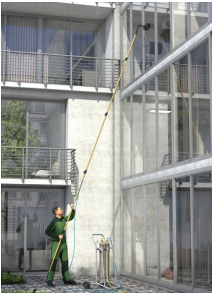
Abb. 63 Reinigen mit entmineralisiertem Wasser
