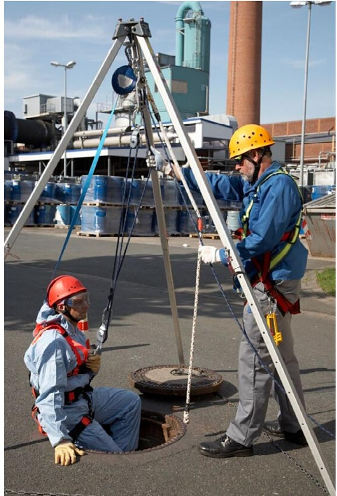
Abb. 9-4 Einstieg in einen Kanal mit erforderlicher Schutzausrüstung
