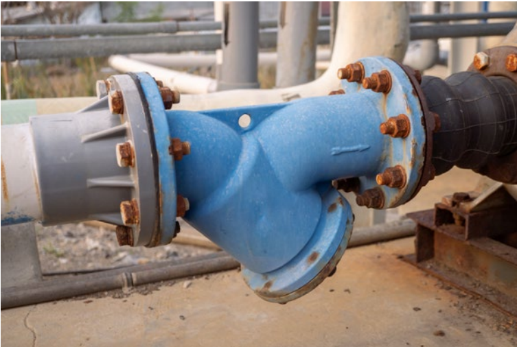
Abb. 15 Schmutzfänger zur Filterung eines Fluids (Stock Adobe)
