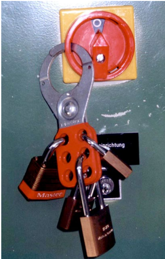
Abb. 12 Mehrfachschließbügel im Einsatz (BGHM)
