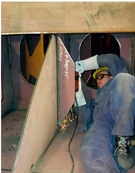
Abb. 9-1 Enger Raum mit erhöhter elektrischer Gefährdung
