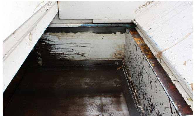
Abb. 3 Presskammer einer mobilen Behälterpresse mit horizontalem Pressschild
