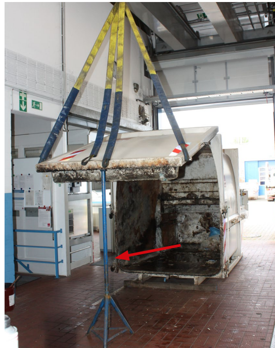
Abb. 27 Sicherung einer angehobenen Entladungstür
