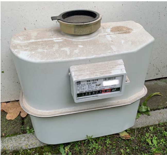
Abb. 42 Verschluss ausgebauter Gaszähler
