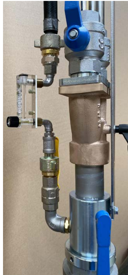
Abb. 31 Beispiel Schwebekörperdurchflussmessgerät zur Kontrolle der Schleichgasmenge
