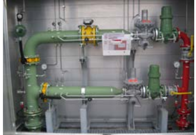
Abb. 15 GDRM-Schrankanlage
