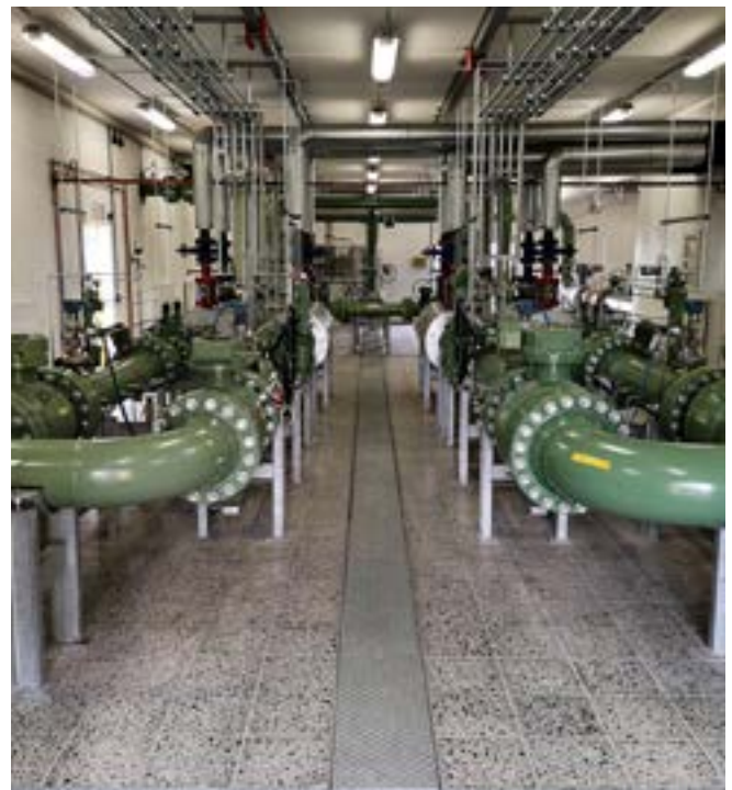
Abb. 40 Betonwerkstein-Platten in einer GDRM-Anlage
