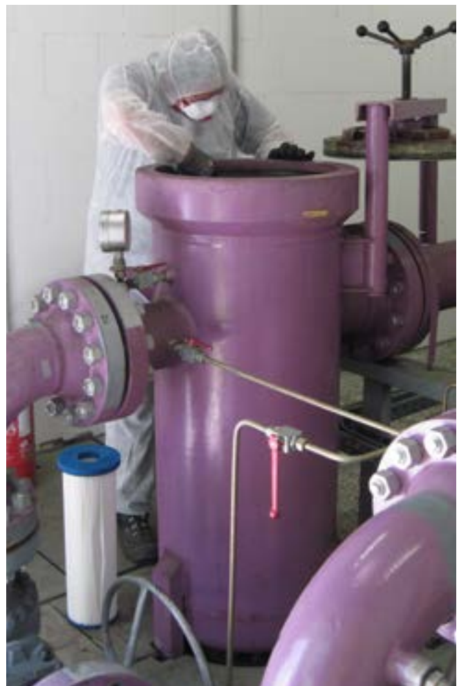
Abb. 6 Filterwechsel an einer GDRM-Anlage, Mitarbeiter trägt Einwegschutzanzug und Staubmaske
