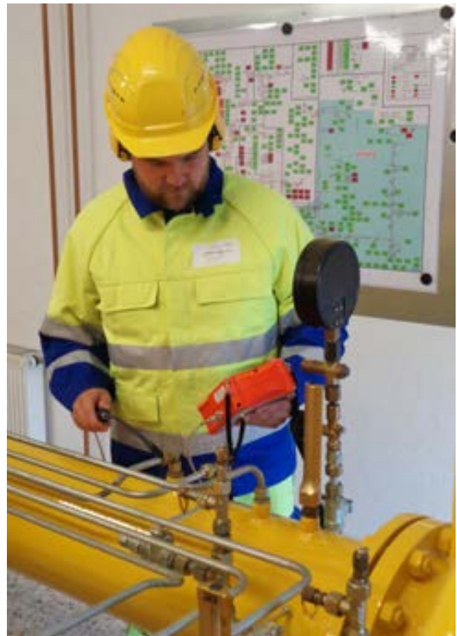
Abb. 28 Dichtheitskontrolle bei der Funktionsprüfung an einer GDRM-Anlage.
