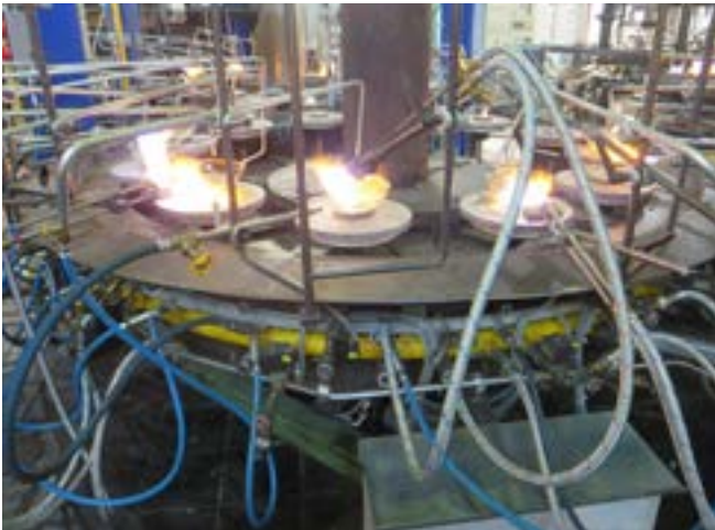
Abb. 25 Brenner an einer Anlage zum Flammenpolieren, die mit Brennstoff-Luft-Gemisch betrieben wird.
