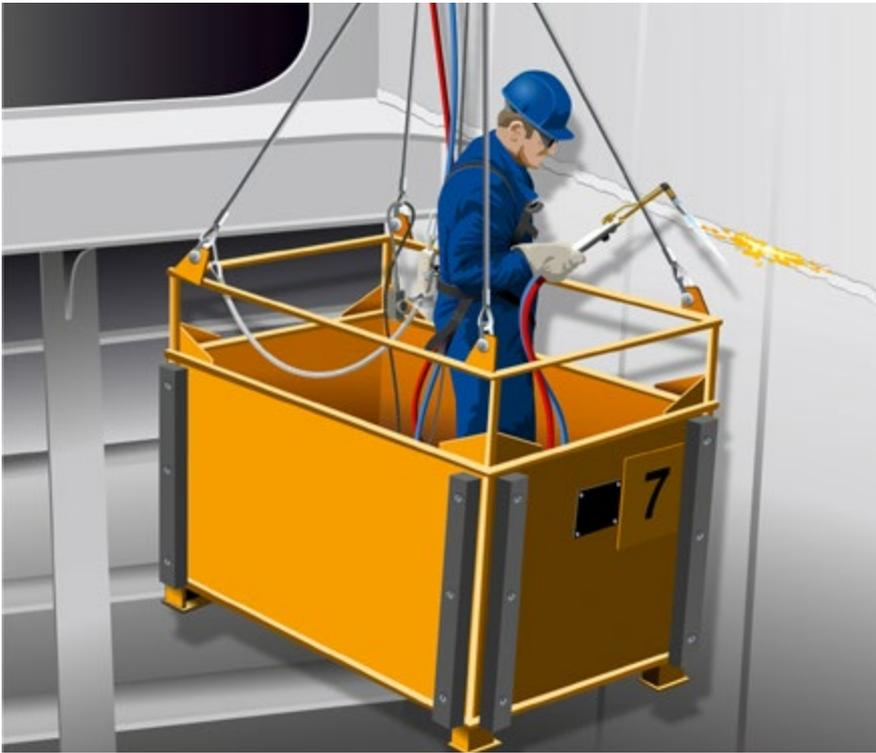
Abb. 35 Brennarbeiten im Laderaum mit Hilfe eines Arbeitskorbs
