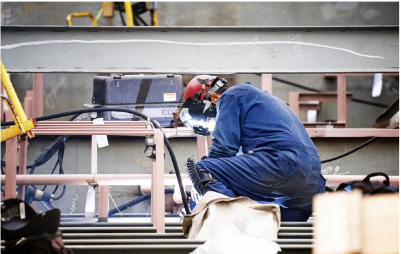
Abb. 22 Kniende Haltung bei Schweißarbeiten
