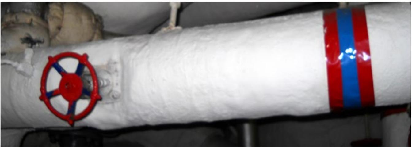
Abb.57 Rohrleitung mit asbesthaltiger Isolierung
