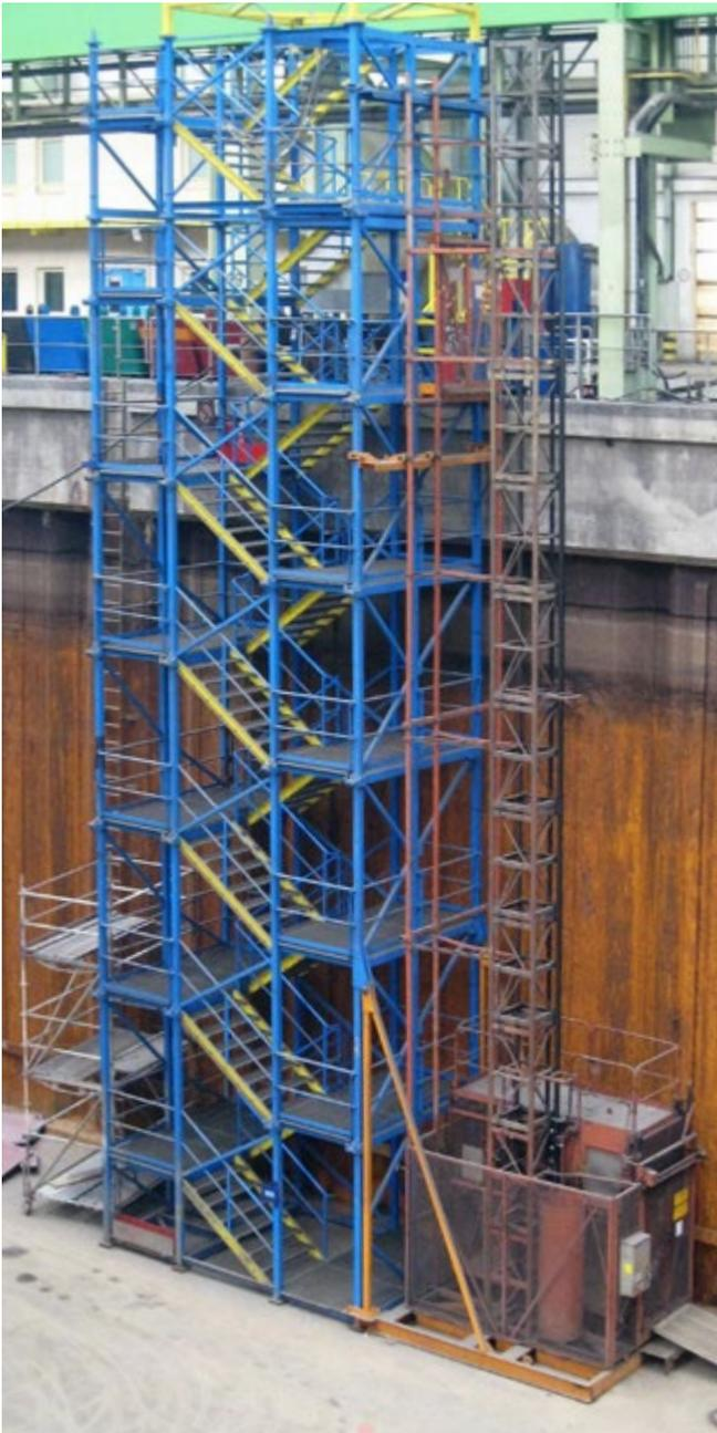
Abb. 32 Kranverlastbarer Treppenturm mit Aufzug im Dock
