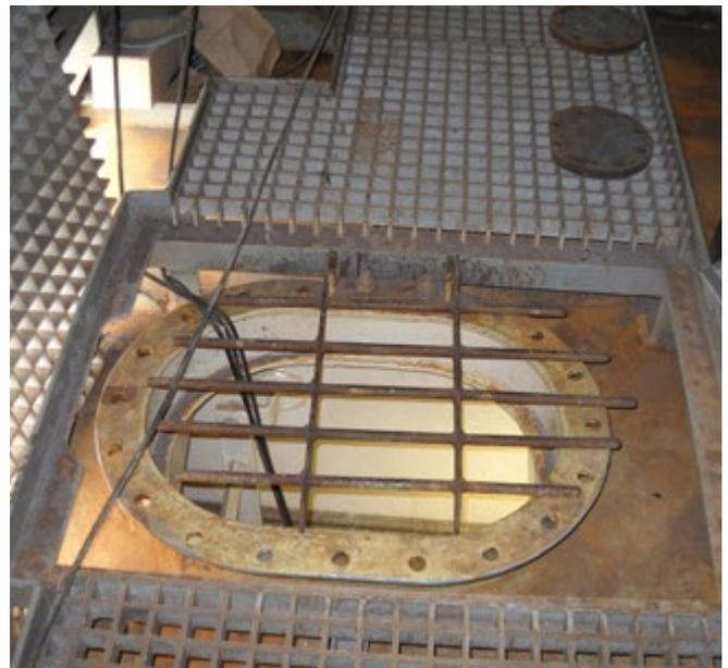
Abb. 25 Klappbare Mannlochsicherung
