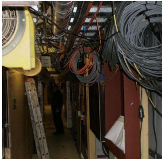
Abb. 13 Hochgehängte Kabel in einem Verkehrsweg an Bord
