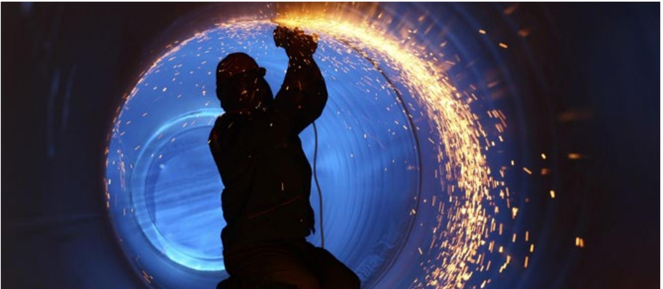
Abb. 50 Schleifarbeiten in einer Rohrleitung
