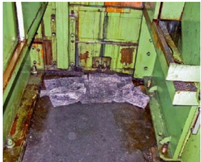
Abb. 4 Erhöhte Brandlast durch ölgetränkte Putztücher
