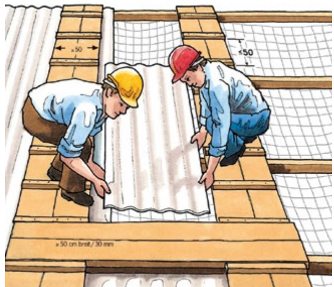
Abb. 3.5.2-04 Dachdeckung mit Wellplatten
