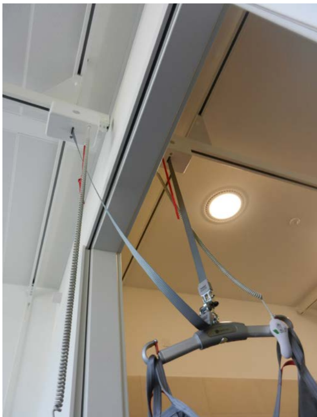
Bild 5 Deckenliftsystem mit Umhängemöglichkeit des Liftertuches am Türsturz
