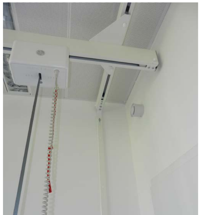
Bild 3 Portalmontage eines Patienten-Deckenlifters
