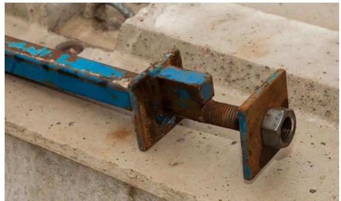
Abb. 20: Schraubarretierung mit zusätzlicher Verdrehsicherung
