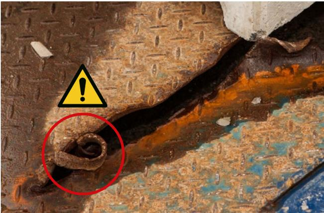
Abb. 27: Stich-, Schnitt- und Stolperstelle an aufgerissenem IP-Boden
