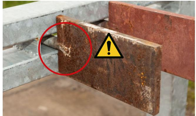
Abb. 19: Ungeeignete Schraubarretierung: unterdimensionierter Führungsschaft, keine Verdrehsicherung, zu kleine Auflageflächen
