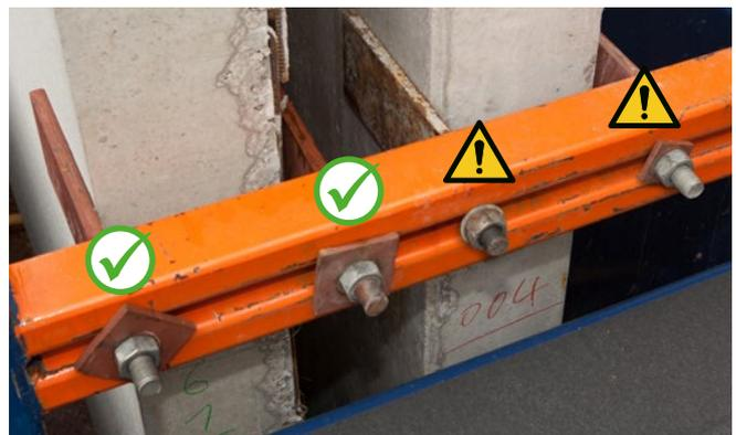
Abb. 18: Nur die beiden linken Arretierungselemente haben eine ausreichende Auflagefläche
