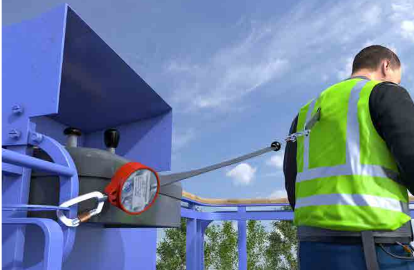
Abb. 121 PSAgA im Arbeitskorb
